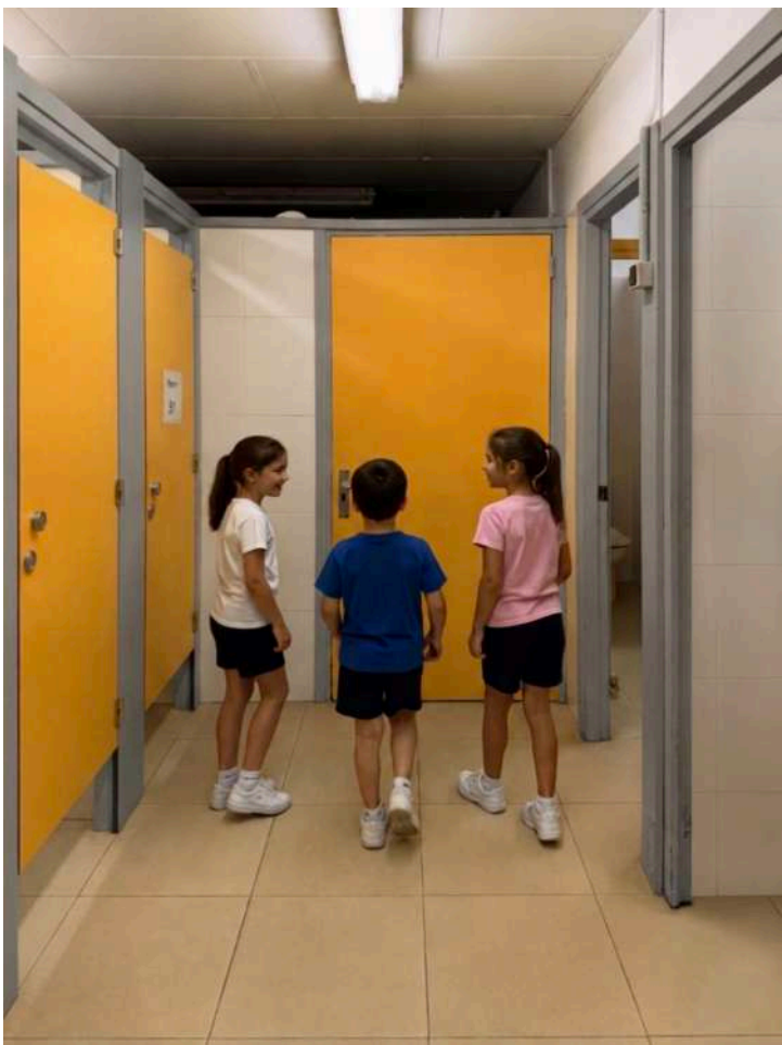
IMATGE 03 ▶ A banys i vestidors es desmunten els bastidors i tapetes de DM i se substitueixen per un conjunt de xapes d'inox i panells fenòlics d'alta densitat.
