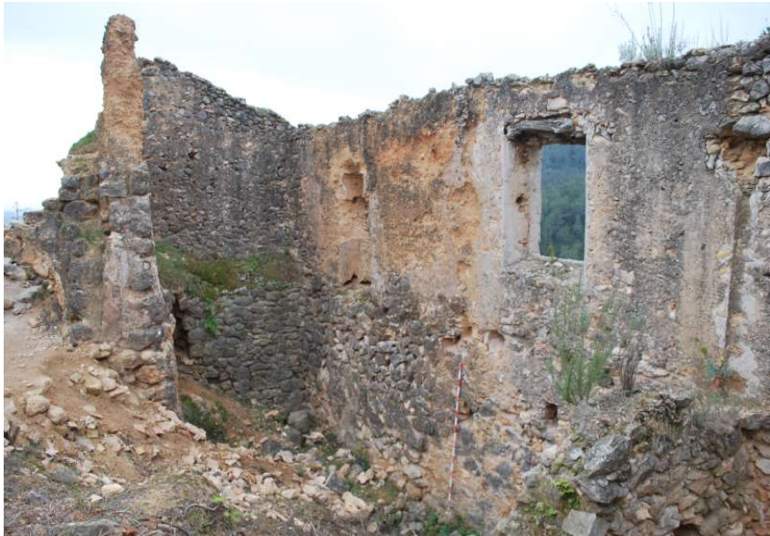
Vista des del nord de l'espai meridional del cos oest (J. Gibert).
