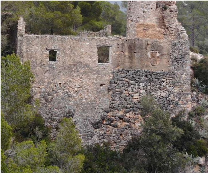
Detall del mur M8 on s'observa clarament el trencament en l'obra de sòcol i tàpia i la refecció dels dos terços septentrionals amb maçoneria ( Arqueòlegs.cat ).
