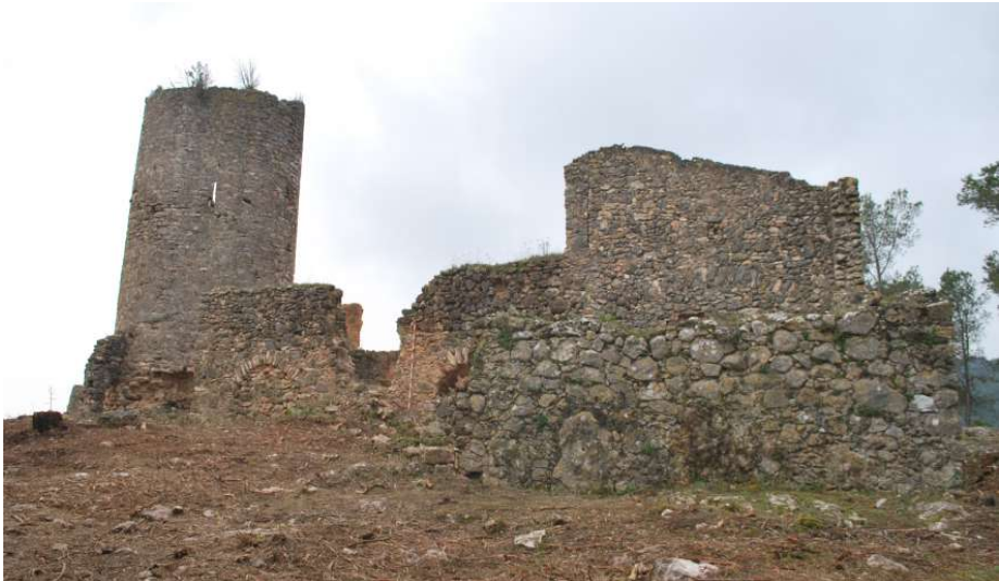
Alçat del mas present en el plànol de Cal Noia i fotografia des del nord/nord-est del conjunt; es poden identificar aproximadament els diversos cossos i elements arquitectònics, especialment la torre i el Cos est.
