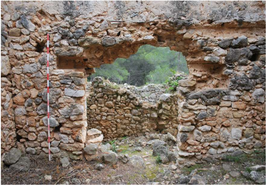
Detall de la porta de llevant de l'àmbit 1, amb l'encaix de la llinda desapareguda; al fons, l'àmbit 4 (J. Gibert).
