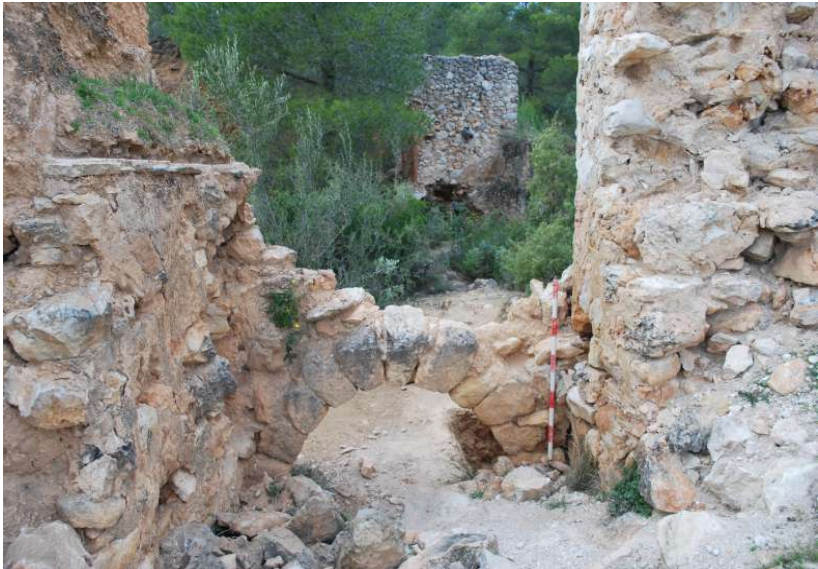
Vista des del sud de l’arcada M5 entre la torre i el cos oest del mas (J. Gibert).
