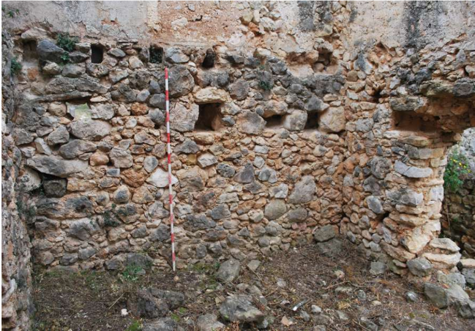
Detall del mur septentrional de l'àmbit 1, amb els encaixos per a l'embigat del pis i, per sota, altres encaixos d'ús no definit (J. Gibert).
