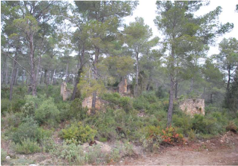
Vista des del sud de les restes de la Casa del Corral, totalment emboscades (J. Gibert).
