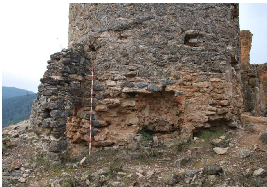
Vista de M2 adossat a la torre i de l'empremta d'una teulada; s'observa també el gran esvoranc en el parament de la base de la torre (J. Gibert).
