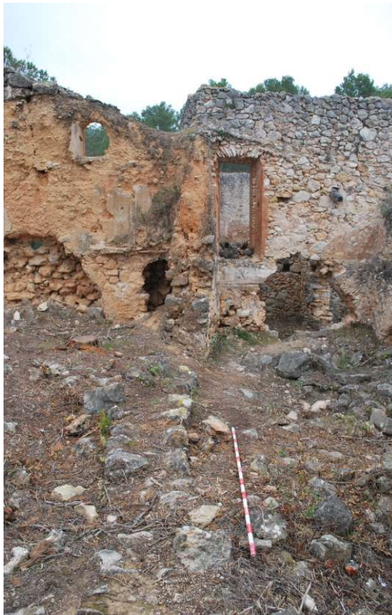
Vista des del sud del mur M10, pràcticament arranat i que aflora entre l'enderroc; només al fons, a tocar del mur M9, es conserva en alçat (J. Gibert).
