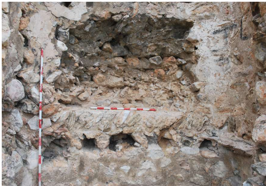
Vista des del sud de l'embigat i, a la dreta, l'arrencament del paviment pertanyents al pis construït amb posterioritat a l'aixecament de la torre; per sobre, un gran esvoranc s'obre a la cara interna del mur nord (J. Gibert).
