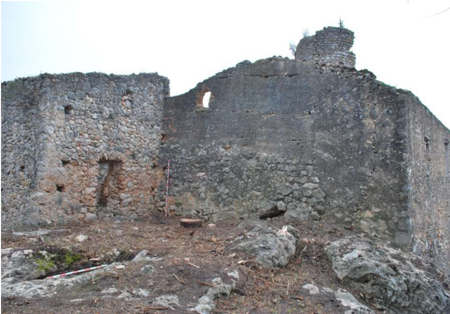
A l'esquerra, l'àmbit 1 del Cos est amb la porta d'accés des de l'era; a la dreta, la façana septentrional (mur M9) del Cos oest (J. Gibert).
