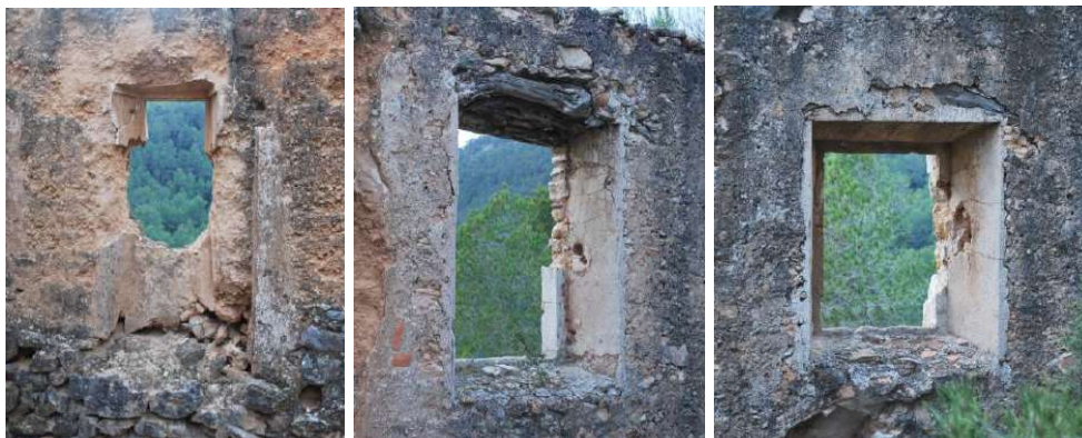
Detall de les finestres sud, central i nord obertes en el mur M8 (J. Gibert).
