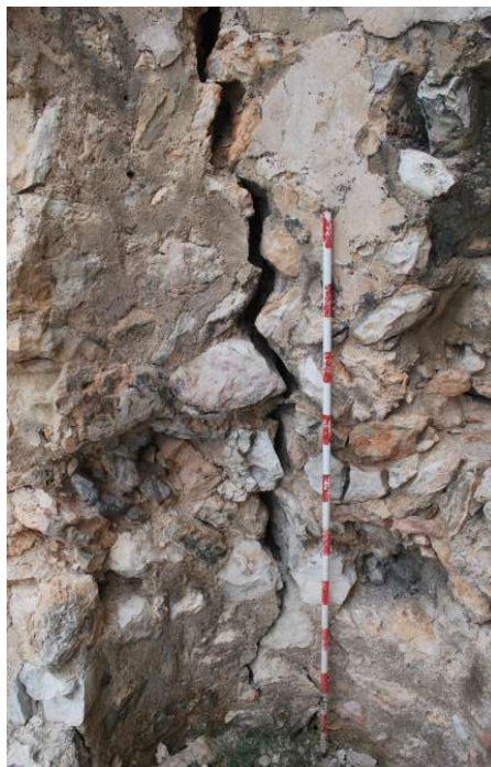
Vista des de l'interior de la torre de la gran esquerra que recorre l'edifici de dalt a baix pel cantó de ponent (J. Gibert).
