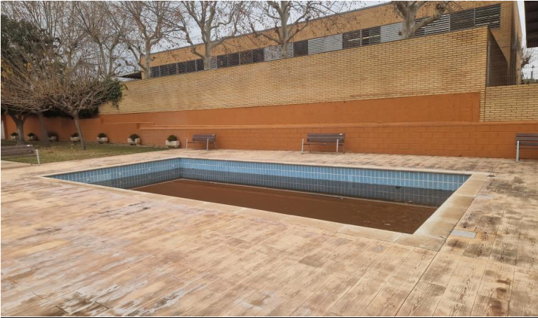
Estat actual de la piscina infantil
