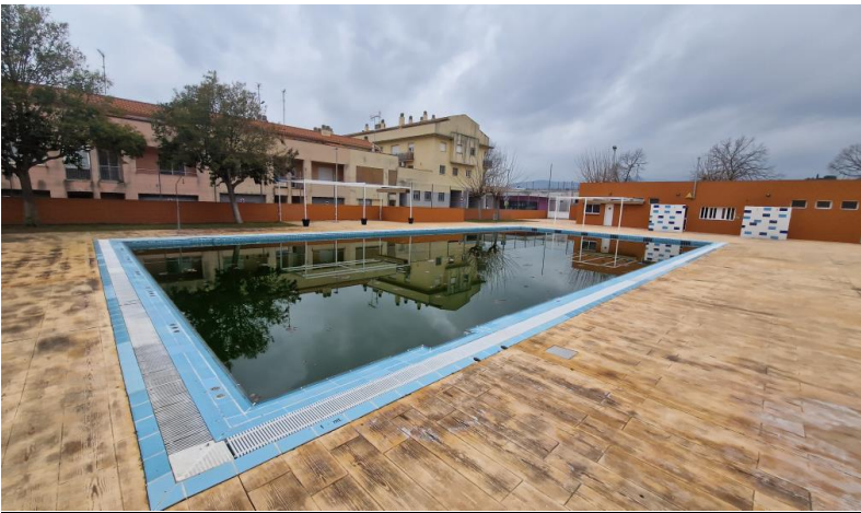
Estat actual de la piscina gran
