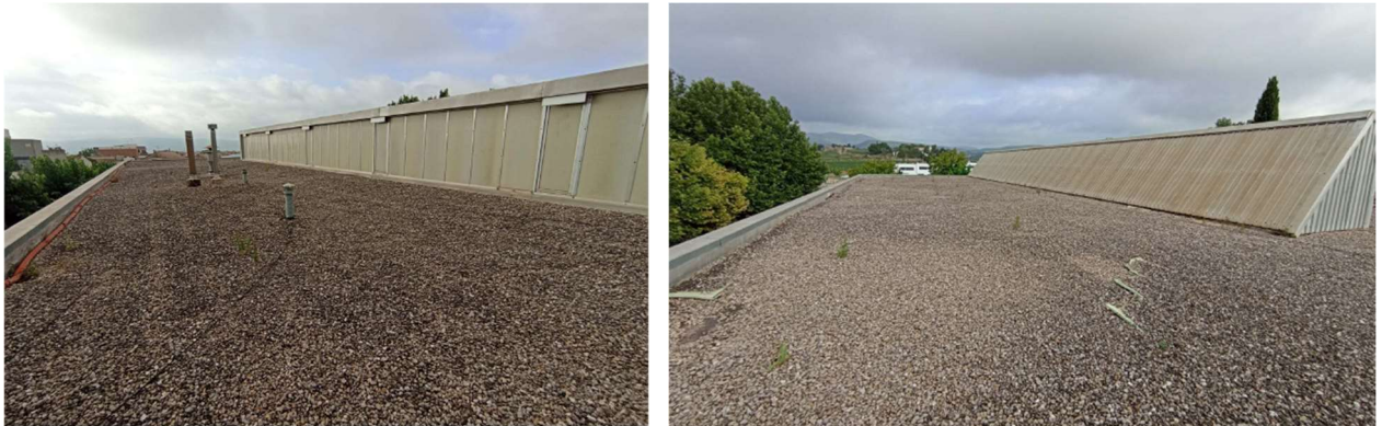
Figura 4 Imatges de la coberta de l'escola
