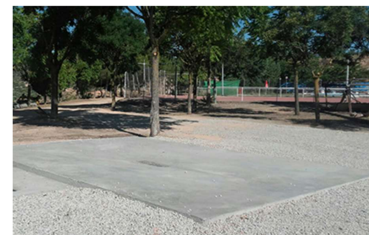
PAVIMENT DE FORMIGÓ ZONA DESGUÀS
