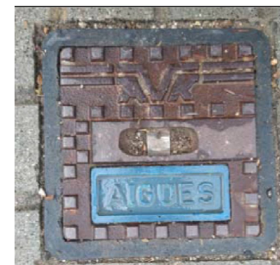
TAPES DE REGISTRE A INSTAL·LAR INICI DE TRAM I FINAL AMB CLAU DE PAS INSTAL·LACIÓ DE VENTOSA ALS PUNTS ALTS.
