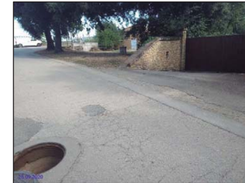
Punt final d'intersecció amb canonada. (Entrada Mas Cornell)
