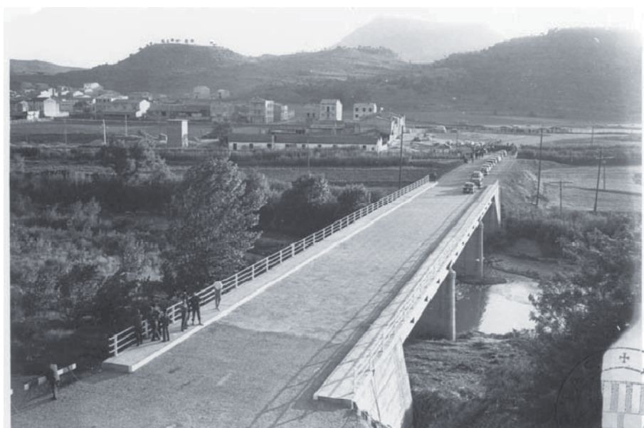
Pont de la carretera de Calaf, construït el 1965. (Font: Arxiu Comarcal del Bages).
