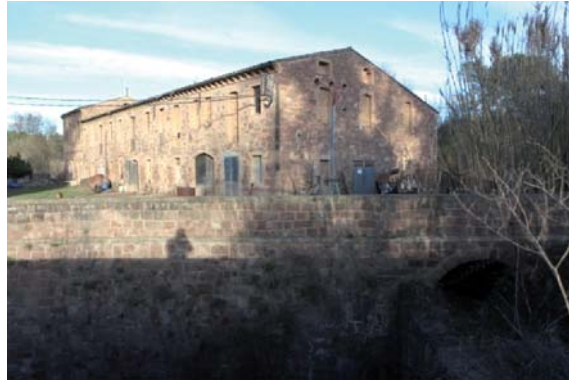
Foto 10. Façana oest del volum 3.
