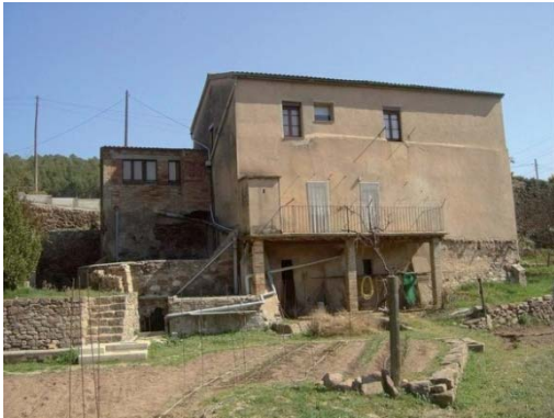
Foto 1. Façana oest del volum 1
