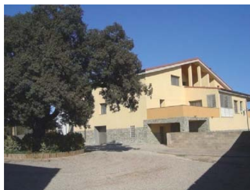
Foto 2. Façana sud - oest del volum 1.
