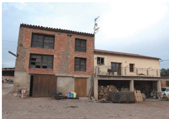
Foto 2. Façana sud dels volums 1 i 3.
