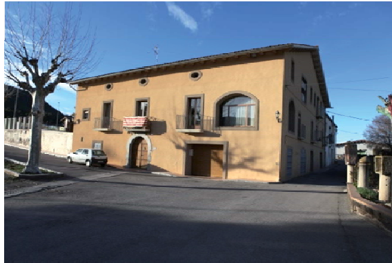
Foto 2. Façana sud del volum 1.
