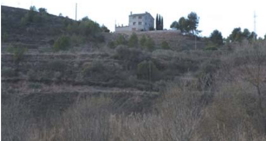
Foto 7. Façana est dels volums 1 i 2.
