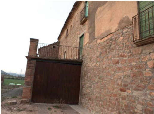
Foto 17. Façana oest del volum 1.
