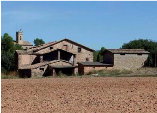
Foto 1. Façana sud dels volums 2, 3 i 1.
