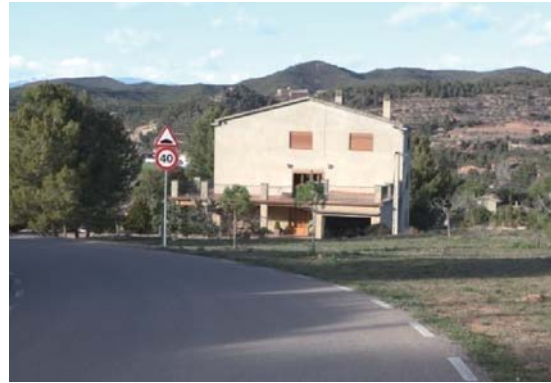
Foto 2. Façana sud dels volums 2 i 1.
