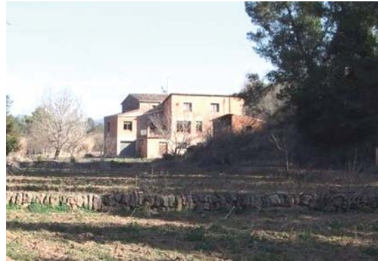
Foto 2. Façana sud del volum 1.
