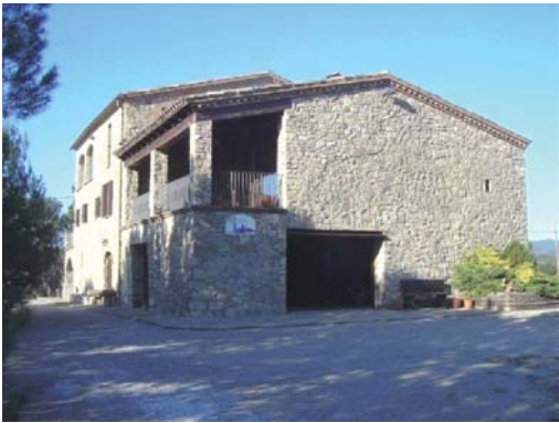
Foto 5. Façana est del volum 1.
