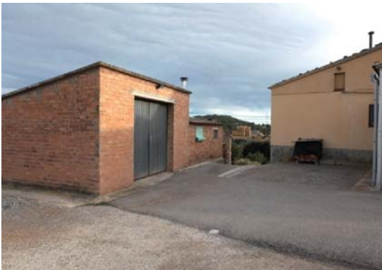
Foto 7. Façana nord dels volums 1 i 2.
