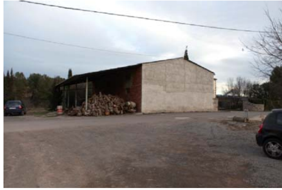
Foto 8. Façana oest del volum 2.
