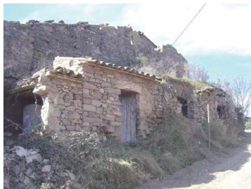
Foto 19. Façana nord - est del volum 2.
