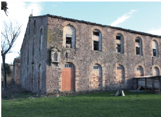
Foto 3. Façana nord - est del volum 1.
