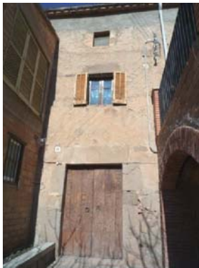
Foto 5. Façana sud del pati que forma l'entrada del volum 1.
