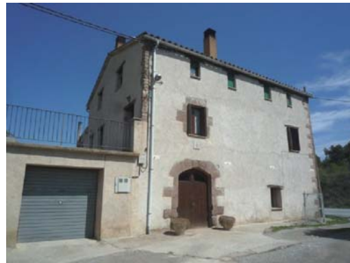
Foto 2. façana sud dels volums 2 i 1.
