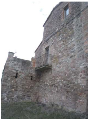
Foto 3. Façana nord del volum 1.
