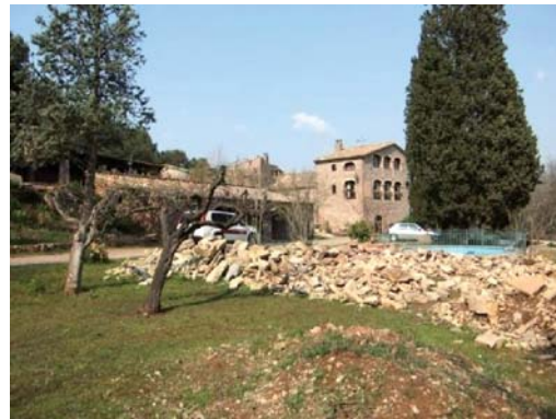
Foto 2. Façana sud dels volums 1 i 4
