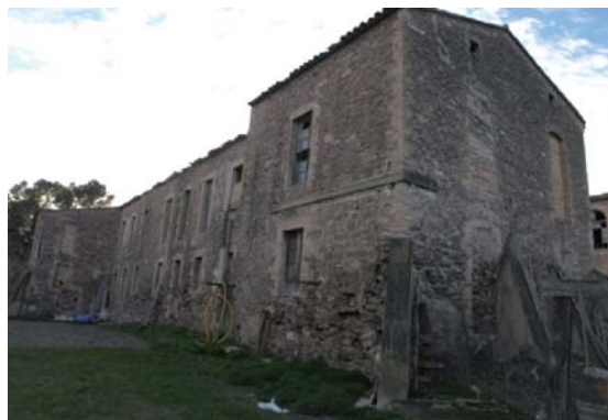
Foto 16. Façana nord - est del volum 3.
