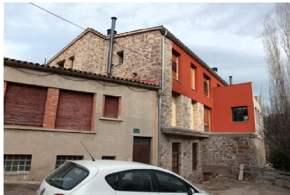
Foto 6. Façana sud del volum 1.
