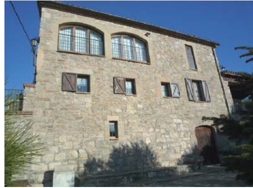
Foto 4. Façana sud del volum 1.
