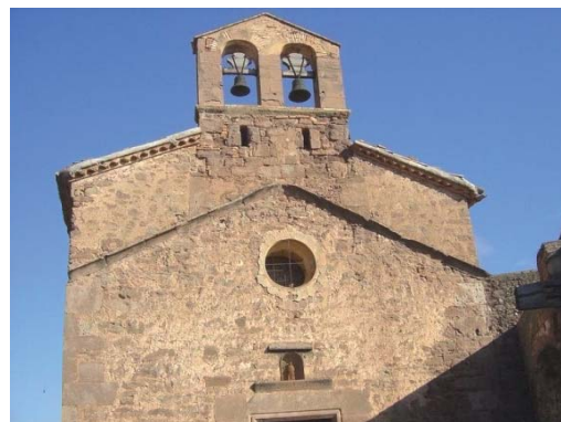
Foto 8. Façana sud - oest del volum 2.
