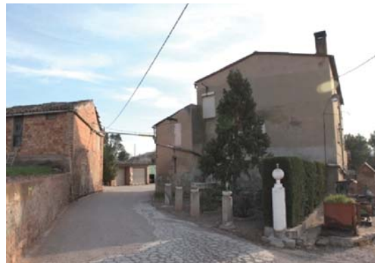
Foto 6. Façana nord - est dels volums 1 i 2.
