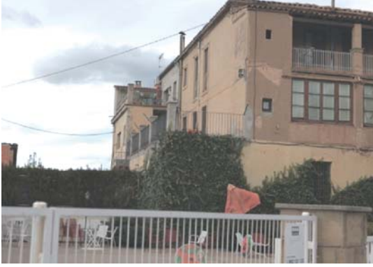
Foto 7. Façana sud del volum 1.
