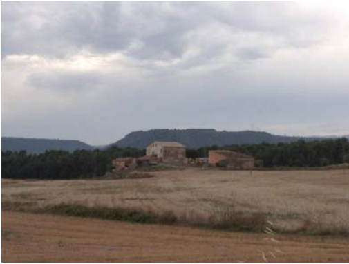
Foto 9. Façana est del volum 1.
