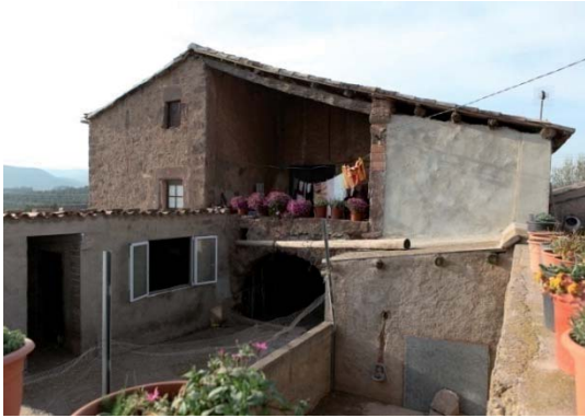
Foto 3. Façana sud del volum 1.
