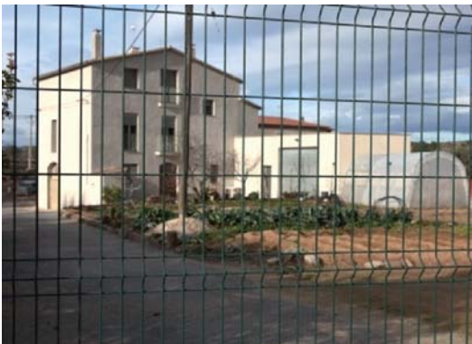
Foto 3. Façana sud dels volums 1 i 2.
