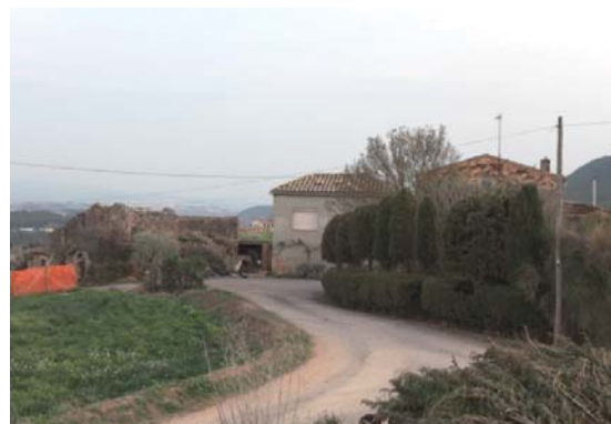
Foto 22. Façana nord dels volums 1 i 2.
