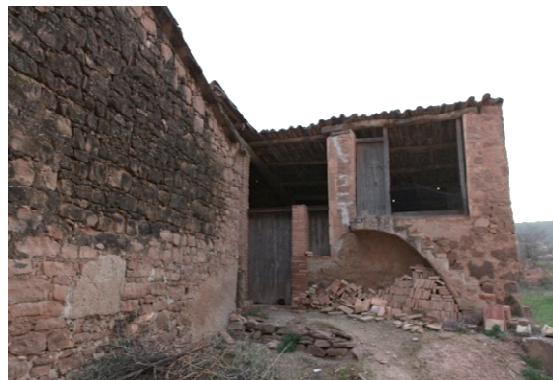
Foto 14. Façana est del volum 3.
