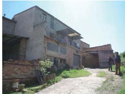
Foto 2. Façana oest dels volums 1 i 2.
