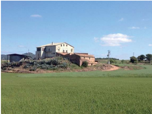
Foto 1. Façana sud del volum 1.
