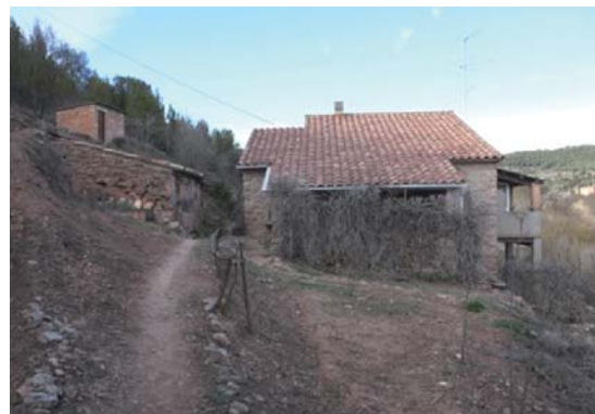
Foto 4. Façana sud dels volums 1 i 2.
