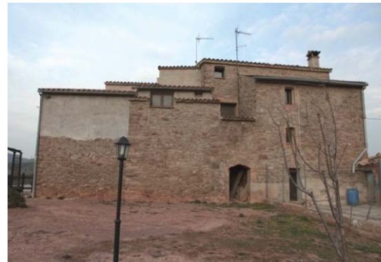
Foto 6. Façana oest del volum 1.
