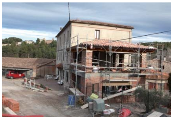
Foto 2. Façana oest del volum 1.
