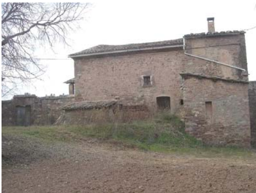
Foto 7. Façana est del volum 1.
