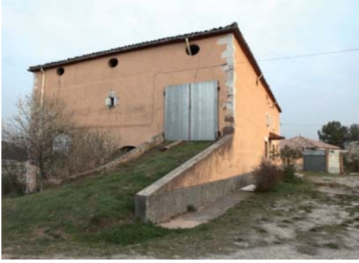
Foto 13. Façana nord del volum 1.
