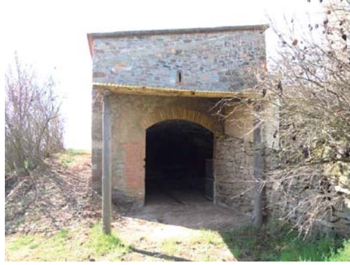
Foto 14. Façana nord del volum 2.
