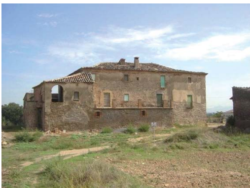
Foto 5. Façana oest del volum 1.
