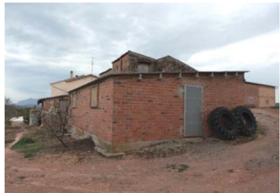
Foto 6. Façana nord - est del volum 2.
