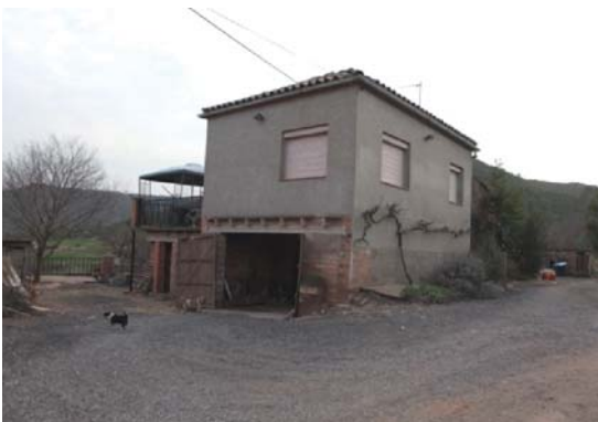
Foto 5. Façana nord - est del volum 1.
