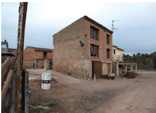
Foto 3. Façana sud - oest del volum 3.
