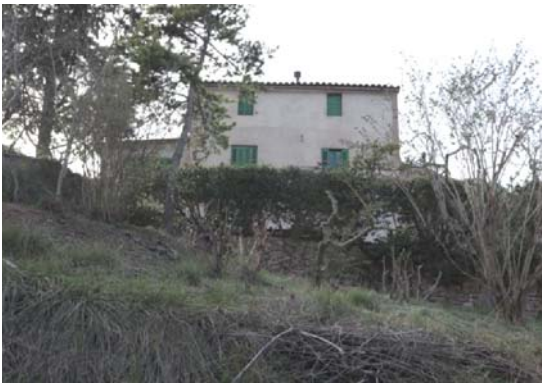
Foto 5. Façana est del volum 1.
