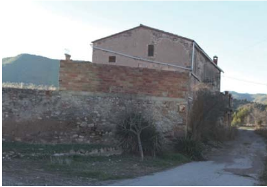
Foto 7. Façana est del volum 1.
