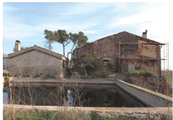
Foto 8. Façana nord dels volums 2 i 1.
