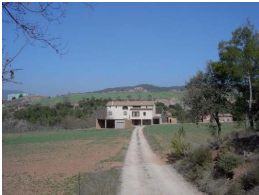
Foto 1. Façana sud del volum 1.
