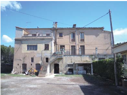
Foto 3. Façana oest del volum 1.
