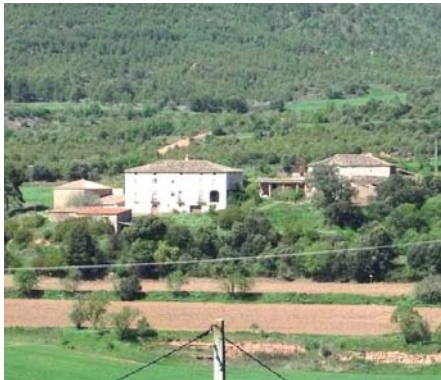
Foto 1. Façana est dels volums 1, 2, 3 i 4.
