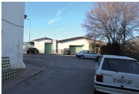
Foto 4. Façana est del volum 1 i façana sud del volum 3.
