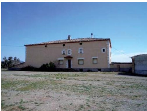
Foto 3. Façana oest del volum 1.
