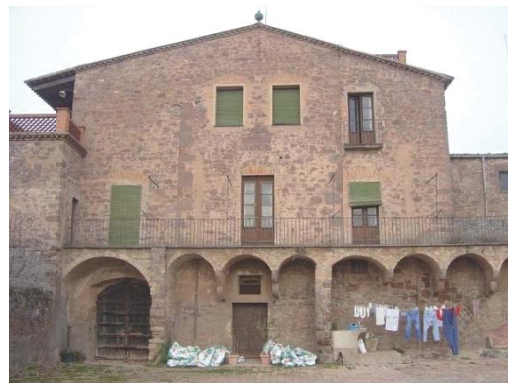
Foto 6. Façana sud el volum 1.
