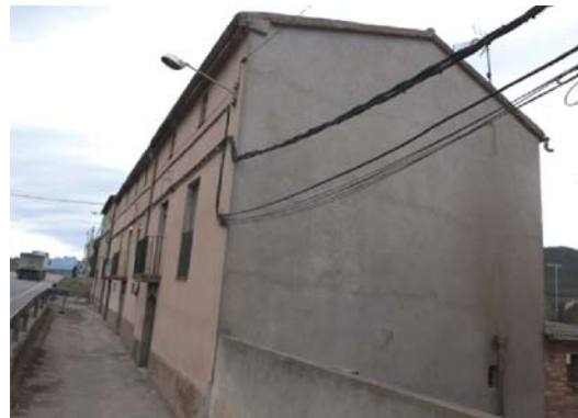
Foto 4. Façana nord - est del volum 1.
