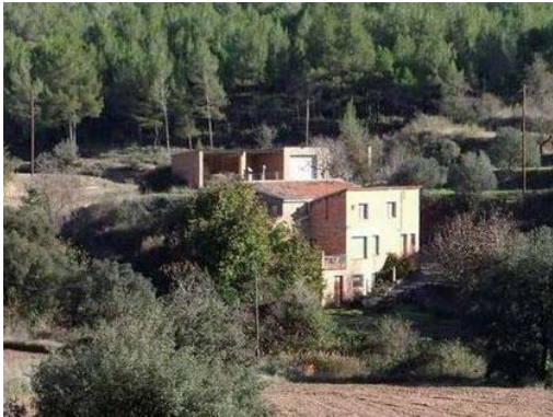
Foto 1. Façana sud - oest del volum 1.
