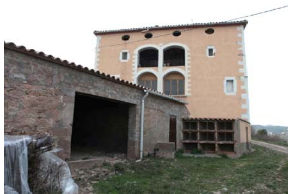
Foto 8. Façana sud del volum 1 i façana est del volum 4.
