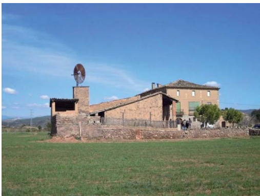
Foto 3. Façana sud del volum 3.
