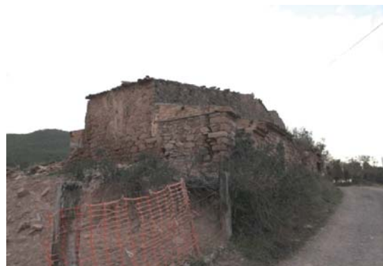
Foto 20. Façana est del volum 2.
