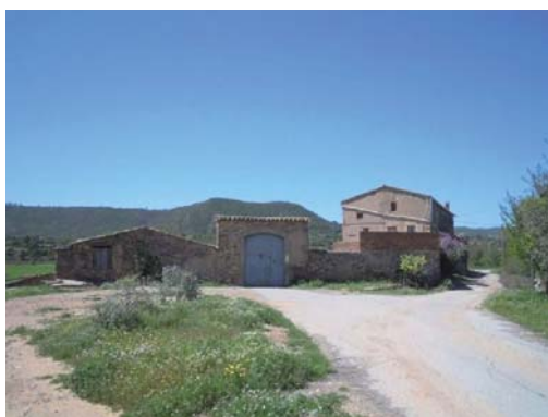
Foto 3. Façana est dels volums 1 i 4.
