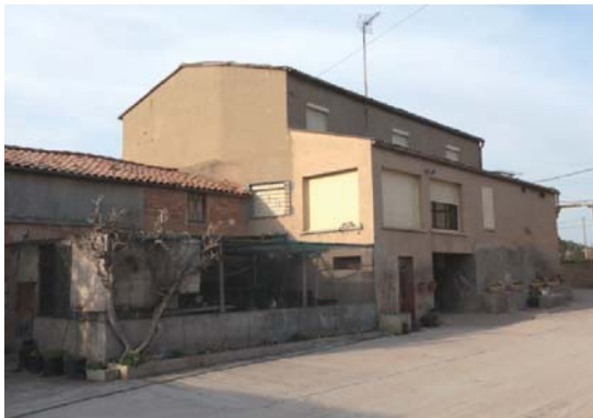
Foto 3. Façana sud del volum 1.
