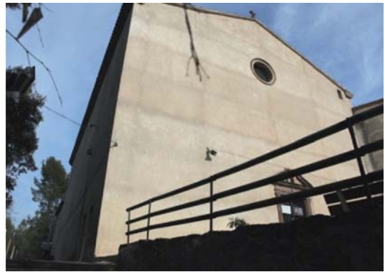
Foto 6. Façana oest del volum 1.
