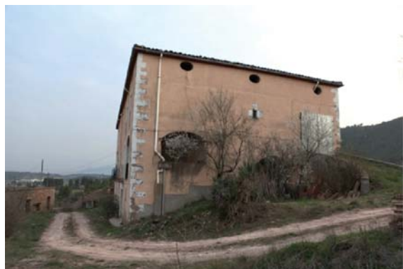
Foto 12. Façana nord del volum 1.
