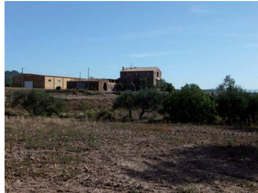
Foto 2. Façana sud - oest dels volums 3, 2 i 1.
