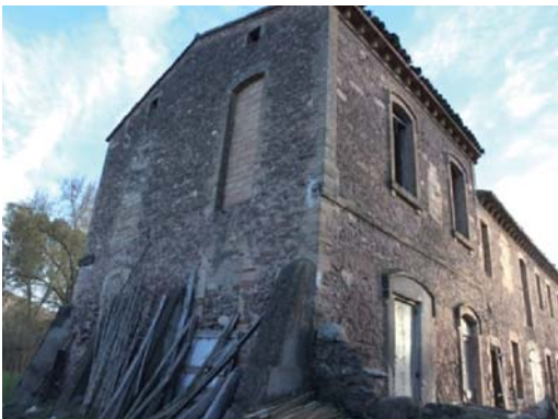
Foto 13. Façana nord - est del volum 3.
