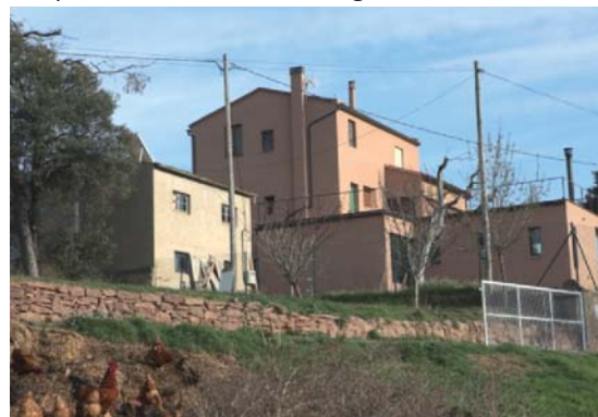
Foto 4. Façana nord dels volums 2 i 1.
