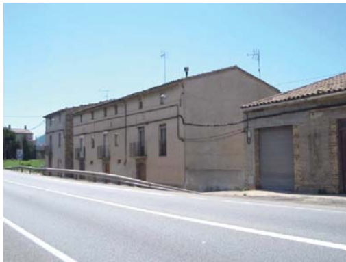
Foto 1. Façana nord - est del volum 1.
