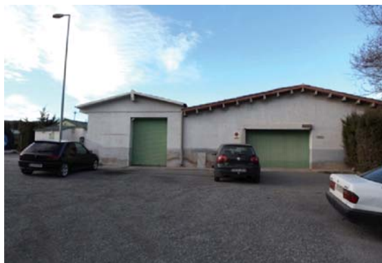
Foto 6. Façana sud del volum 3.
