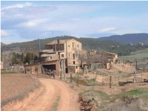
Foto 1. Façana sud dels volums 1, 2 i 3.
