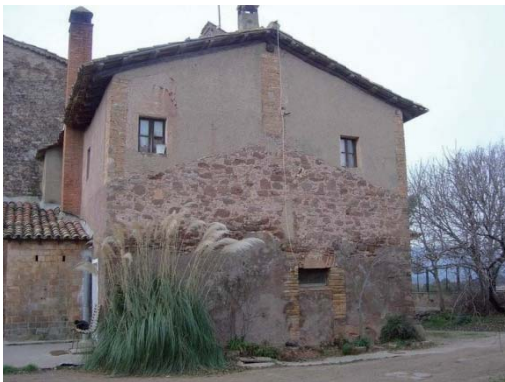
Foto 11. Façana nord del volum 1.
