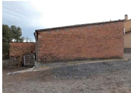
Foto 8. Façana nord del volum 4.
