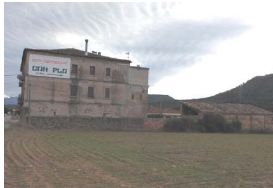
Foto 6. Façana nord dels volums 1 i 2.
