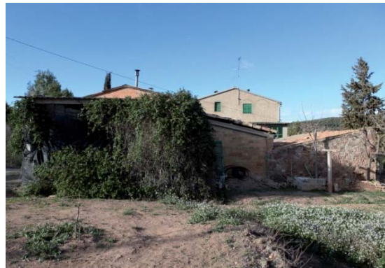
Foto 6. Façana sud del volum 1.
