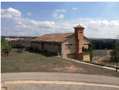
Foto 7. Façana nord - oest del volum 2.
