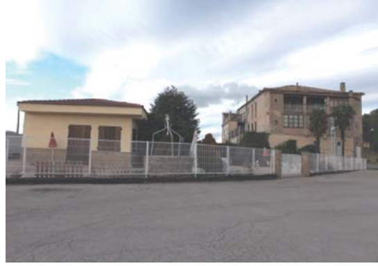
Foto 8. Façana sud del volum 1 i d'un altre edificació auxiliar feta a posteriori.
