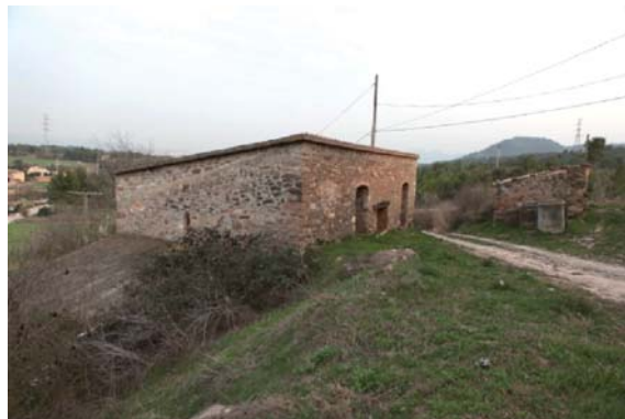
Foto 10. Façana nord del volum 2.
