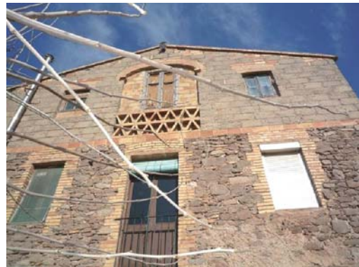
Foto 4. Façana sud del volum 1.
