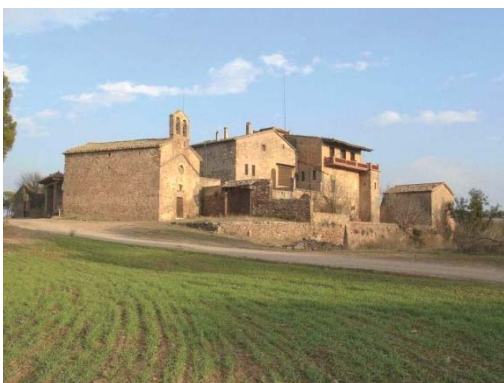
Foto 3. Façana oest dels volums 1, 2 i 4.
