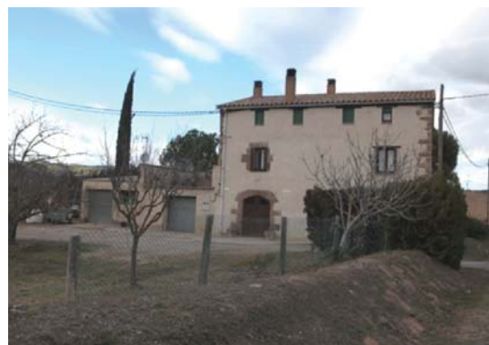
Foto 6. Façana sud del volum 2 i 1.
