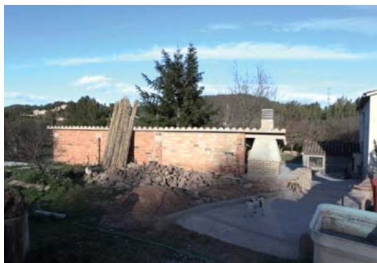
Foto 6. Façana oest del volum 3.
