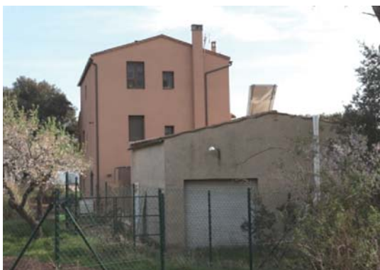
Foto 5. Façana nord dels volums 2 i 1.
