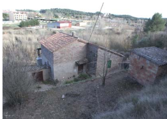
Foto 6. Façana oest dels volums 1, 2 i 3.
