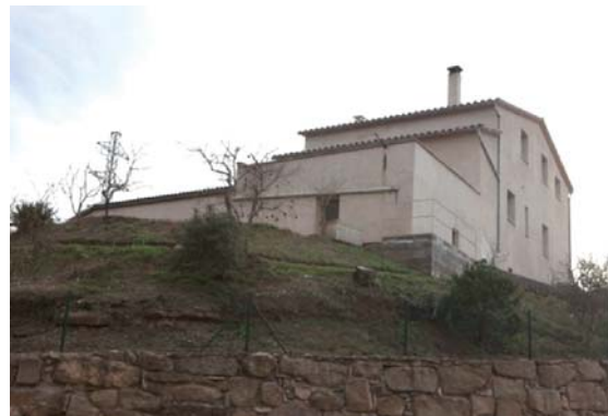
Foto 4. Façana nord - est del volum 2. Façana nord - oest del volum 1.
