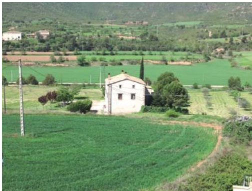
Foto 1. Façana est del volum 1.
