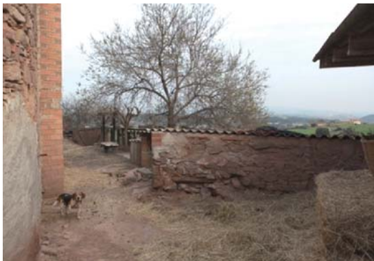
Foto 11. Vistes a altres edificacions auxiliars
