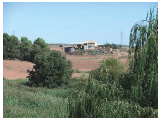
Foto 8. Façana oest del volum 1.
