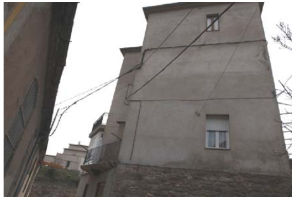
Foto 6. Façana nord - est del volum 1.
