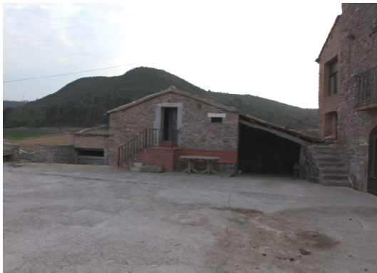
Foto 9. Façana est del volum 2.
