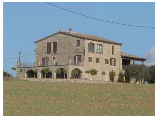
Foto 2. Façana sud - oest del volum 1.
