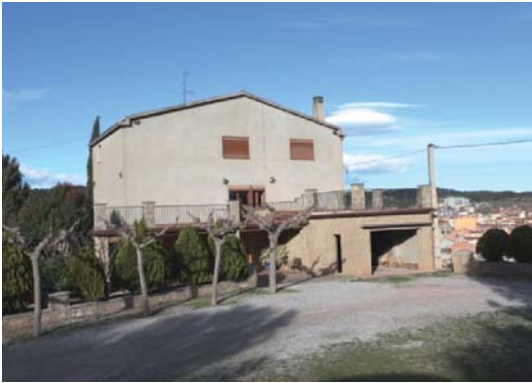
Foto 1. Façana sud dels volums 2 i 1.
