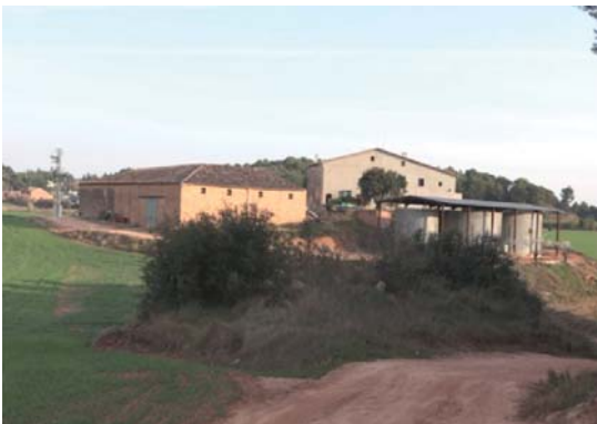
Foto 11. Façana nord del volum 2 i 1.
