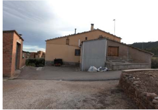
Foto 6. Façana nord dels volums 1 i 2.
