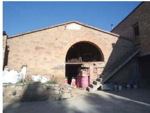
Foto 6. Façana sud del volum 2.
