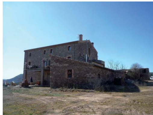
Foto 4. Façana nord - est dels volums 2 i 1.
