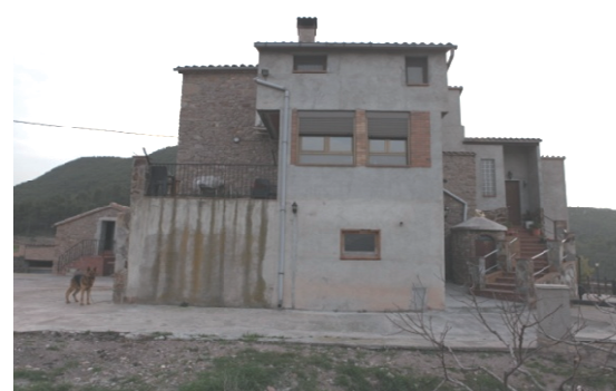
Foto 4. Façana est del volum 1.
