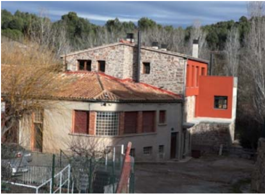
Foto 1. Façana oest del volum 1.
