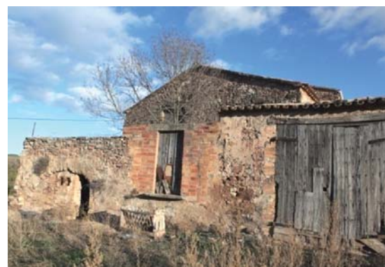
Foto 6. Façana oest dels volums 2, 1 i 3.
