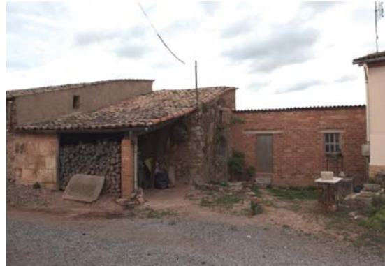
Foto 2. Façana sud - oest del volum 1.
