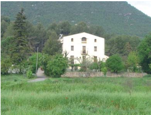
Foto 1. Façana est del volum 1.
