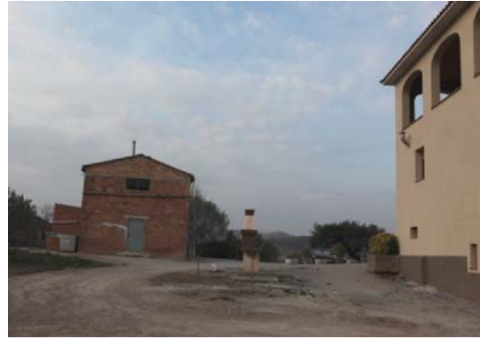
Foto 4. Façana oest del volum 1.
