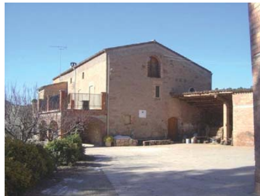
Foto 4. Façana est del volum 1.
