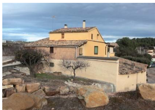
Foto 4. Façana oest dels volums 1 i 3.
