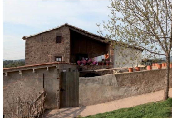
Foto 4. Façana sud del volum 1.
