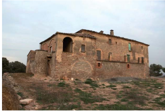
Foto 8. Façana oest del volum 1.
