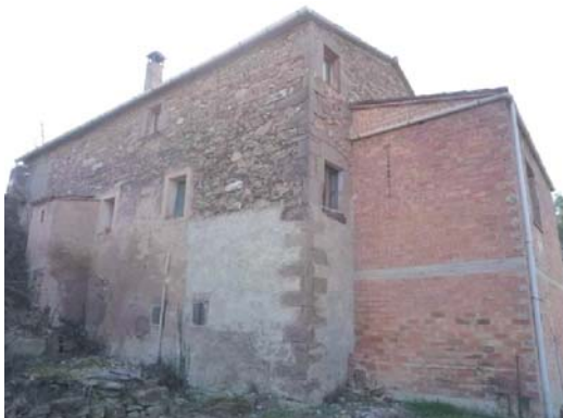
Foto 5. Façana nord - oest del volum 1.
