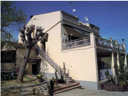
Foto 3. Façana sud - oest del volum 1.
