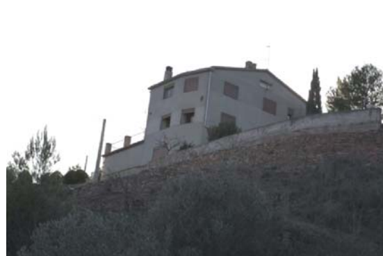
Foto 6. Façana nord - est del volum 1
