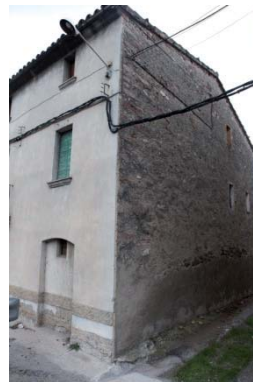
Foto 4. Façana nord - est del volum 1.
