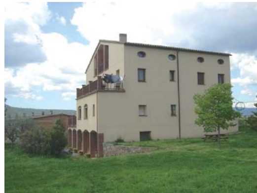
Foto 2. Façana est del volum 1
