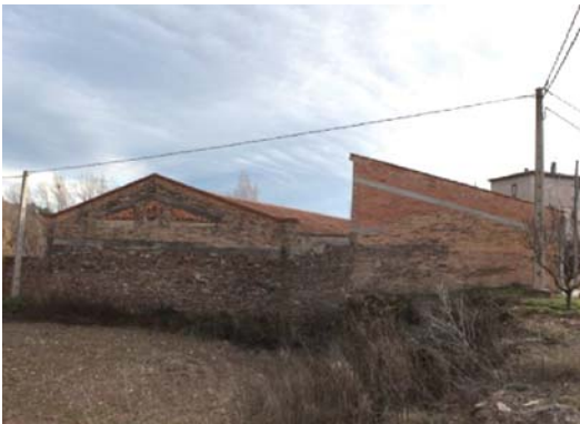
Foto 3. Façana nord del volum 1.
