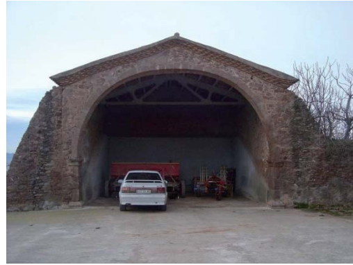
Foto 10. Façana nord del volum 4.
