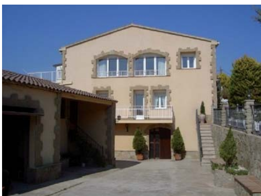
Foto 1. Façana sud del volum 1 i façana est del volum 2.
