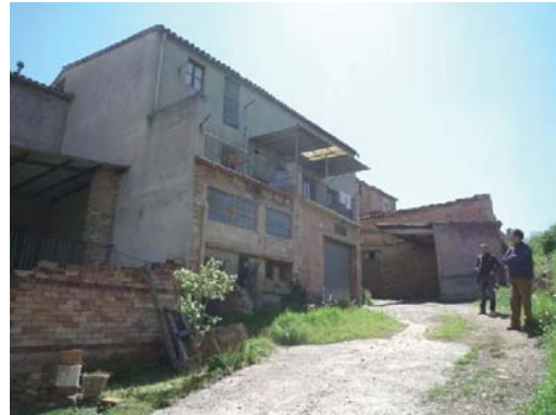
Foto 2. Façana nord - oest del volum 1.
