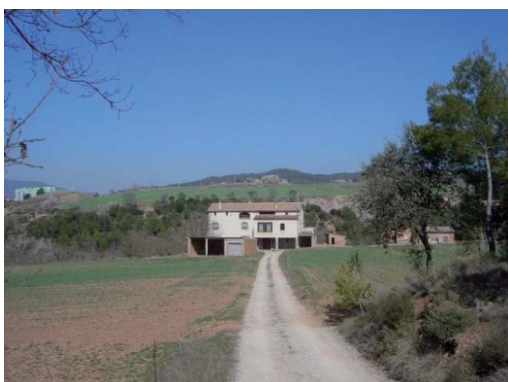
Foto 1. Façana sud del volum 1.
