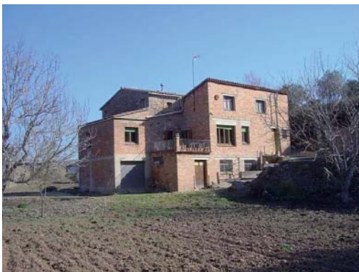
Foto 3. Façana sud - oest del volum 1
