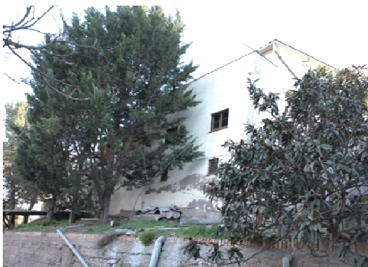
Foto 5. Façana est del volum 1.
