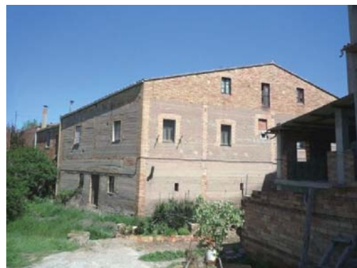
Foto 4. Façana sud - oest del volum 1.
