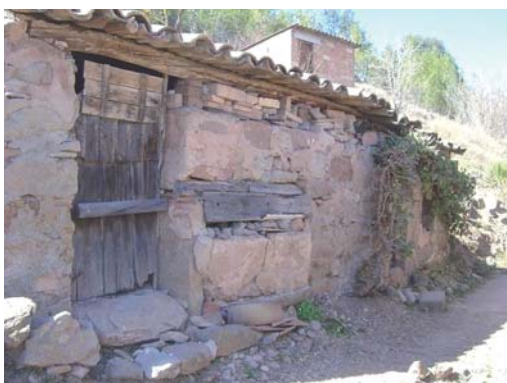
Foto 9. Façana oest del volum 3.
