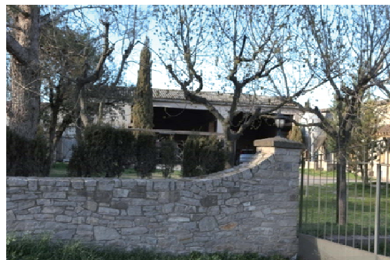
Foto 4. Façana sud d'un dels edificis del volum 2
