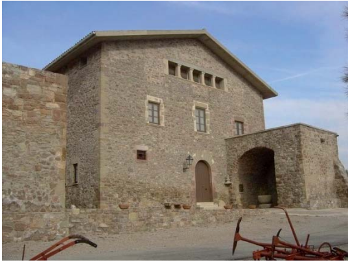
Foto 3. Façana sud del volum 1.
