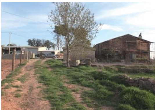
Foto 9. Façana nord dels volums 2 i 1.
