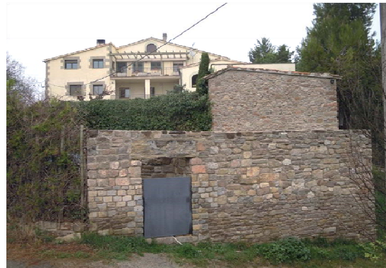
Foto 2. Façana sud dels volums 1 i 3.
