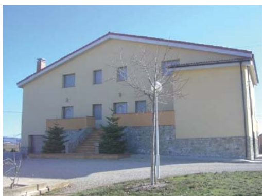
Foto 1. Façana nord del volum 1.
