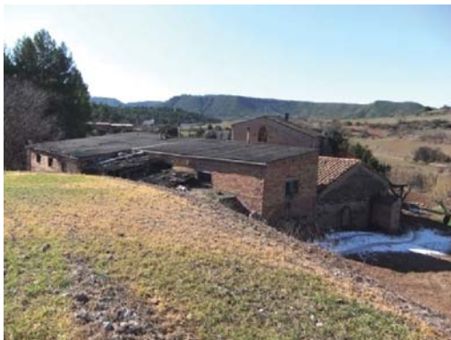
Foto 7. Façana nord - est del volum 2.
