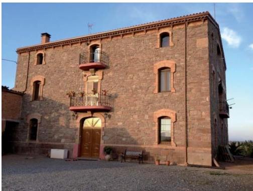
Foto 7. Façana oest del volum 1.
