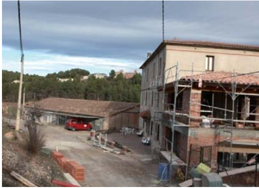
Foto 3. façana nord - oest del volum 1.
