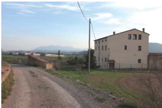
Foto 3. Façana nord - est del volum 1.
