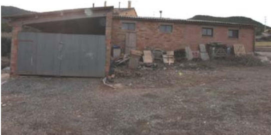
Foto 9. Façana est del volum 4.
