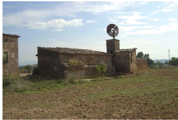
Foto 10. Façana oest del volum 3.
