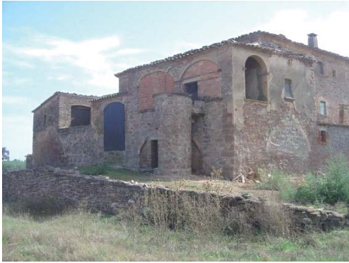
Foto 7. Façana nord dels volums 1 i 2
