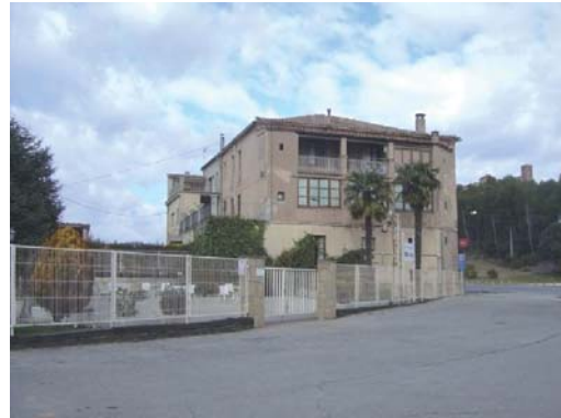
Foto 2. Façana sud del volum 1.
