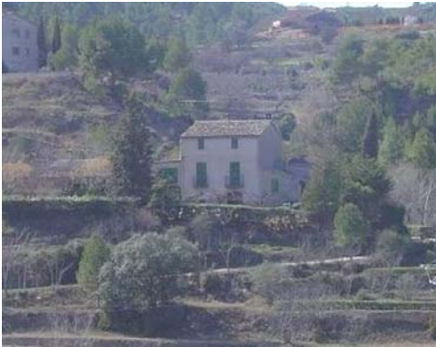
Foto 1. Façana est dels volums 1 i 2.
