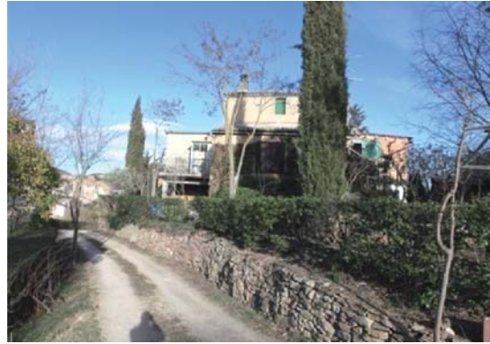
Foto 10. Façana oest del volum 1.
