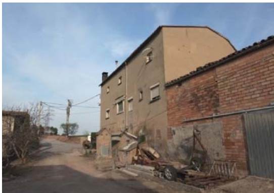
Foto 5. Façana nord del volum 1 .
