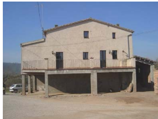
Foto 6. Façana est del volum 1
