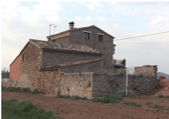
Foto 11. Façana sud - oest del volum 2.
