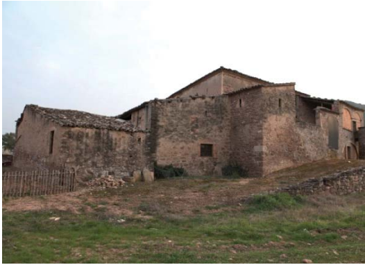
Foto 15. Façana nord del volum 2.
