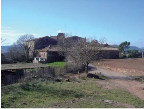
Foto 9. Façana nord del volum 3.
