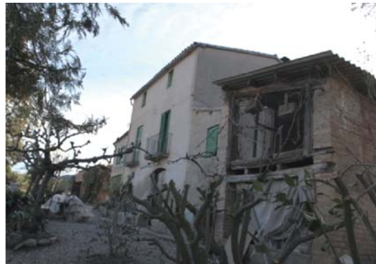
Foto 12. Façana nord - est dels volums 2 i 1.
