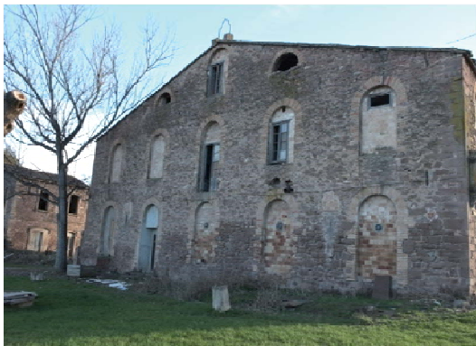
Foto 5. Façana nord -est del volum 1.
