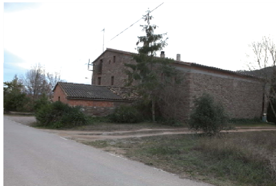
Foto 6. Façana nord - est dels volums 1 i 2.
