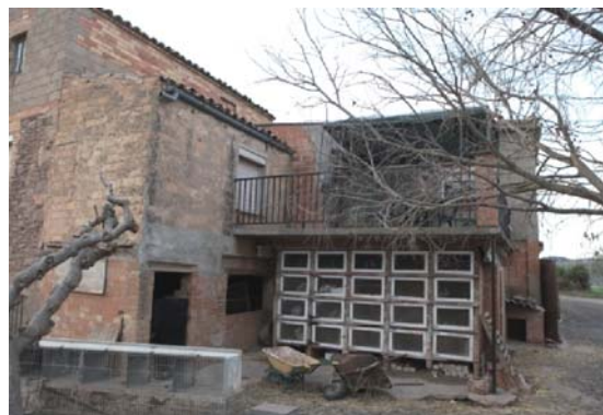
Foto 14. Façana sud del volum 1.
