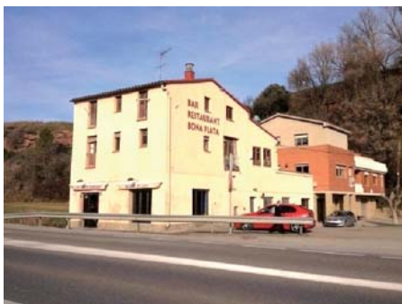
Foto 1. Façana sud - oest del volum 1
