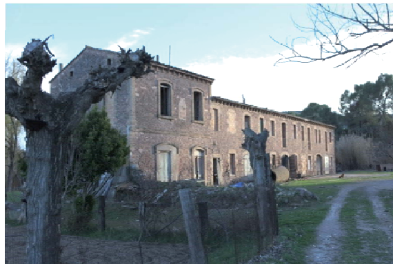
Foto 6. Façana nord - oest del volum 3.
