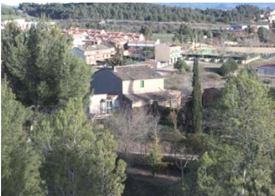
Foto 13. Façana oest del volum 1.
