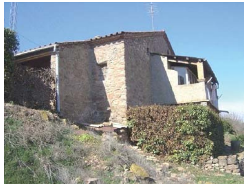
Foto 8. Façana sud del volum 1.
