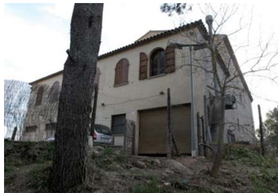
Foto 4. Façana est del volum 1.
