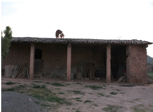
Foto 13. Façana est del volum 1.
