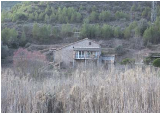
Foto 1. Façana est del volum 1.
