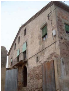
Foto 3. Façana est del volum 1.
