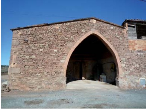
Foto 9. Façana sud del volum 3.
