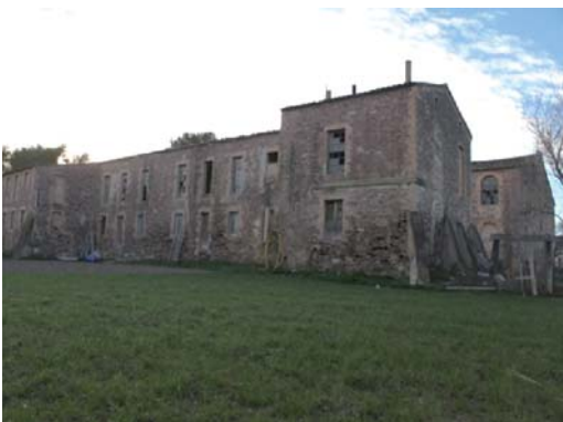
Foto 15. Façana est del volum 3.
