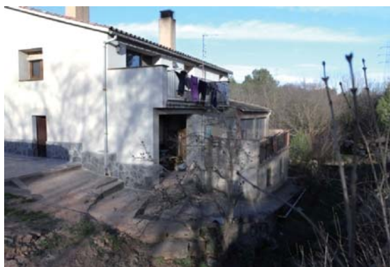
Foto 4. Façana sud - oest del volum 1.
