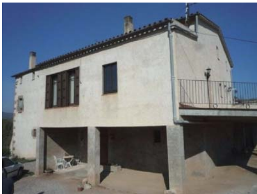
Foto 5. Façana sud del volum 1.
