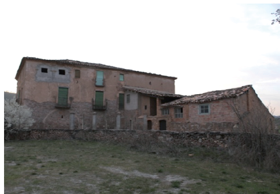
Foto 12. Façana est dels volums 1 i 2.
