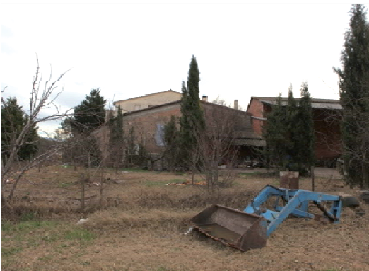
Foto 9. Façana nord del volum 2.
