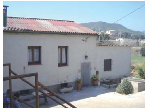
Foto 2. Façana est del volum 1.
