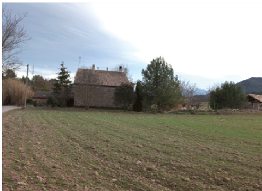
Foto 5. Façana nord dels volums 1 i 2.
