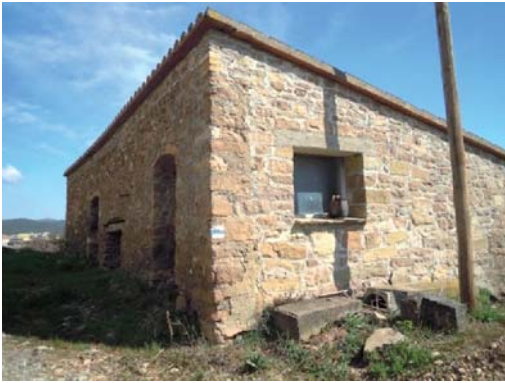
Foto 15. Façanes sud i oest del volum 2.
