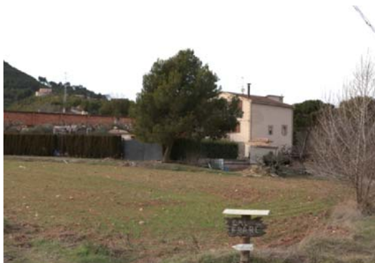
Foto 3. Façana est del volum 1.
