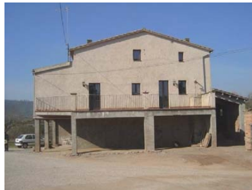
Foto 6 Façana est de Cal Botifollet.
