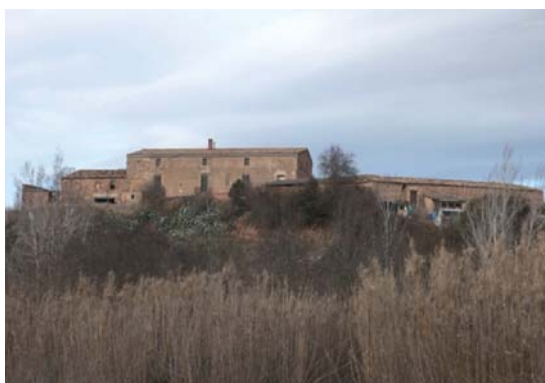
Foto 5. Façana sud - oest dels volums 3, 1 i 4.
