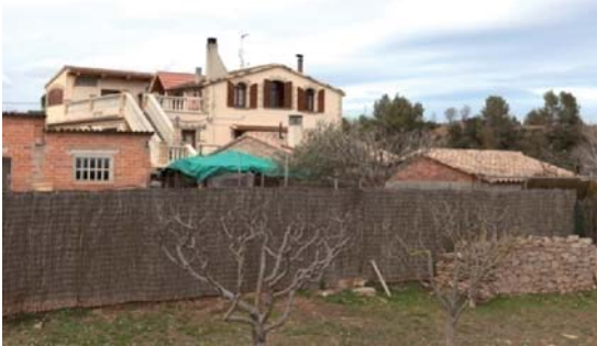
Foto 7. Façana sud del volum 3.
