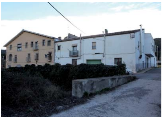
Foto 5. Façana est del volum 1.
