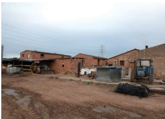
Foto 5. Façana oest dels volums 1, 2 i 3.
