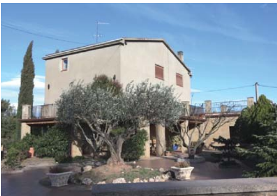
Foto 3. Façana sud - oest dels volums 2 i 1.
