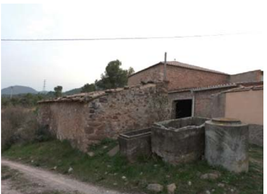
Foto 11. Façana nord - est del volum 3.
