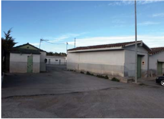
Foto 7. Façana sud volum 2 i façana oest volum 3
