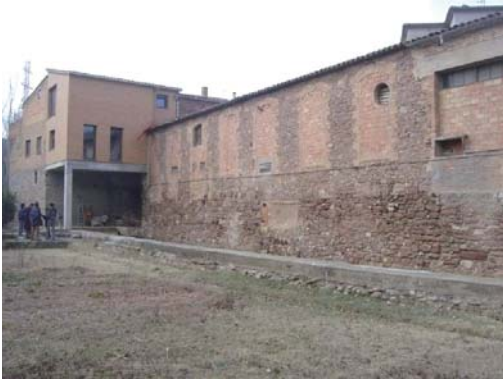
Foto 9. Façana est del volum 1.
