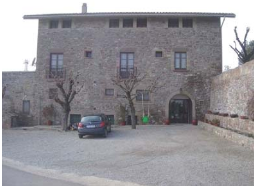
Foto 5. Façana est del volum 1.
