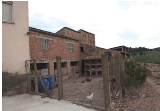
Foto 10. Façana est del volum 1.
