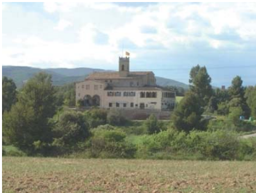
Foto 1. Façana sud del volum 1
