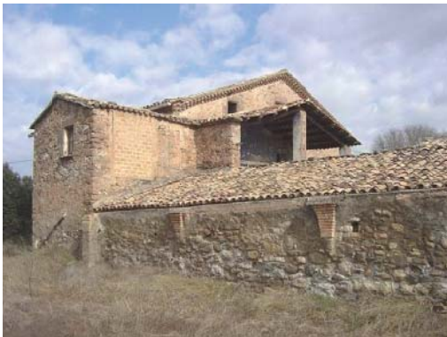
Foto 5. Façana oest dels volums 1 i 2.
