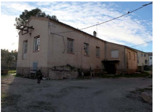
Foto 7. Façana est del volum 2.
