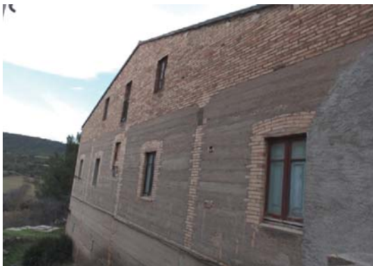
Foto 5. Façana sud del volum 1.
