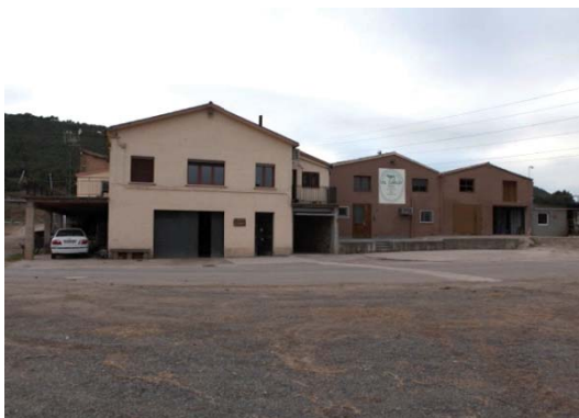
Foto 1. Façana est dels volums 1 i 2.
