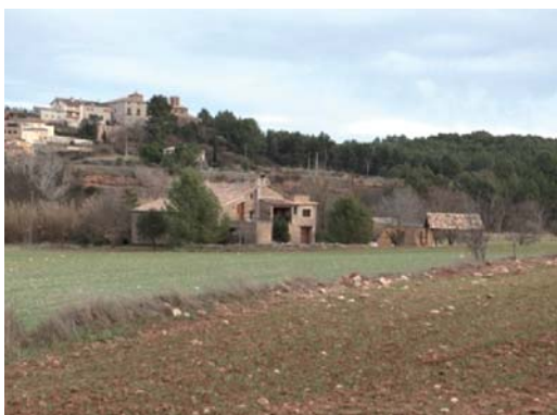
Foto 7. Façana oest dels volums 1 i 3.
