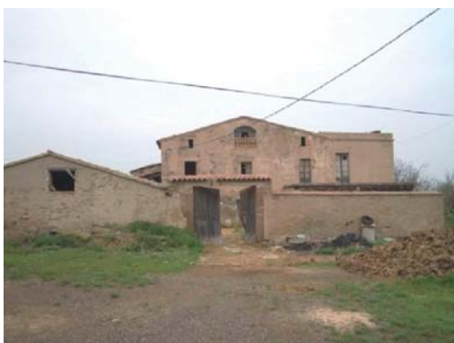
Foto 7. Façana sud dels volums 2, 1 i 3
