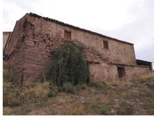
Foto 10. Façana sud del volum 1.
