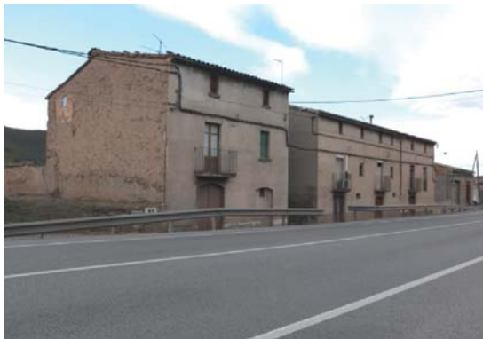
Foto 3. Façana est del volum 1.
