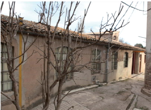
Foto 5. Façana oest del volum 1.
