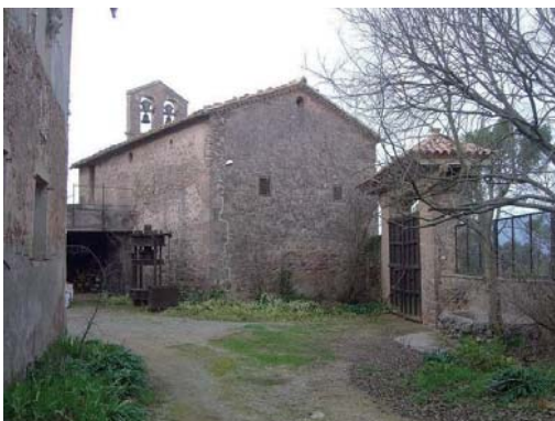
Foto 7. Façana nord del volum 2.
