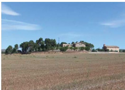
Foto 1. Façana sud dels volums 1 i 2.
