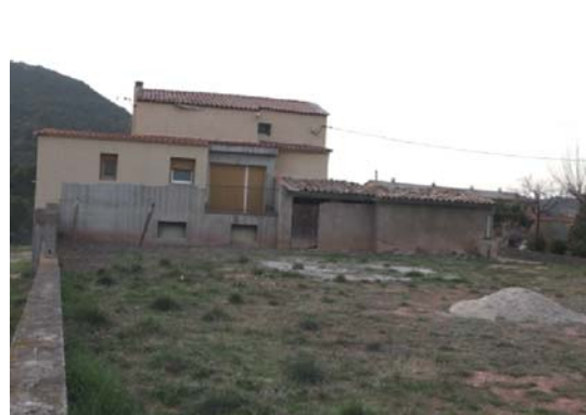
Foto 6. Façana est del volum 1.
