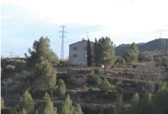
Foto 5. Façana nord del volum 1.
