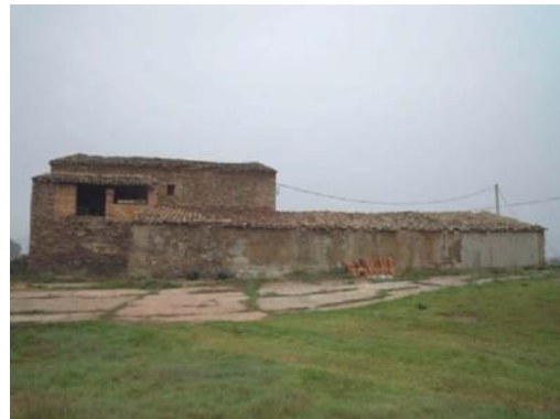
Foto 6. Façana oest dels volums 1 i 2
