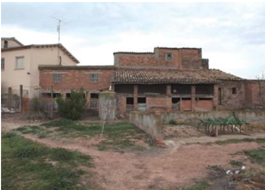
Foto 9. Façana est del volum 1.
