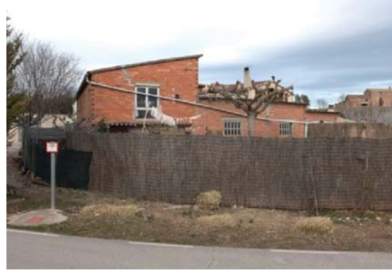
Foto 6. Façana oest del volum 3.
