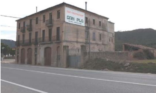
Foto 5. Façana nord - est dels volums 1 i 2.
