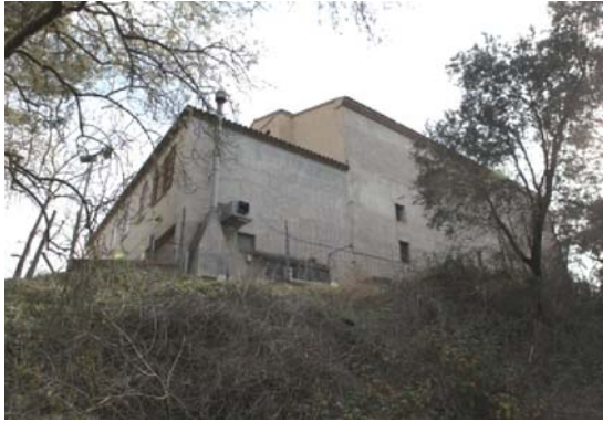
Foto 9. Façana nord del volum 1.
