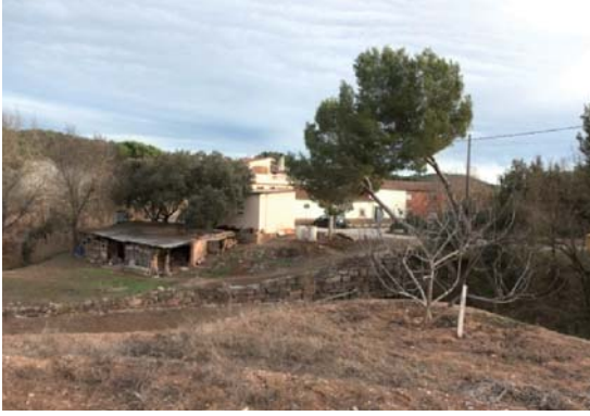
Foto 5. Façana nord del volum 1.
