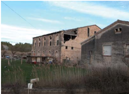
Foto 19. Façana nord -oest volum 2 i 1
