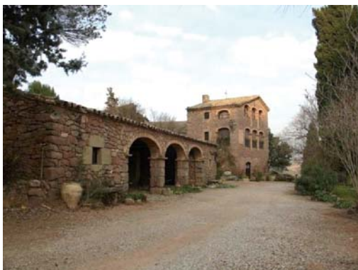
Foto 5. Façana sud dels volums 4 i 1
