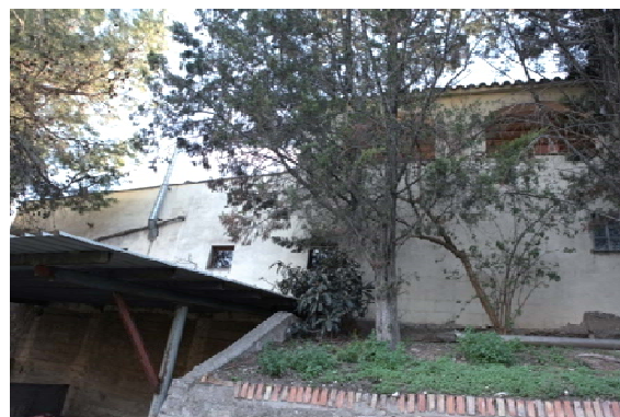
Foto 6. Façana sud dels volums 1 i 3.
