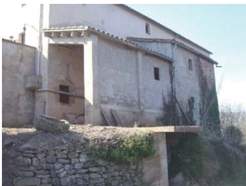
Foto 7. Façana nord del volum 1.
