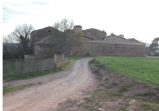
Foto 12. Façana nord del volum 3.
