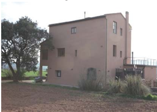
Foto 3. Façana est del volum 1
