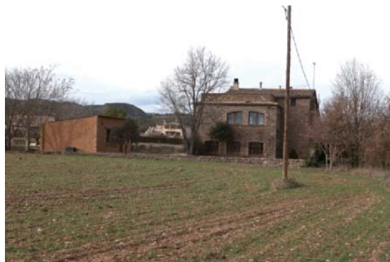
Foto 4. Façana sud del volum 1 i 3.
