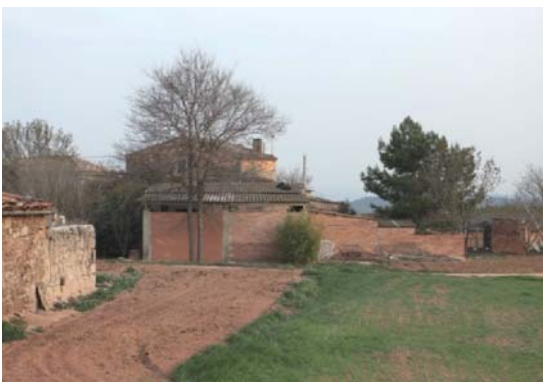
Foto 21. Façana nord - oest del volum 1.
