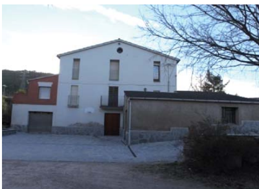
Foto 1. Façana est dels volums 1 i 2.
