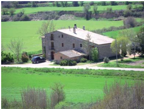
Foto 1. Façana nord - est dels volums 1 i 2.
