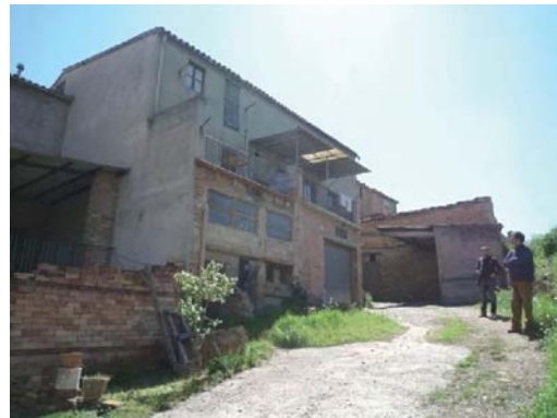
Foto 2. Façana nord dels volums 1 i 2.
