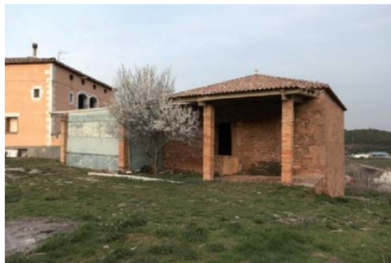
Foto 4. Façana oest del volum 4.
