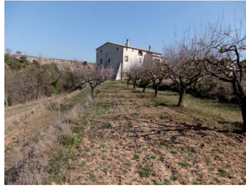
Foto 4. Façana sud del volum 1 i oest de Cal Tinarro.
