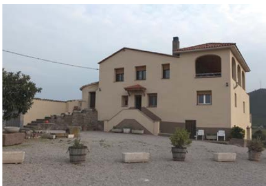
Foto 1. Façana nord del volum 1.
