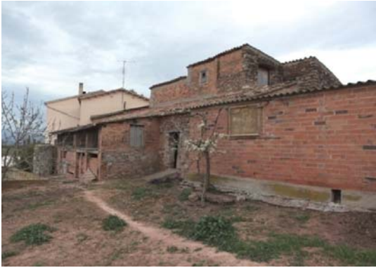
Foto 7. Façana est dels volums 2 i 1.
