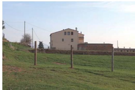
Foto 4. Façana nord dels volums 1 i 2.
