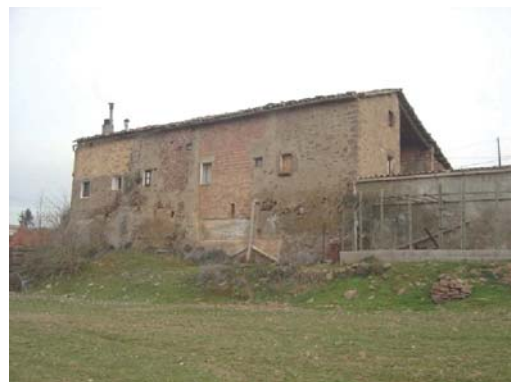
Foto 10. Façana oest del volum 1.
