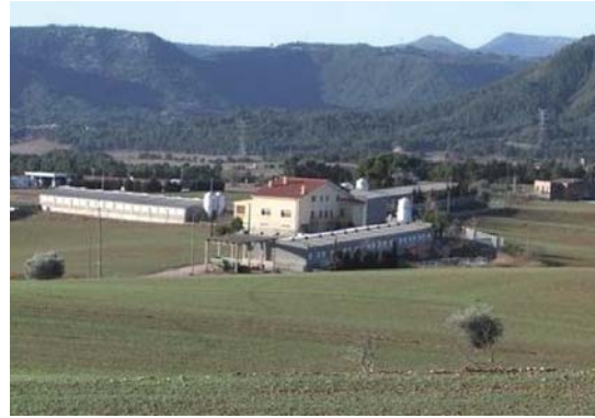
Foto 4. Façana nord del volum 1.
