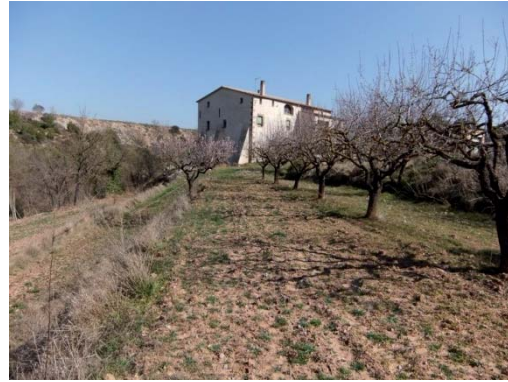
Foto 4. Façana sud - oest del volum 1.
