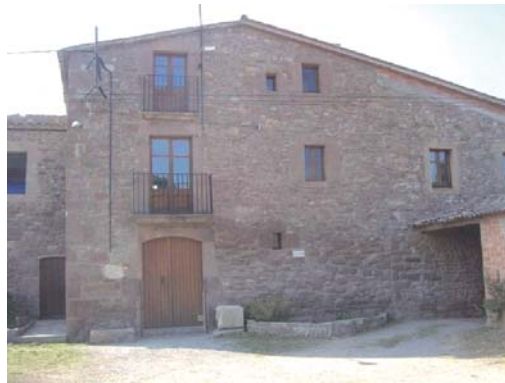
Foto 2. Façana est del volum 1.
