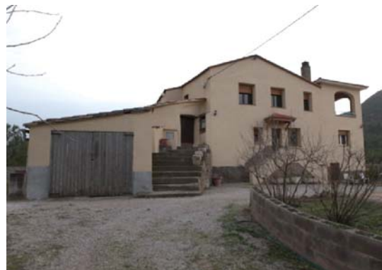
Foto 8. Façana nord del volum 1 i 2.
