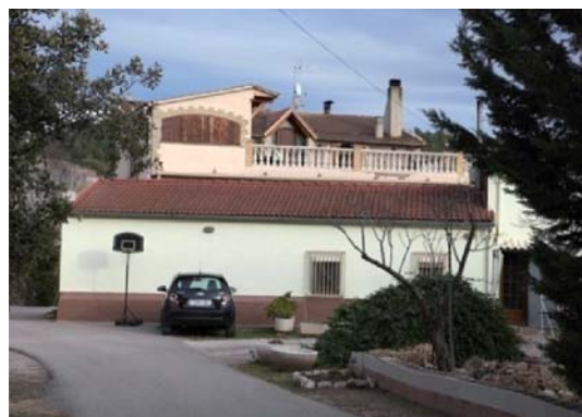
Foto 4. Façana oest del volum 1
