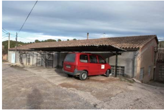
Foto 2. Façana oest del volum 1.
