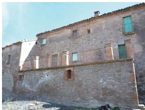
Foto 6. Façana oest del volum 1.
