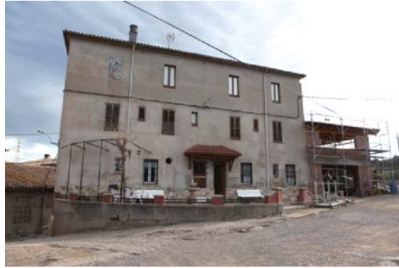
Foto 4. Façana nord - oest del volum 1.
