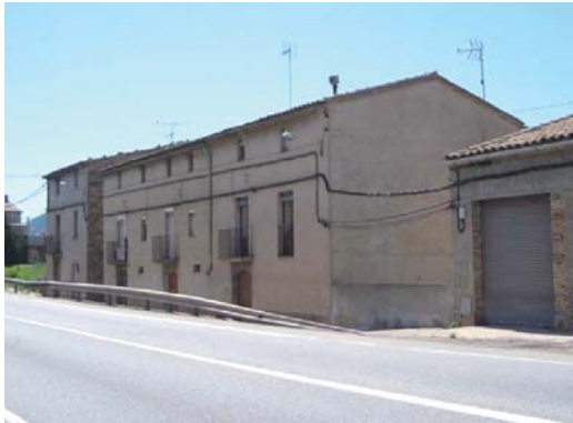
Foto 1. Façana est del volum 1.
