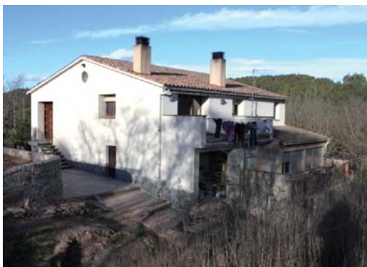
Foto 5. Façana sud - oest del volum 1
