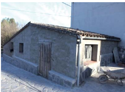
Foto 3. Façana nord - oest del volum 2
