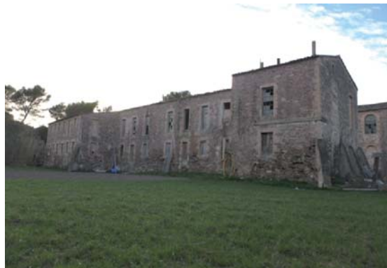
Foto 14. Façana est del volum 3.
