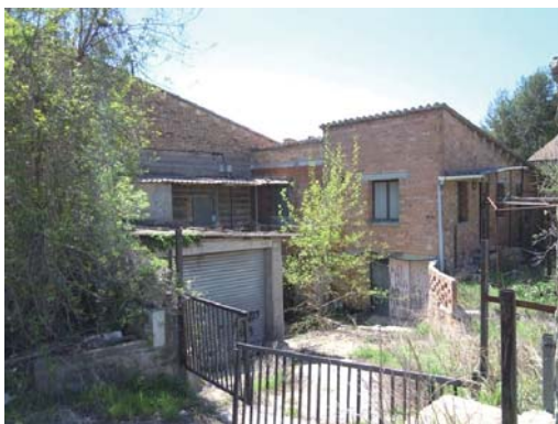
Foto 3. Façana est del volum 1 del pati interior format entre els volums 1 i 2 i façana nord volum 2.
