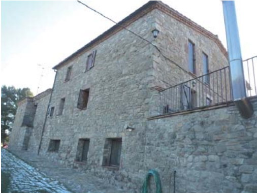
Foto 3. Façana nord del volum 1.
