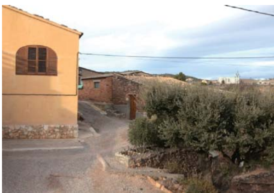
Foto 3. Façana sud del volum 1.
