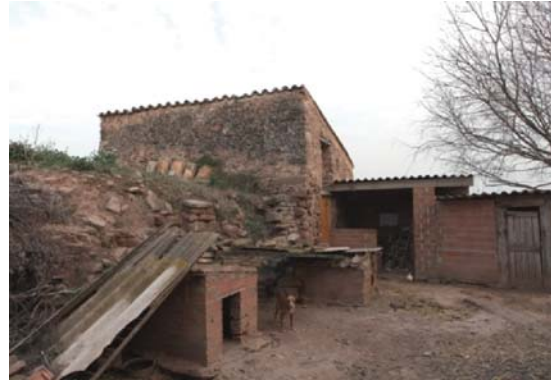
Foto 16. Façana nord del volum 3.
