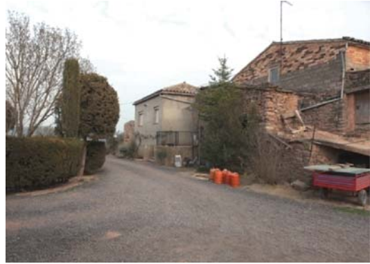
Foto 8. Façana nord - oest del volum 1.
