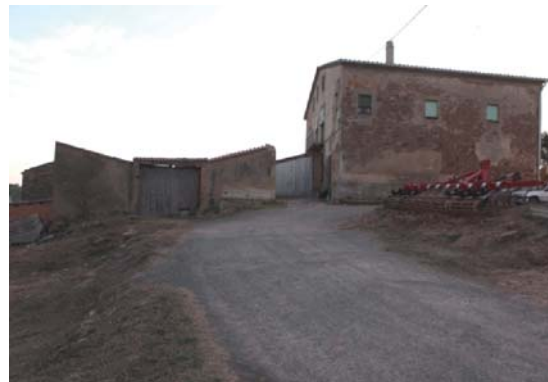
Foto 12. Façana est del volum 1.
