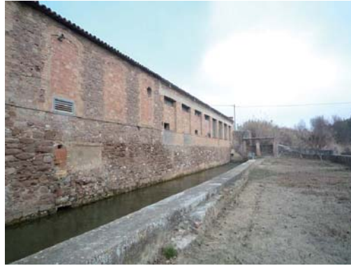
Foto 8. Façana est del volum 1.
