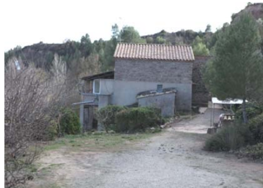
Foto 2. Façana nord dels volums 1 i 2.
