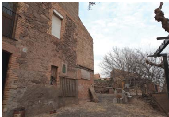
Foto 12. Façana sud del volum 1.
