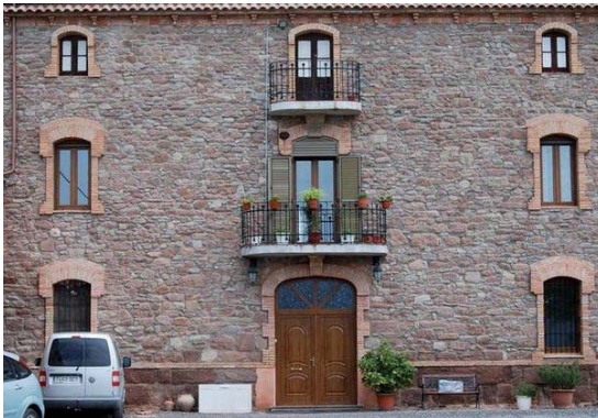
Foto 5. Façana oest del volum 1.
