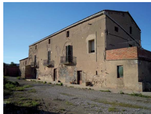
Foto 2. Façana sud del volum 1.
