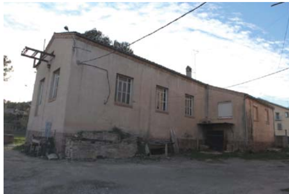
Foto 12. Façana est del volum 2.
