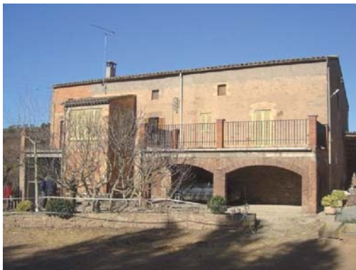
Foto 3. Façana sud del volum 1.
