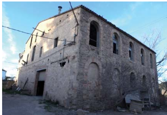
Foto 8. façanes sud i oest del volum 1.
