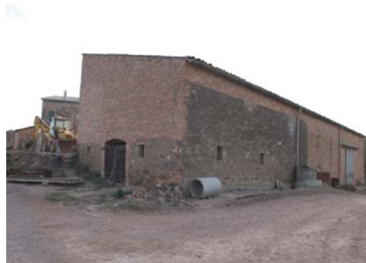
Foto 14. Façana nord - est del volum 2.
