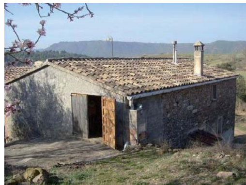
Foto 4. Façana nord - est del volum 1.
