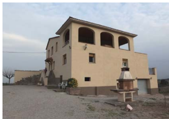
Foto 2 Façana oest del volum 1 i 2.
