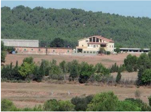
Foto 3. Façana sud del volum 1
