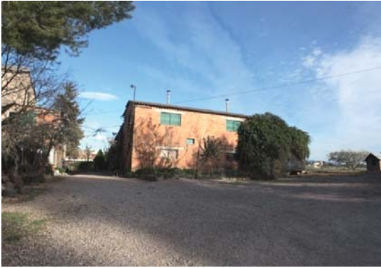
Foto 9. Vistes a altres edificacions auxiliars.
