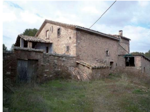
Foto 2. Façana est del volum 1.
