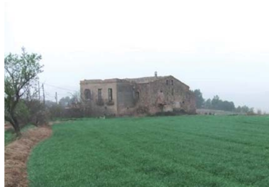
Foto 2. Façana nord - est del volum 1.
