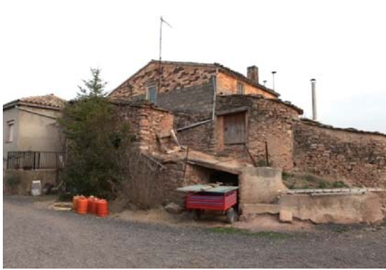
Foto 7. Façana oest del volum 1.
