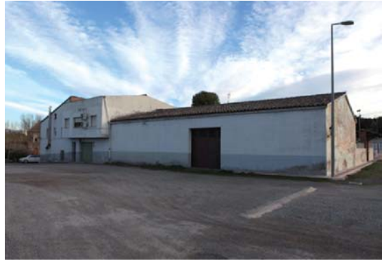
Foto 8. Façana nord - oest del volum 1.
