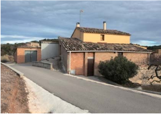
Foto 5. Façana nord - oest volum 1 i 2.
