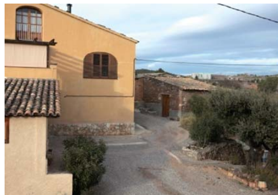
Foto 10. Façana sud del volum 3.
