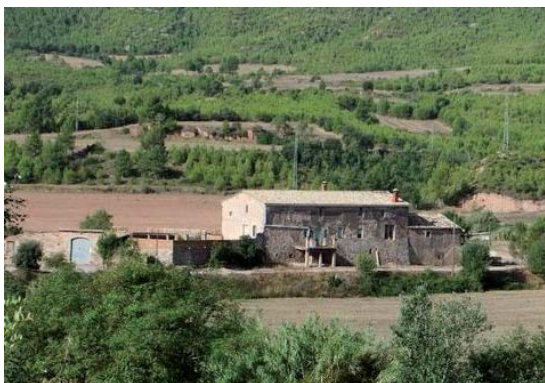
Foto 1. Façana nord dels volums 1 i 2.
