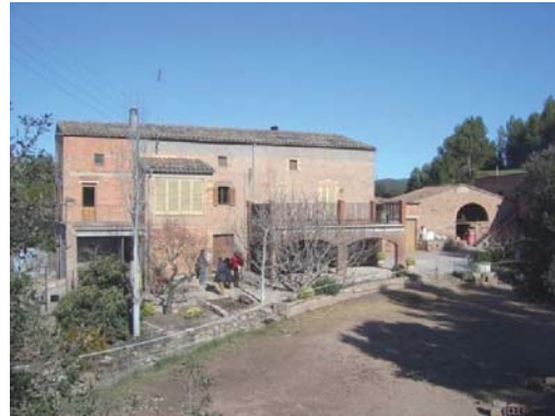
Foto 2. Façana sud dels volums 1 i 2.
