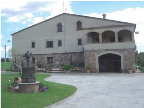
Foto 5. Façana nord del volum 1.
