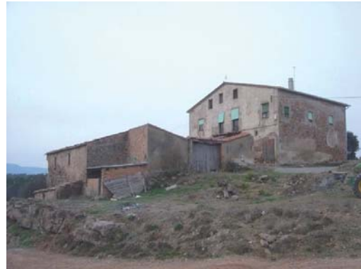
Foto 2. Façana est del volum 1
