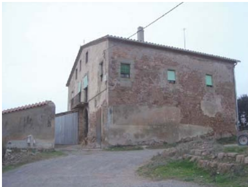
Foto 5. Façana est del volum 1.
