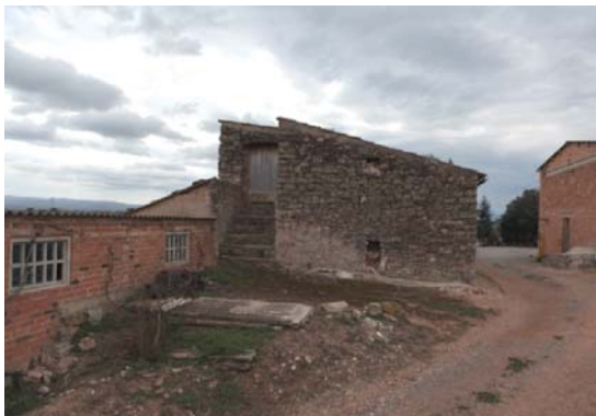
Foto 5. Façana nord del volum 1
