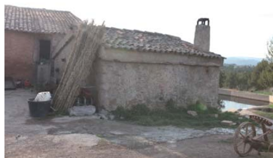
Foto 6. Façana est del volum 2.
