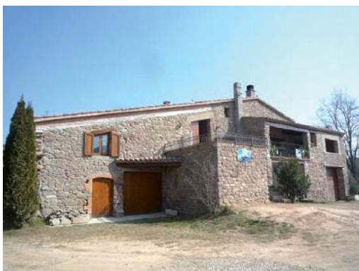
Foto 3. Façana oest del volum 1.
