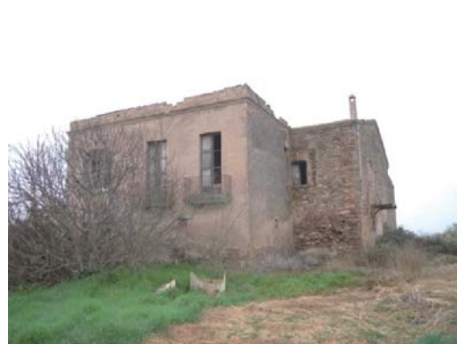
Foto 4. Façana nord - est del volum 1.
