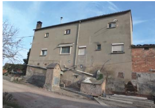
Foto 4. Façana nord del volum 1.
