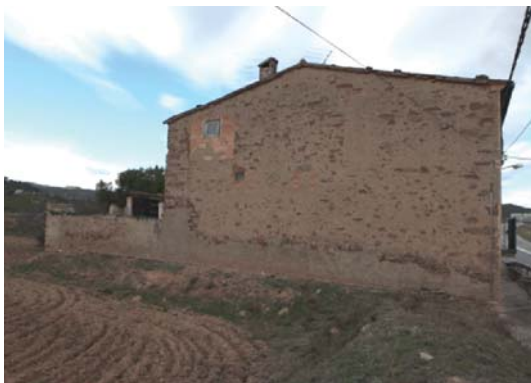
Foto 5. Façana sud del volum 1.
