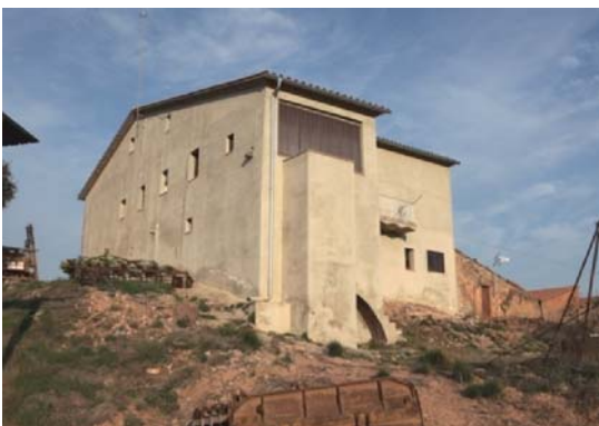
Foto 13. Façana oest del volum 1.
