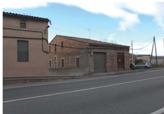
Foto 6. Façana est del volum 1.
