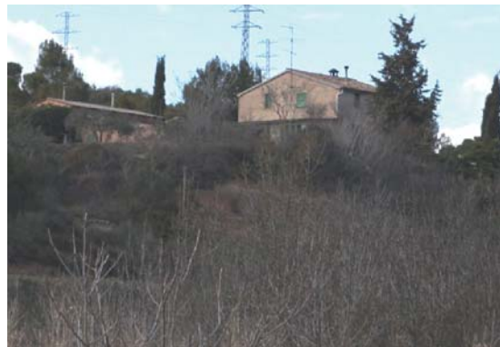
Foto 4. Façana est del volum 1.
