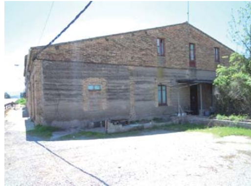
Foto 2. Façana nord volum 1.
