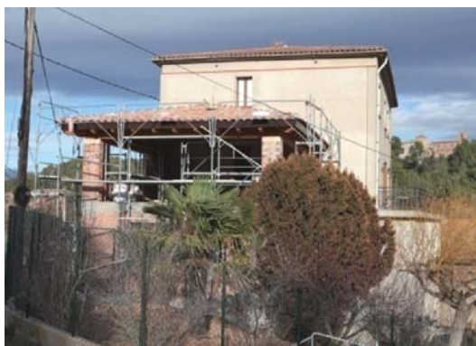
Foto 1. Façana sud - oest del volum 1.
