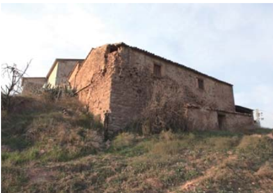
Foto 15. Façana sud - oest del volum 1.
