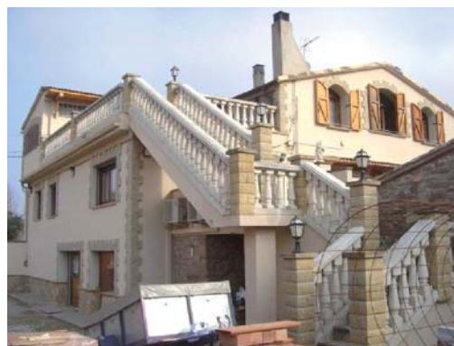
Foto 2. Façana oest dels volums 1 i 3.
