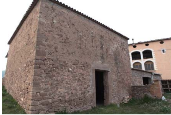
Foto 6. Façana est del volum 4.
