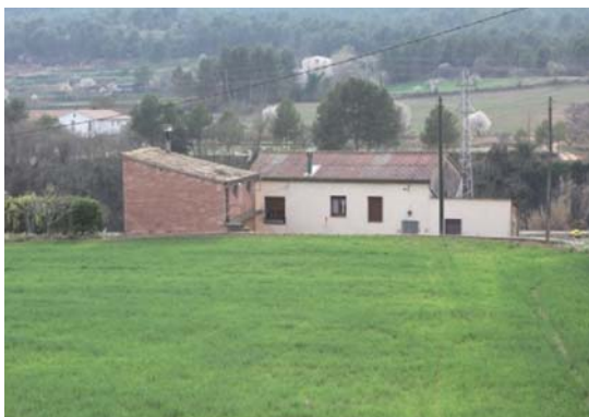
Foto 3. Façana est del volum 1.
