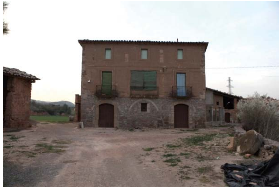
Foto 2. Façana sud del volum 1.
