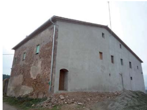
Foto 6. Façana nord del volum 1.
