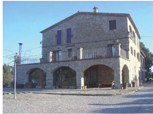
Foto 6. Façana oest del volum 1.
