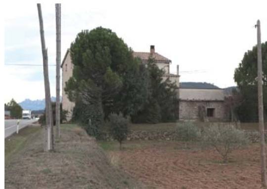
Foto 4. Façana nord dels volums 1 i 2.
