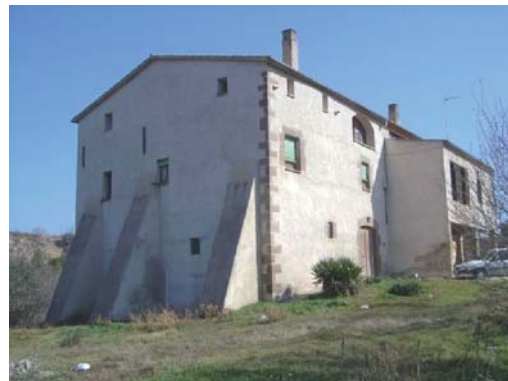
Foto 2. Façana sud - oest del volum 1.
