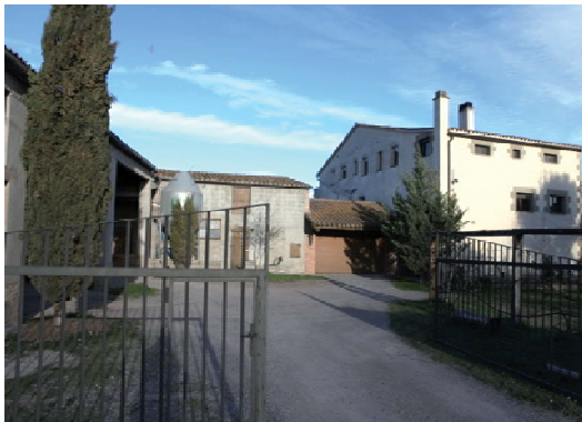
Foto 1. Façana oest dels volums 2 i 1.
