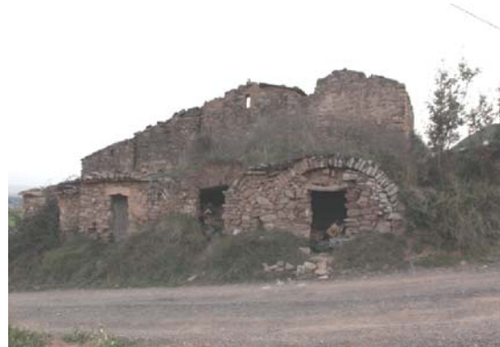
Foto 18. Façana nord del volum 2.
