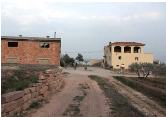
Foto 9. Façana nord volum 1 i 2.
