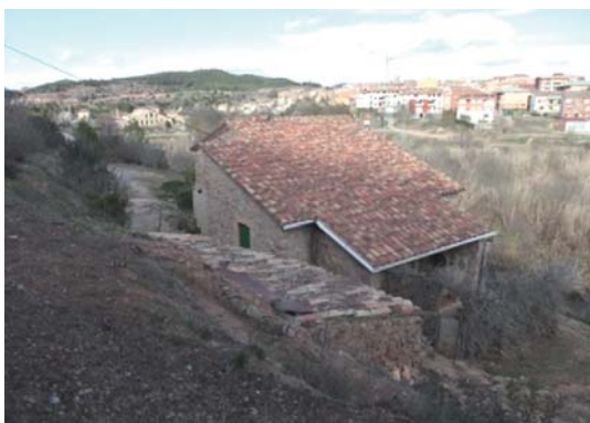
Foto 5. Façana sud- oest del volum 3.
