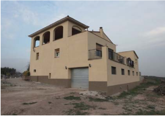
Foto 3. Façana sud - oest del volum 1.
