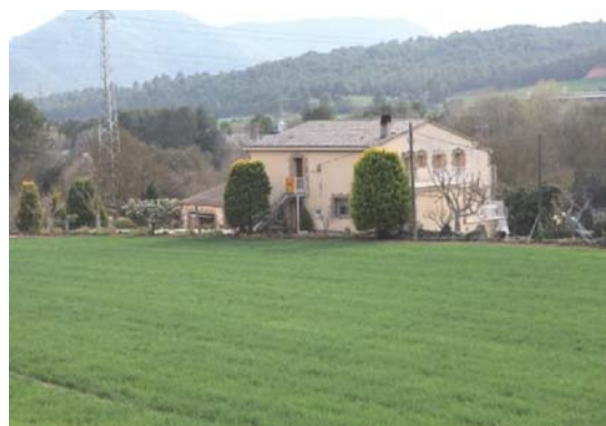
Foto 2. Façana nord - est del volum 1
