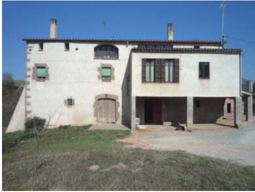
Foto 3. Façana sud del volum 1.
