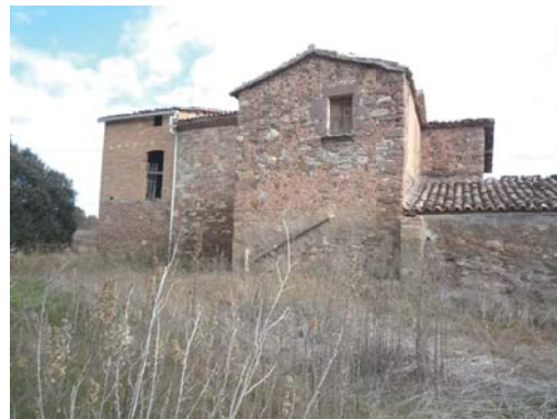
Foto 4. Façana oest del volum 1
