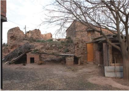
Foto 15. Façana oest dels volums 2 i 3
