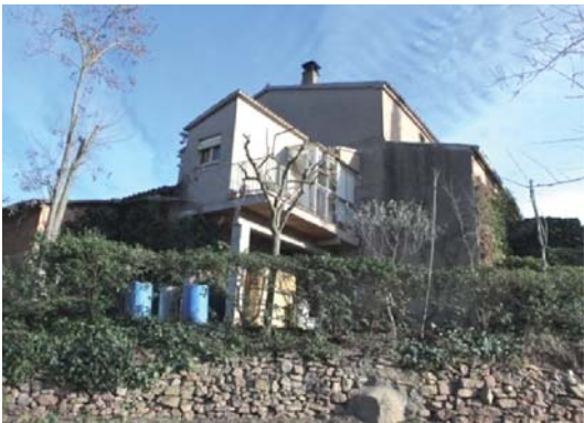
Foto 11. Façana nord - oest del volum 1.
