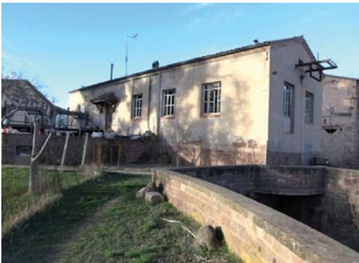
Foto 11. Façana sud - oest del volum 2.
