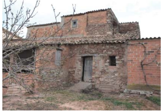
Foto 8. Façana est del volum 1.
