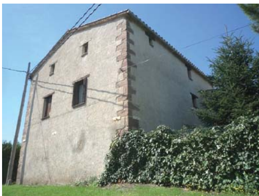
Foto 3. Façana nord - est del volum 1.
