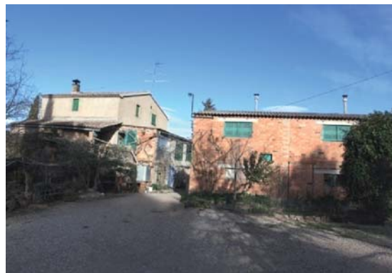
Foto 8. Façana oest del volum 1.
