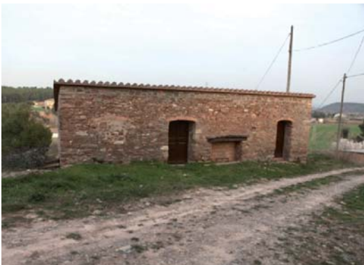
Foto 9. Façana oest del volum 2.
