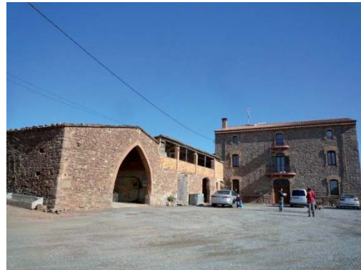
Foto 6. Façana sud - oest dels volums 3, 2 i 1.
