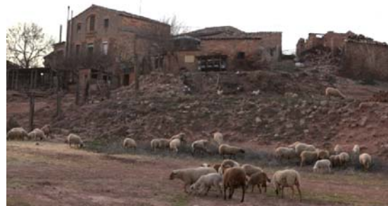
Foto 2. Façana est dels volums 2, 3 i 1.
