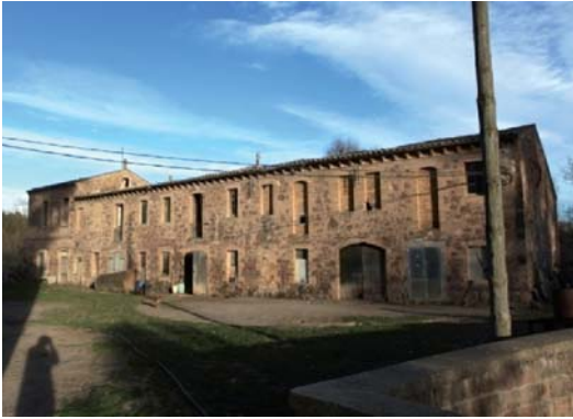
Foto 9. Façana nord - oest del volum 3.
