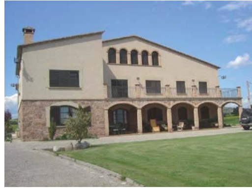
Foto 4. Façana sud del volum 1.
