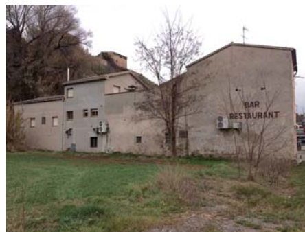
Foto 2. Façana nord del volum 1.
