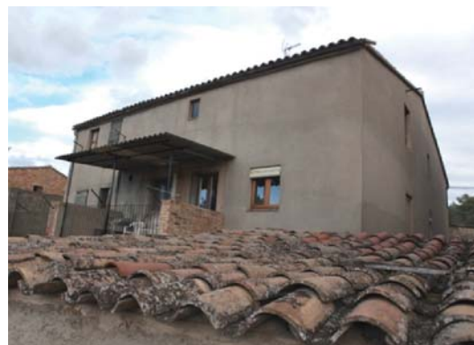
Foto 4. Façana sud del volum 1.
