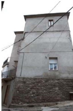
Foto 5. Façana nord - est del volum 1.
