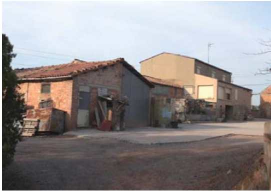
Foto 1. Façana sud del volum 1.
