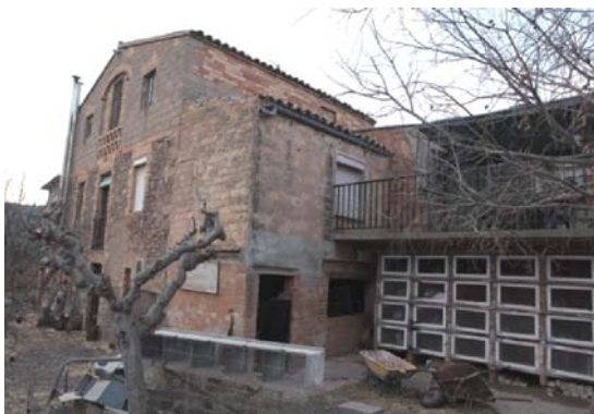
Foto 13. Façana sud del volum 1.
