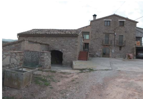
Foto 12. Façana sud del volum 1 i 2.
