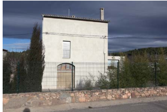
Foto 2. Façana oest del volum 1.
