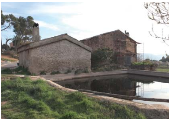
Foto 7. Façana nord dels volums 2 i 1.
