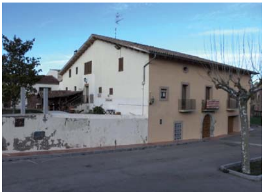
Foto 13. Façana sud volum 1.
