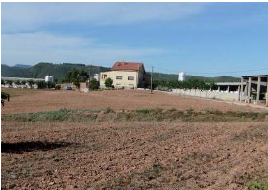
Foto 5. Façana est del volum 1.
