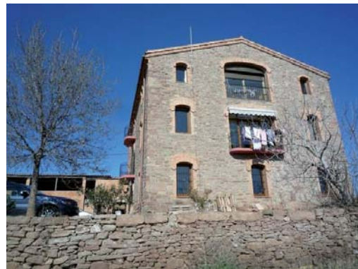
Foto 8. Façana sud del volum 1.
