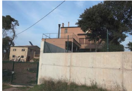
Foto 2. Façana sud - oest del volum 1. On es veu part de la edificació no legalitzada
