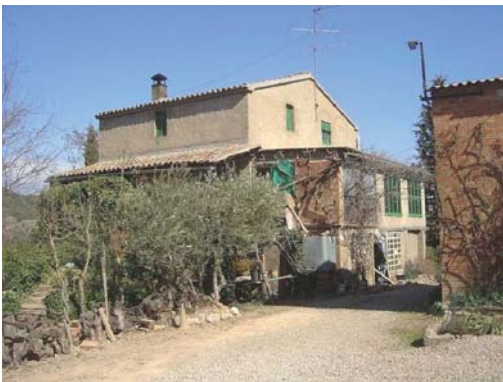
Foto 3. Façana sud - oest del volum 1.
