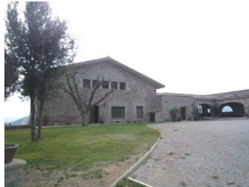
Foto 6. Façana nord del volum 1.
