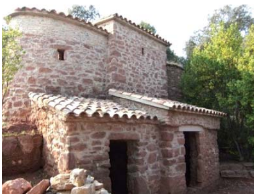
Foto 3. Façana est del volum 2
