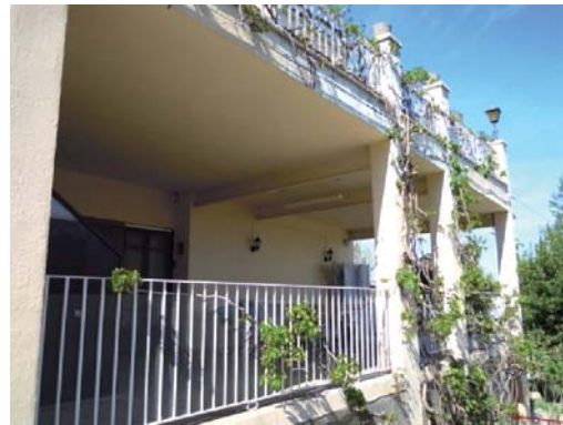
Foto 2. Façana sud del volum 1, vista del porxo.
