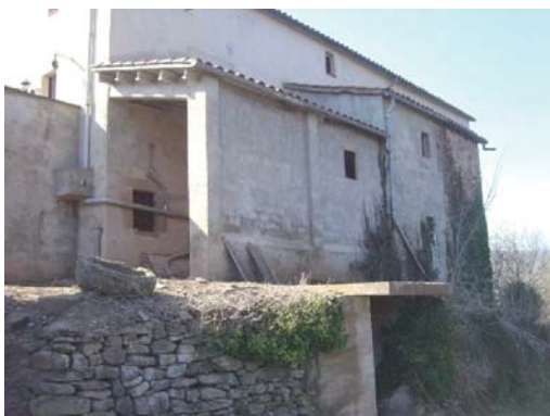
Foto 7. Façana nord del volum 1.
