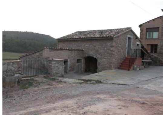
Foto 10. Façana est del volum 2.
