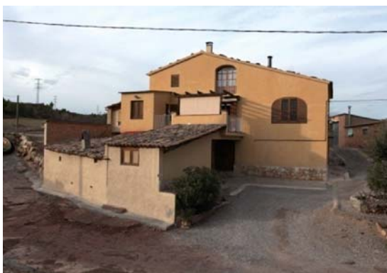
Foto 1. Façana sud dels volums 1 i 3.
