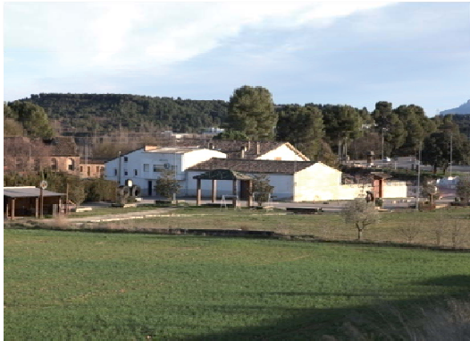
Foto 1. Façana nord del volum 1
