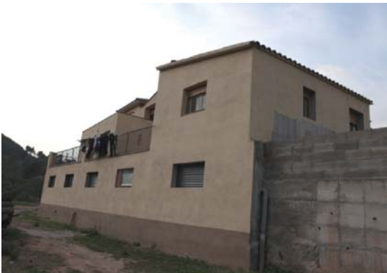
Foto 5. Façana sud del volum 1.
