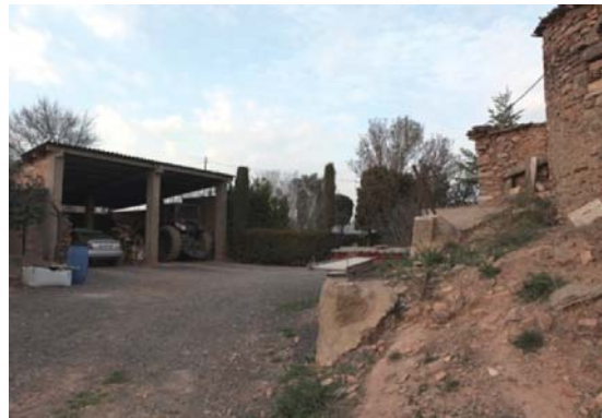
Foto 10. Vistes a altres edificacions auxiliars.
