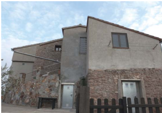
Foto 5. Façana nord dels volums 1 i 2
