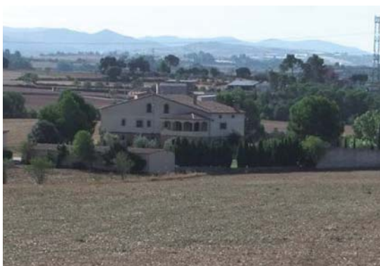
Foto 1. Façana nord dels volums 2, 3 i 1
