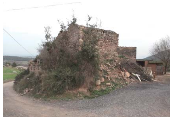
Foto 6. Façana oest del volum 2.
