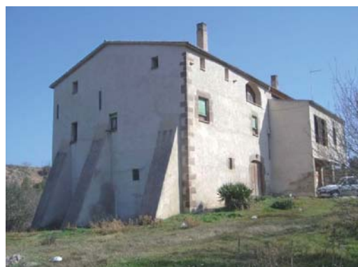
Foto 2. Façana sud del volum 1 i oest de Cal Tinarro.
