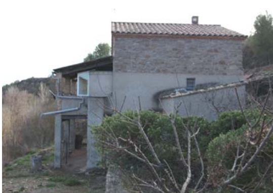
Foto 3. Façana nord dels volums 1 i 2.
