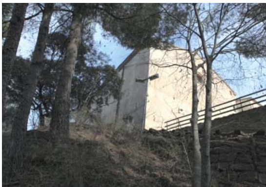
Foto 7. Façana nord - est del volum 1.
