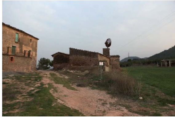
Foto 16. Façana nord del volum 3.
