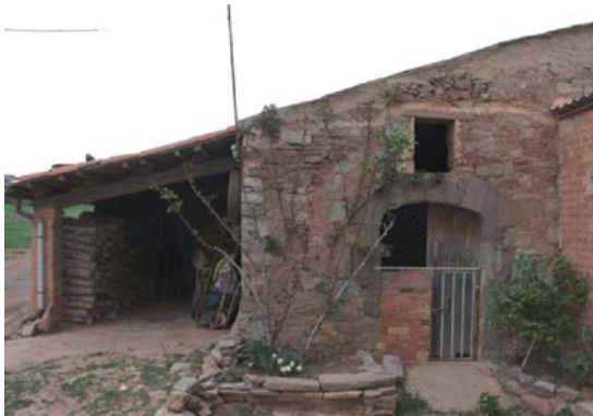
Foto 3. Façana sud del volum 1.
