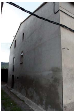
Foto 5. Façana sud del volum 1.
