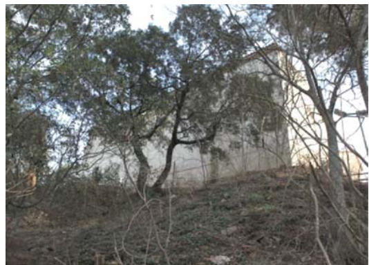
Foto 8. Façana nord del volum 1.
