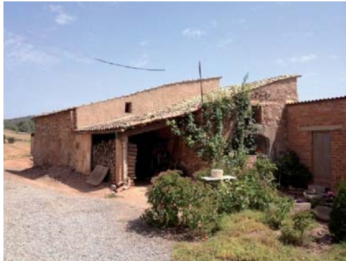
Foto 1. Façana sud - oest del volum 1.
