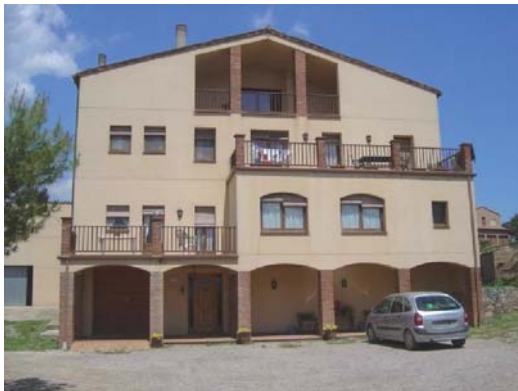
Foto 1. Façana sud del volum 1.
