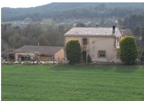
Foto 3. Façana est dels volums 2 i 1.
