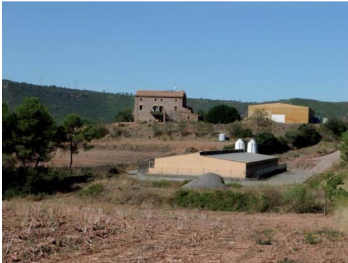
Foto 1. Façana est dels volums 1 i 2.
