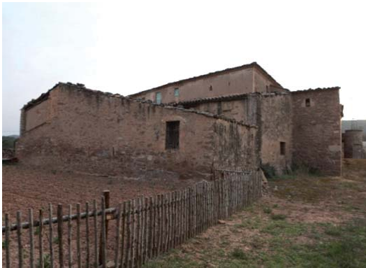
Foto 9. Façana est del volum 2.
