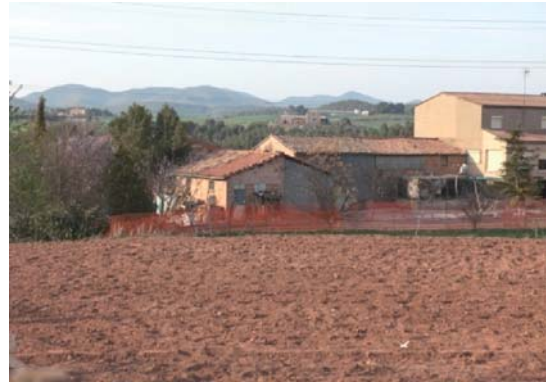
Foto 2. façana sud - oest del volum 2.
