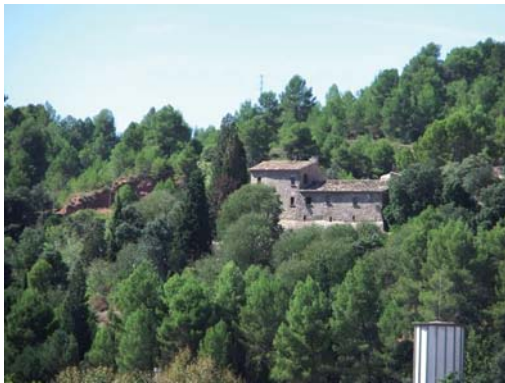
Foto 1. Façana est del volum 1
