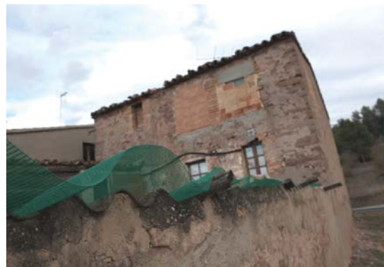
Foto 6. Façana sud - oest del volum 1.
