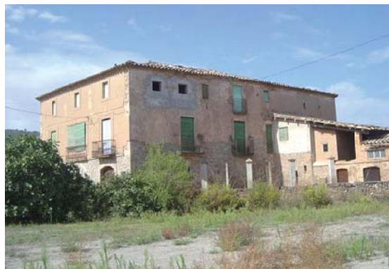
Foto 4. Façana est del volum 1.
