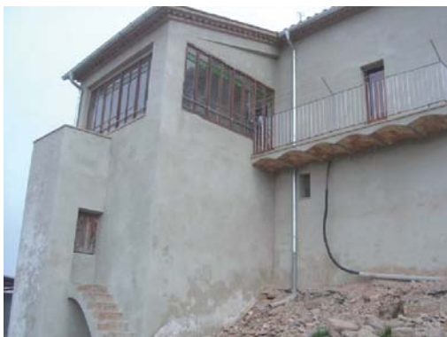
Foto 7. Façana sud - oest del volum 1.
