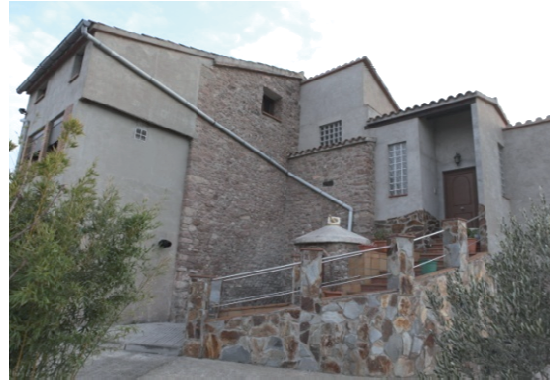
Foto 8. Façana nord del volum 1.
