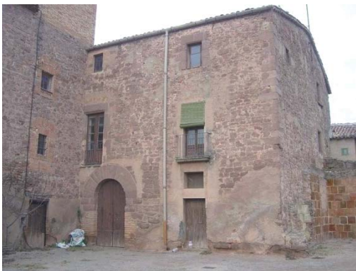
Foto 5. Façana est del volum 1.
