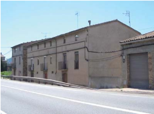
Foto 1. Façana nord - est del volum 1.
