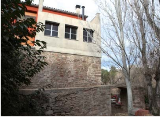
Foto 7. Façana sud del volum 1.
