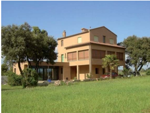
Foto 1. Façana sud del volum 1. On es veu part de la edificació no legalitzada
