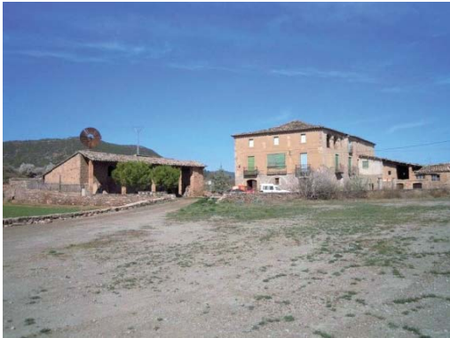
Foto 1. Façana sud dels volums 1, 2 i 3.
