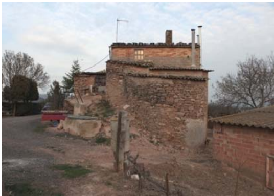
Foto 9. Façana oest del volum 1.
