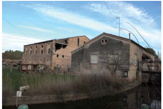
Foto 20. Façana nord - oest volum 2 i 1.
