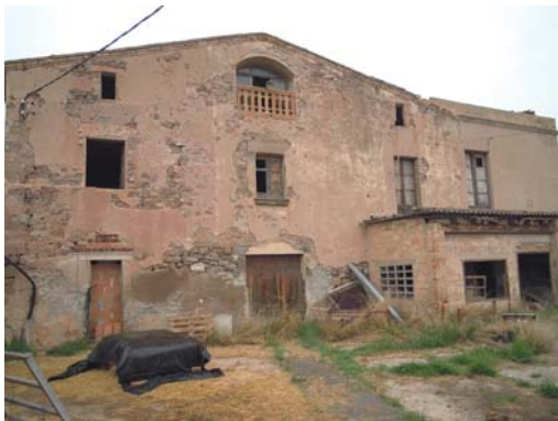
Foto 3. Façana sud dels volums 1 i 3.
