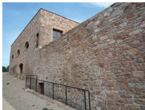
Foto 2. Façana oest del volum 1.
