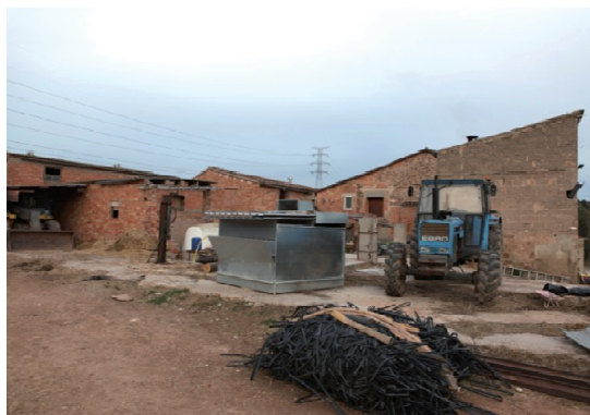
Foto 4. Façana oest dels volums 1, 2 i 3.
