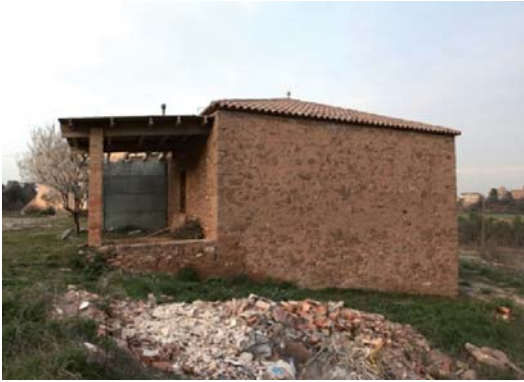
Foto 5. Façana sud del volum 4.
