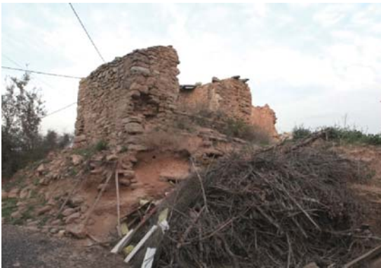
Foto 17. Façana sud del volum 2.
