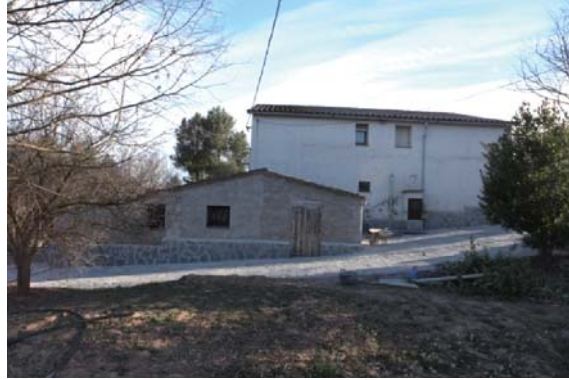
Foto 8. Façana nord dels volums 2 i 1.
