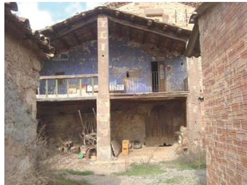
Foto 6. Façana sud del pati interior del volum 3.
