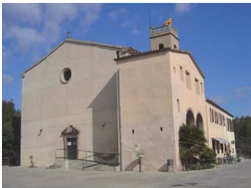
Foto 3. Façana sud - oest del volum 1
