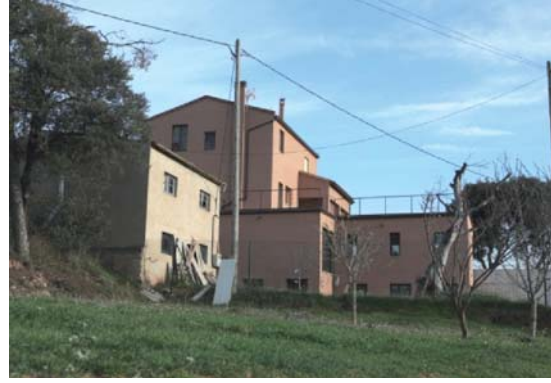
Foto 8. Façana nord - est del volum 1. On es veu part de la edificació no legalitzada
