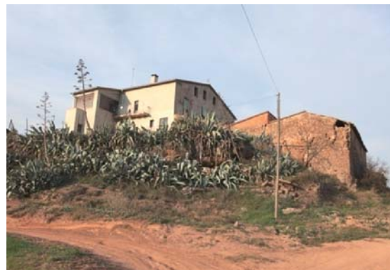
Foto 16. Façana sud del volum 1.
