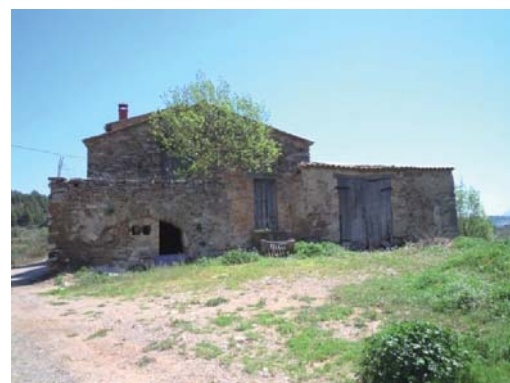
Foto 4. Façana oest dels volums 2, 3 i 1.
