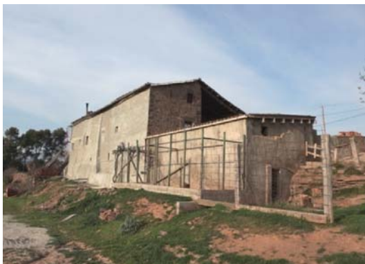
Foto 5. Façana sud - oest del volum 1.
