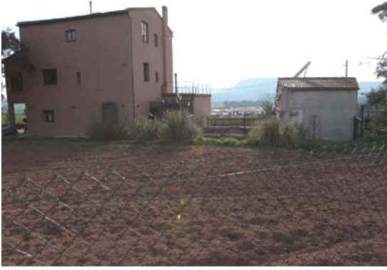
Foto 7. Façana est del volum 1.
