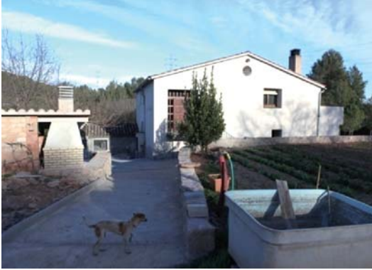
Foto 7. Façana oest dels volums 1 i 2.
