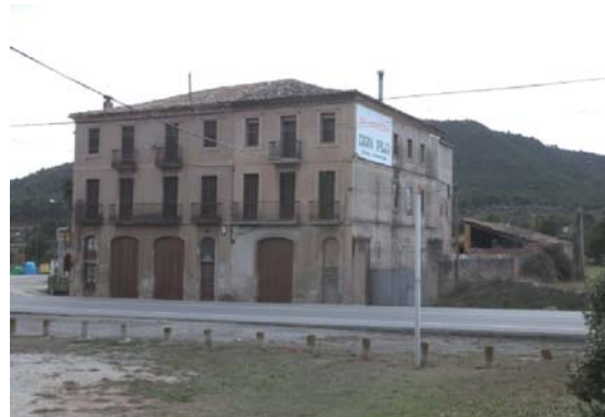
Foto 4. Façana nord - est dels volums 1 i 2.
