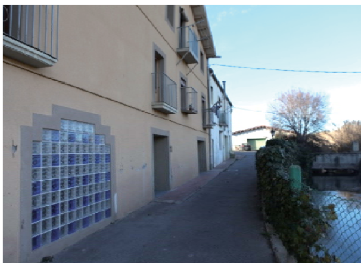
Foto 3. Façana est del volum 1.
