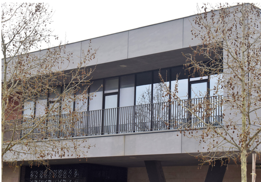
Façana de l'edifici del Viver d'Empreses
