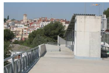
Ascensor a Centre Esportiu
