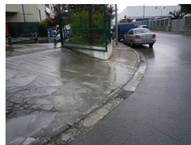
Entrada amb rampa a la Deixalleria
