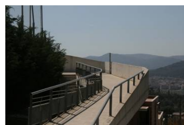
Rampa accés secundari al Centre Esportiu el Papiol
