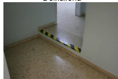
Graó aïllat al Dispensari
