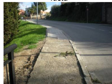
Vorera sense paviment d'acabat per obres puntuals durant la recollida de dades. Actualment aquest tram ja està pavimentat
