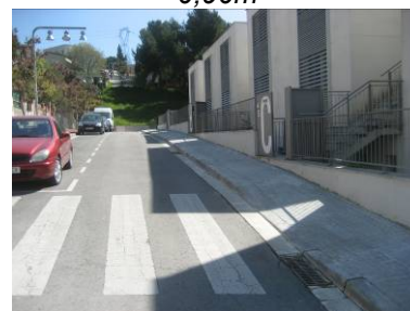
Ample de pas lliure inferior a 0,90m per gual de vianants
