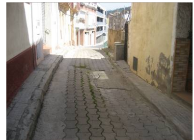
Voreres d'ample inferior a 0,90m
