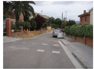
Tram en obres
