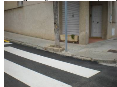
Arbre mal ubicat a eix de creuament
