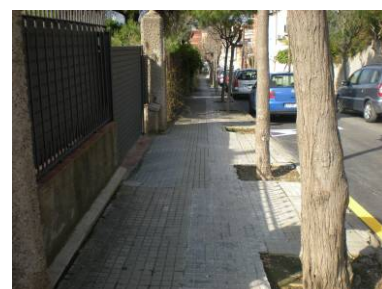
Pas inferior a 0,90m per pendent transversal >2%
