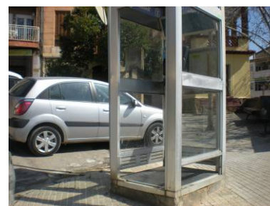
Cabina telefònica mal dissenyada i pendent d'eliminar
