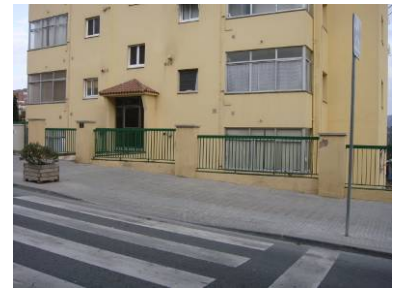
Gual de barca sense paviment d'invidents
