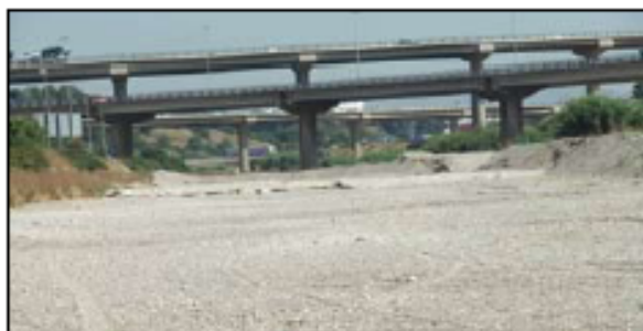
Viaductes en el tram final de la riera de Rubí.
