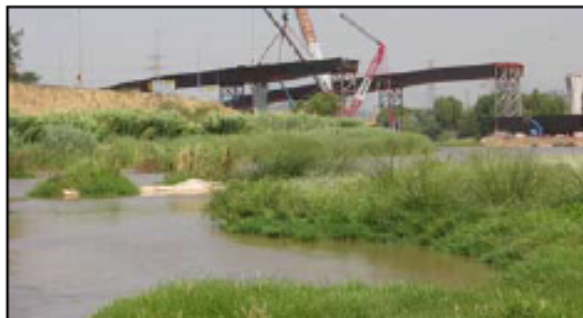
Construcció del nou viaducte d'enllaç entre l'A2 i l'AP-7.
