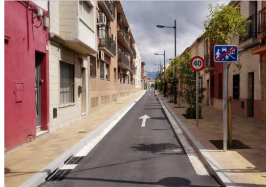
Exemple d'un altre municipi de l'estrenyiment de calçada
