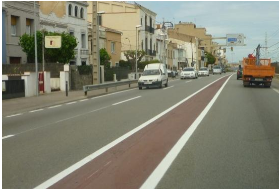
Exemple d'un altre municipi, en que s'ha establert una mitjana pintada, estrenyent els carrils de circulació.
