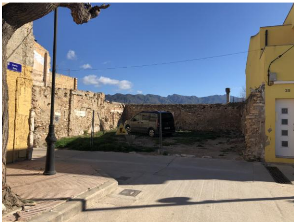
Restes d'edificació existent
