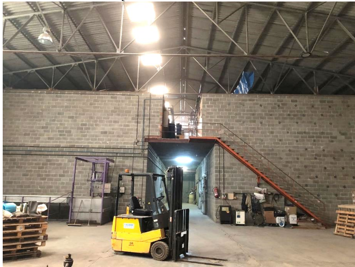
VISTA CAMBRES FRIGORÍFIQUES DES DE LA ZONA DE PRODUCCIÓ. PASSADÍS I ALTELL TÈCNIC.
