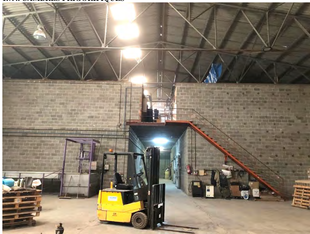
VISTA CAMBRES FRIGORÍFIQUES DES DE LA ZONA DE PRODUCCIÓ. PASSADÍS I ALTELL TÈCNIC.
