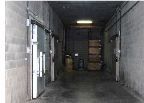
PASSADÍS ACCÉS CAMBRES, SOTA L'ALTELL TÈCNIC.
