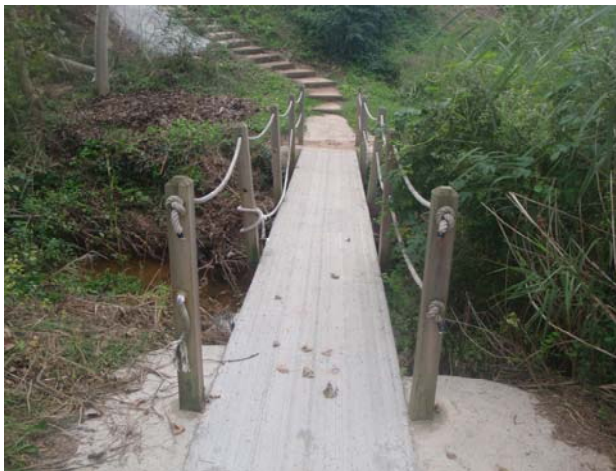
Accés a nucli urbà. En el cas de la fotografia l'accés es fa per un pont seguit d'un tram d'escales, inaccessible.
