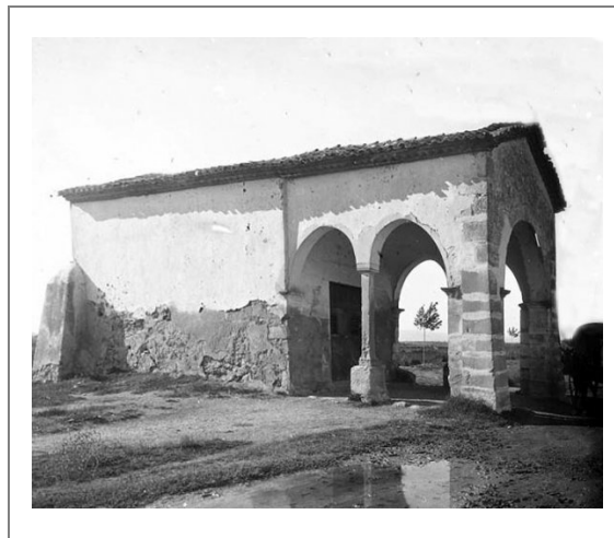
Estat constructiu abans de la restauració
