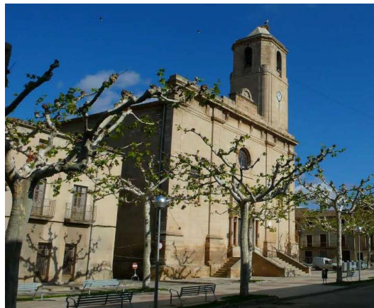
Vista de la façana principal i la plaça
