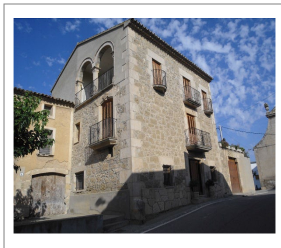
Façana principal i façana Sud
