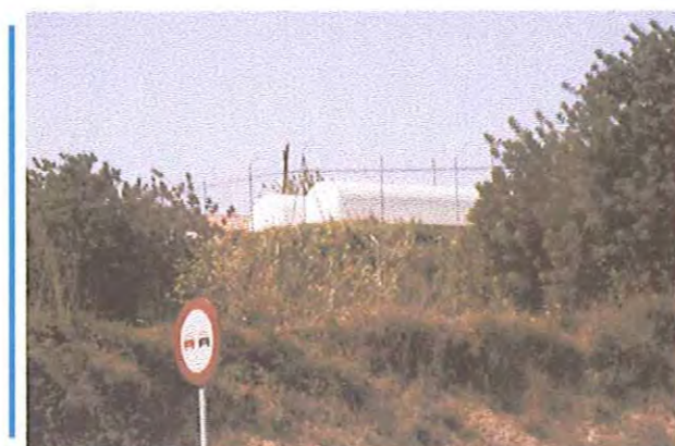
Dipòsits de combustible. El seu impacte visual es pot evitar fàcilment amb una pantalla visual de vegetació.
