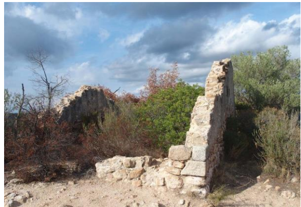
Estat actual de la torre de guaita que hi ha a la part més alta del castell
