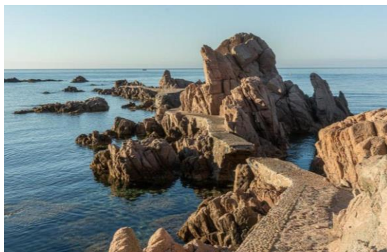
Vista dels ponts de la cala de Canyet després del temporal Glòria.
