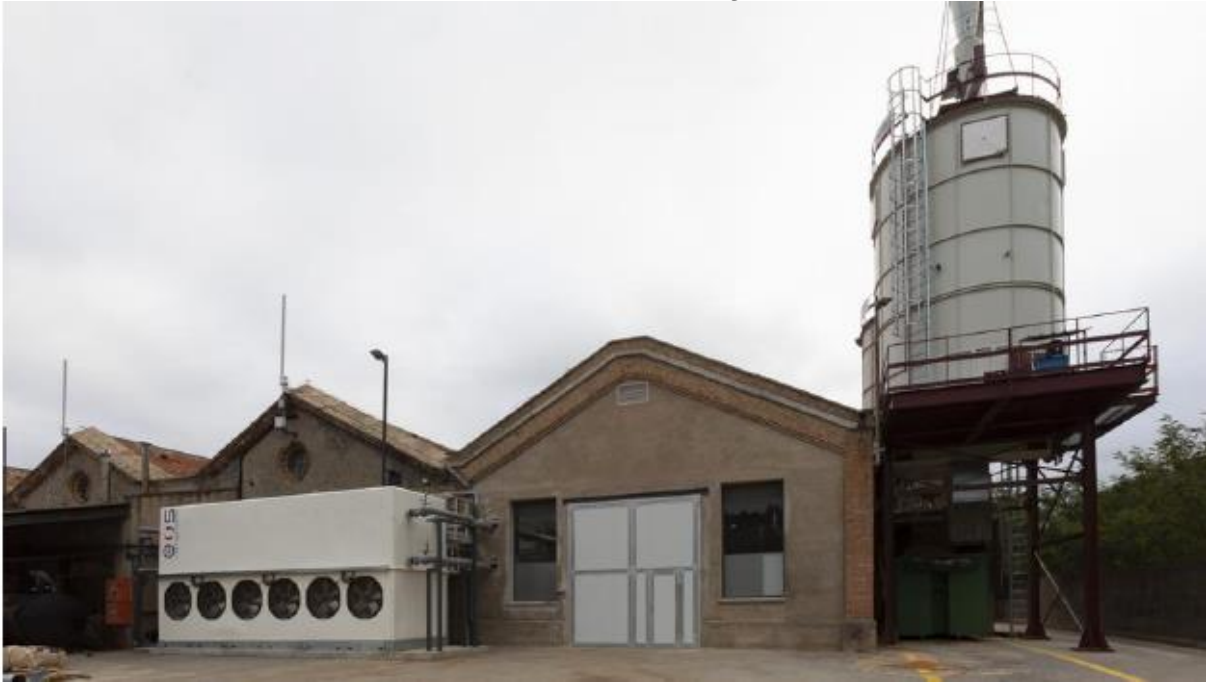
Fotografia de l'estat actual de la façana
