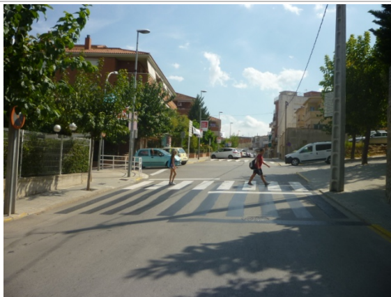
Imatge 50. Pas de vianants modificat però encara desplaçat respecte les voreres que connecta.
