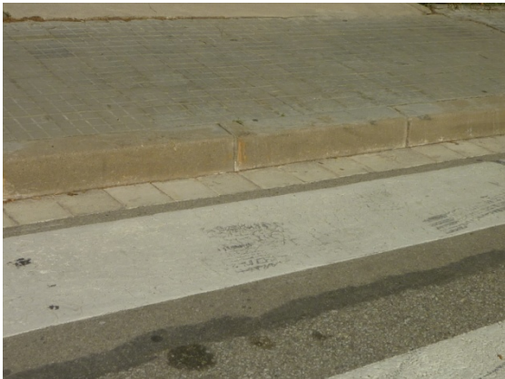
Imatge 15. Pas de vianant sense rampa entre calçada i vorera. Carrer Josep Fusalba.
