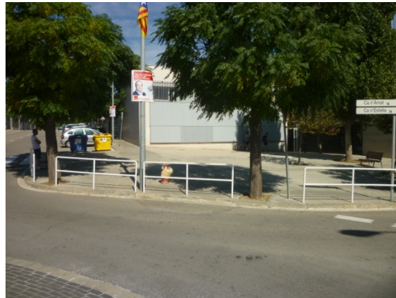
Imatge 42. Barana per guiar el vianant fins el pas. La barana hauria d'acabar de tancar el pas.
