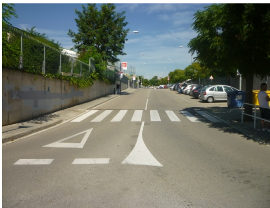
Imatge 43. Ramal de Josep Llobet i Bonastre, amb el pas i la barana que evita el pas recte dels vianants. Bona mesura.
