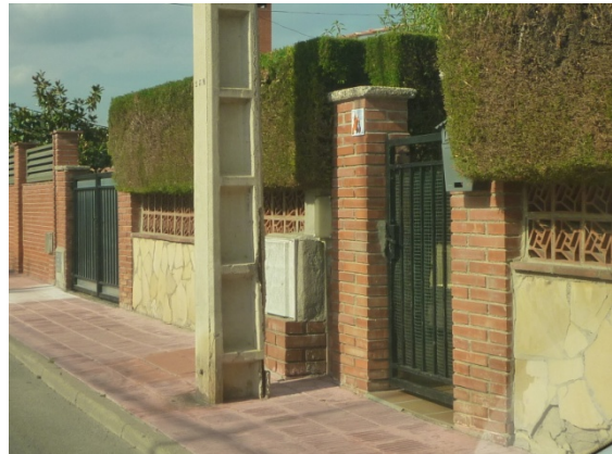
Imatge 16. Columna de subministrament que inhabilita l'espai de vorera. Carrer Constitució.
