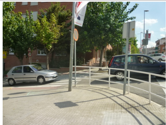
Imatge 51. Barana que guia els vianants fins el pas que travessa av. Montserrat.
