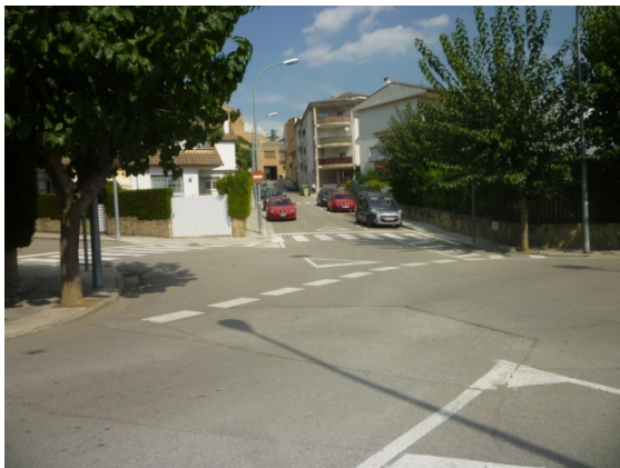
Imatge 47. Rotonda a l'av. del Bon Repòs. Ramals confluents just en la zona d'incorporació a l'anella.
