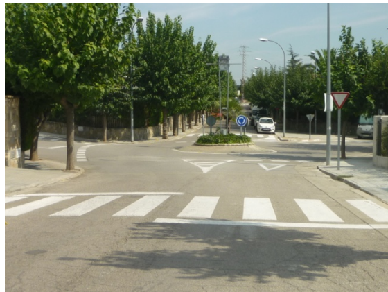
Vista del ramal de Bon Repòs cap al carrer del Sucre. Poc efecte reductor i pas de vianants lluny..
