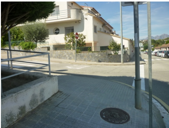
Imatge 17. Pas de vianants desplaçat respecte les voreres que connecta. Carrer de l'Alba.
