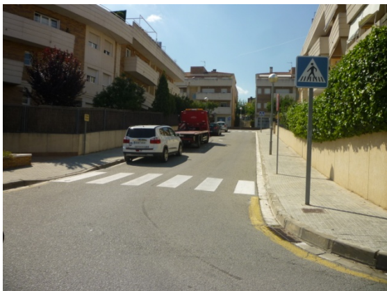
Imatge 13. Pas amb vorera deprimida per facilitar l'accessibilitat. Carrer de la Gleva.
