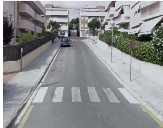
Imatge 40. Carril de circulació de fins a 4,0 m. Caldria pintar la filera d'estacionament més ample (fins a 2,5m). Carrer de la Gleva.
