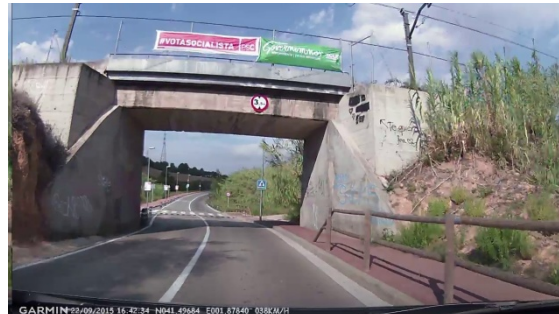
Imatge 72. Passat el pont, hi ha una doble banda reductora.
