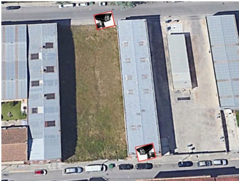
CARRER CÒRDOVA I RONDA ANOIA, 2 CÀMERES NOU EDIFICI BRIGADA D' OBRES 41.580021135817844, 1.6039837496347833
