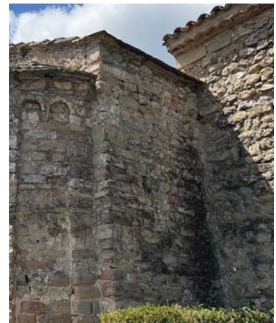
Façana nord de l'absidiola nord
