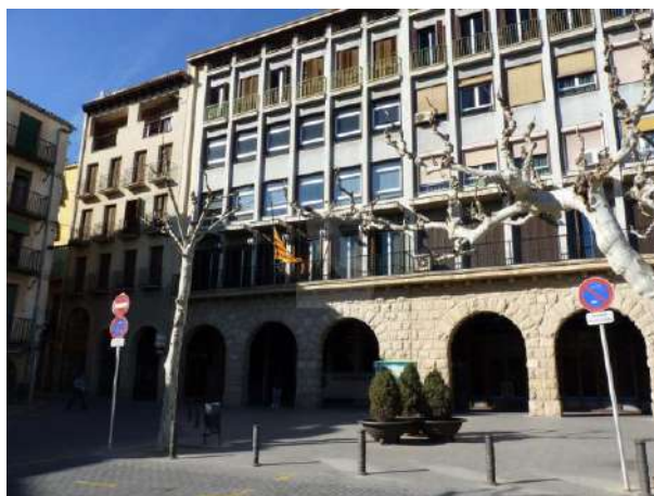
Fotografia façana principal de l'Ajuntament
