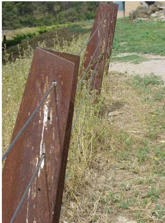
Detalls dels peus de xapa de ferro corten plegada
