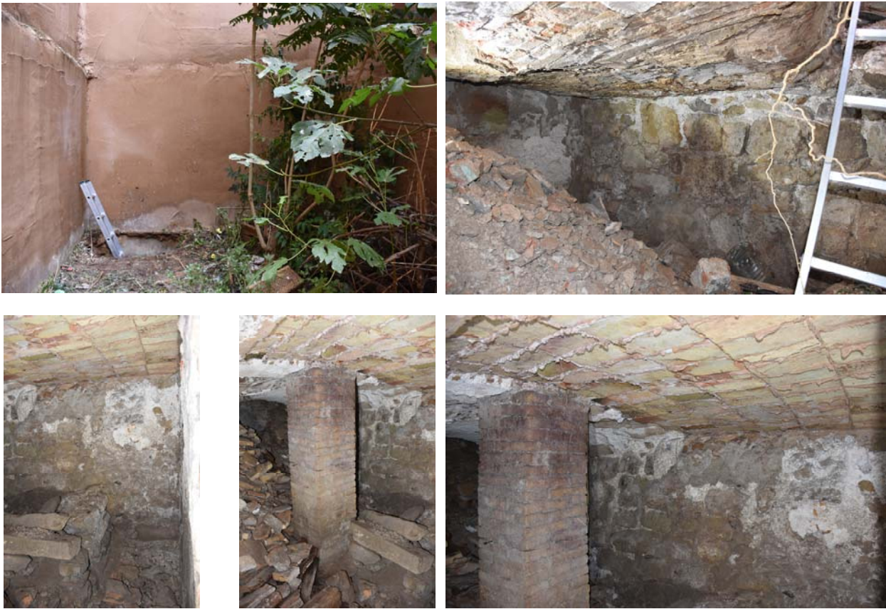
Imatges des de l'interior del celler existent en el pati
