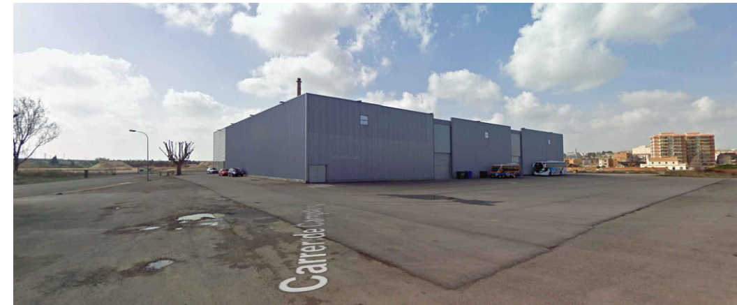
Imatge 1. Exterior pavelló inpacsa
