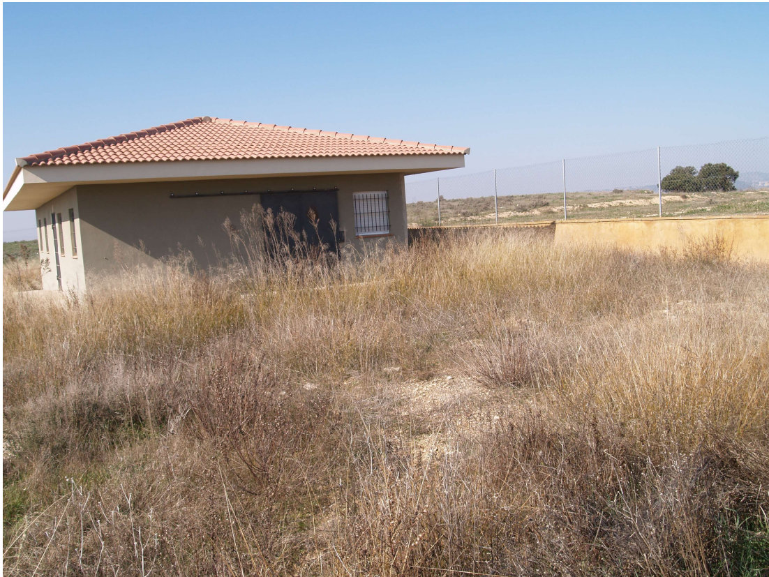
Caseta de serveis (porta accés a la sala d'instal·lacions)
