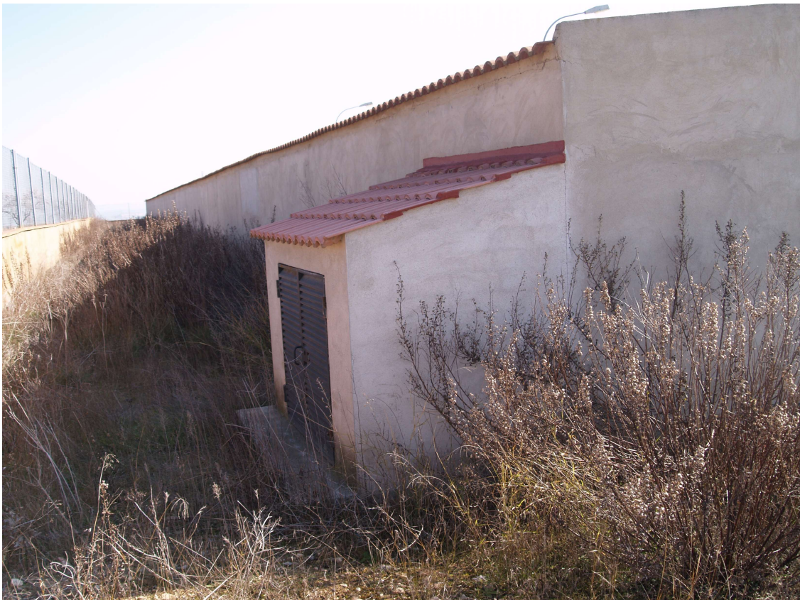
Caseta d'ubicació del grup electrògen
