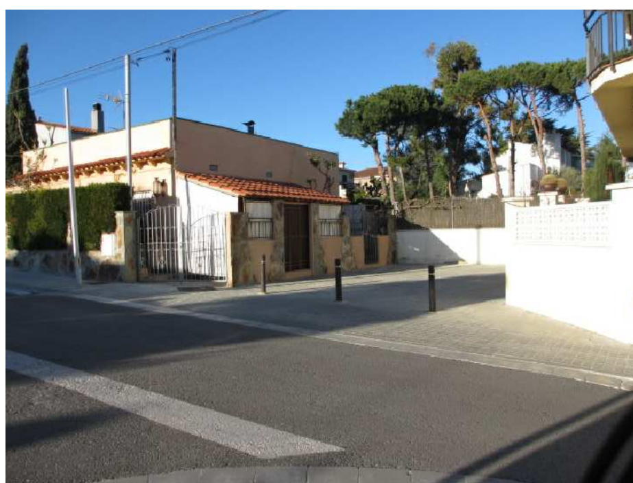
FOTOGRAFIA 5 - Vista general del tram del carrer de la Vall d'Aran ja reurbanitzat
