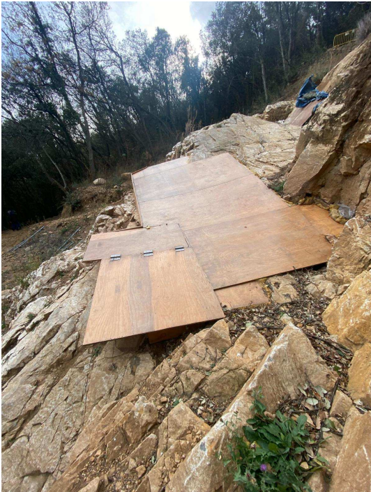
Fotografia 4. Vista de la coberta de fusta present a l'àmbit del projecte.
