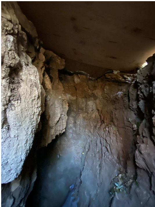
Fotografia 26. Vista de l'interior de la cova.
