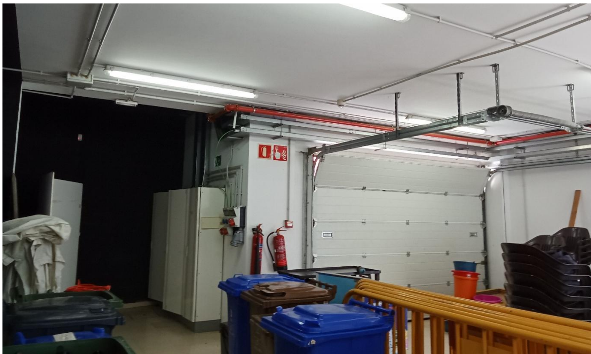
Figura 6. Imatges del Poliesportiu objecte del projecte. Font: elaboració pròpia.
