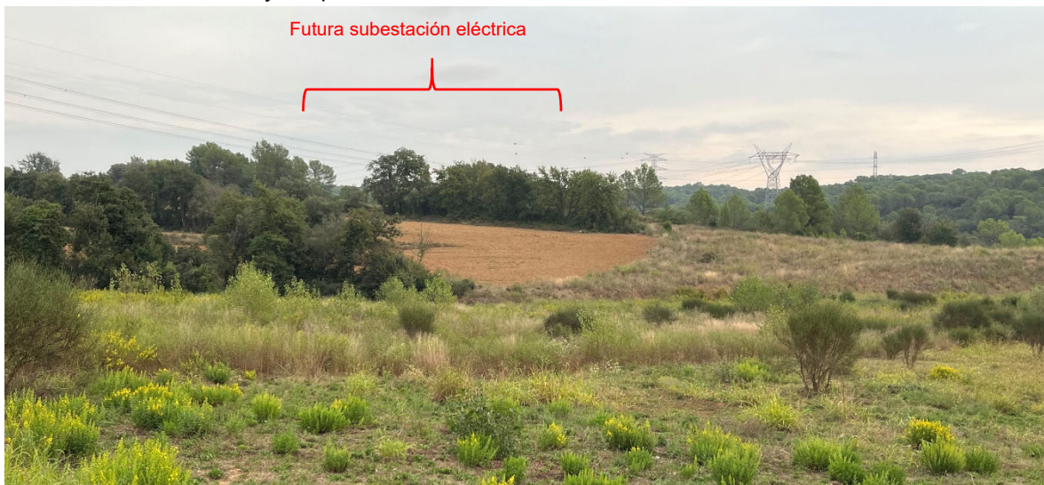
- Visual hacia el norte desde el exterior de la subestación de Red Eléctrica
