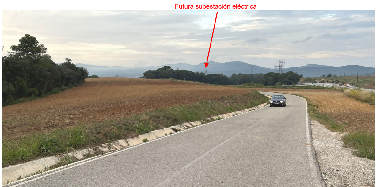
Visual desde el Taller mecánico hacia la futura subestación eléctrica colectora
