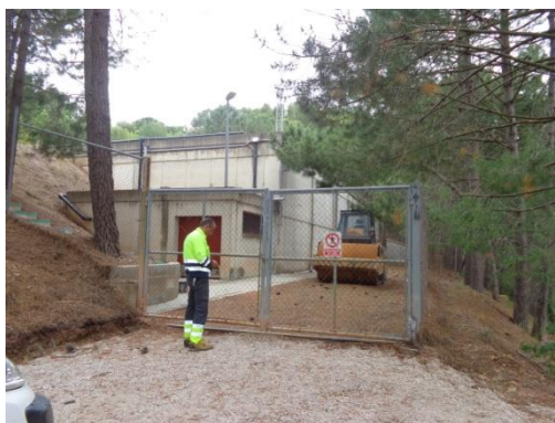
Fotografia 45. Vista general Dipòsit St. Miquel
