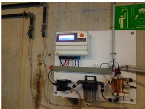
Fotografia 58. Cloració automàtica Dipòsit St. Miquel
