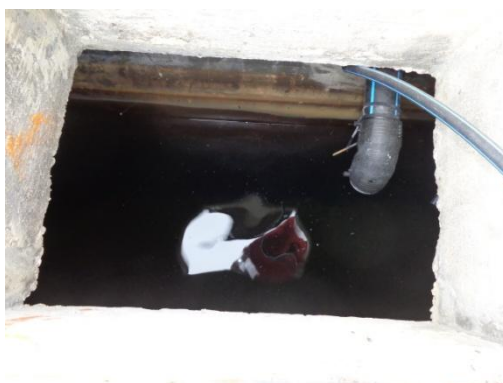
Fotografia 62. Conducció arribada Dipòsit Les Masies
