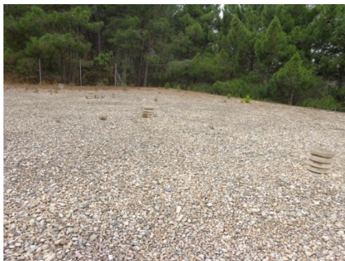
Fotografia 55. Coberta i ventilacions Dipòsit St. Miquel
