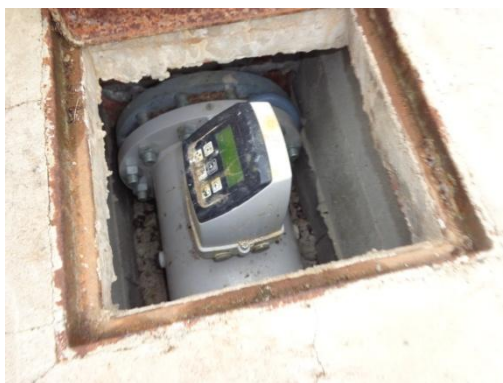
Fotografia 50. Comptador sortida Dipòsit St. Miquel
