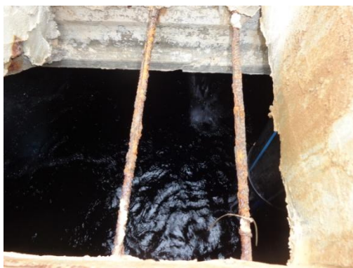
Fotografia 51. Interior i sondes Dipòsit St. Miquel
