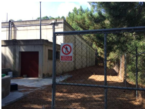
Fotografia 46. Vista general Dipòsit St. Miquel
