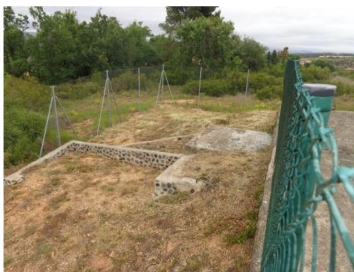
Fotografia 44. Vista exterior Dipòsit La Cometa
