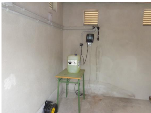
Fotografia 31. Bomba dosificadora i clor pou Casal
