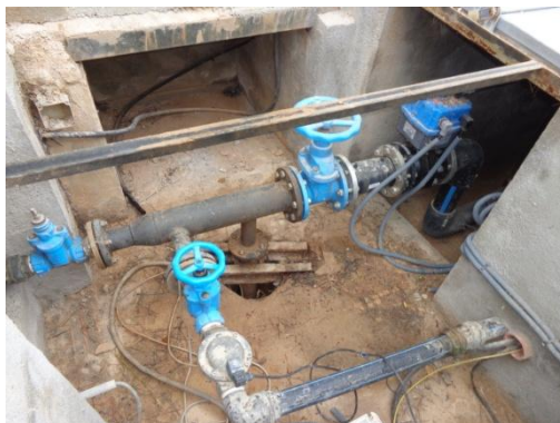
Fotografia 25. Caldereria, valvuleria i comptador pou Garber
