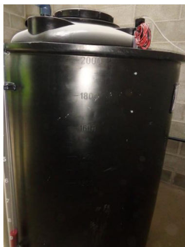
Fotografia 66. Emmagatzematge clor Dipòsit Les Masies
