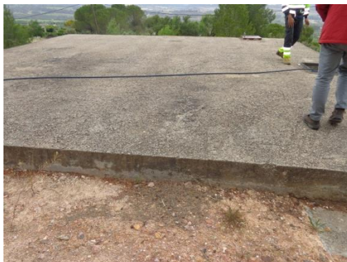
Fotografia 61. Coberta Dipòsit Les Masies
