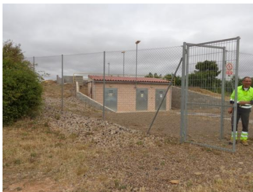
Fotografia 33. Vista general Dipòsit La Cometa
