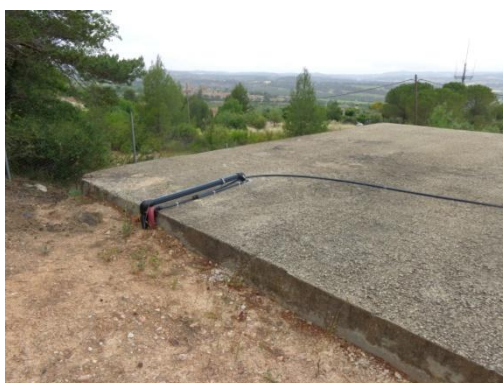
Fotografia 60. Coberta i conduccions arribada Dipòsit Les Masies
