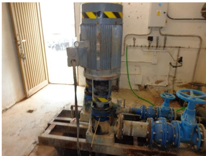
Bombament pou de la Biela
