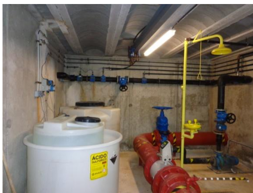
Fotografia 57. Emmagatzematge de clor i mesures seguretat Dipòsit St. Miquel
