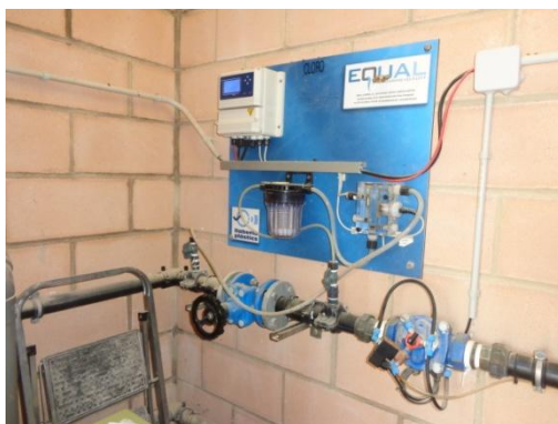
Fotografia 42. Cloració automàtica Dipòsit La Cometa
