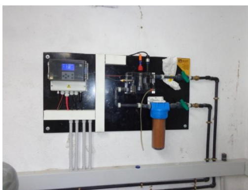
Fotografia 30. Analitzador cloració pou Casal
