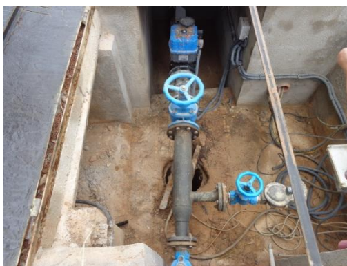
Fotografia 26. Conducció impulsió i vàlvules pou Garber
