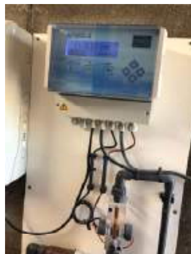
Figura 12 Sistema de cloració al dipòsit gran (font: pròpia)
