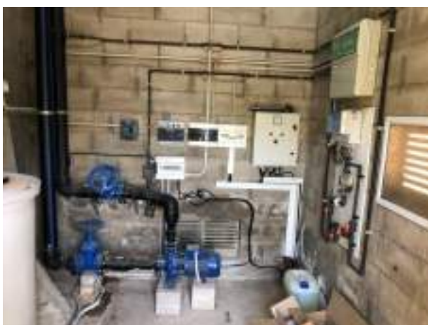
Figura 12 Sistema de cloració al dipòsit gran (font: pròpia)
