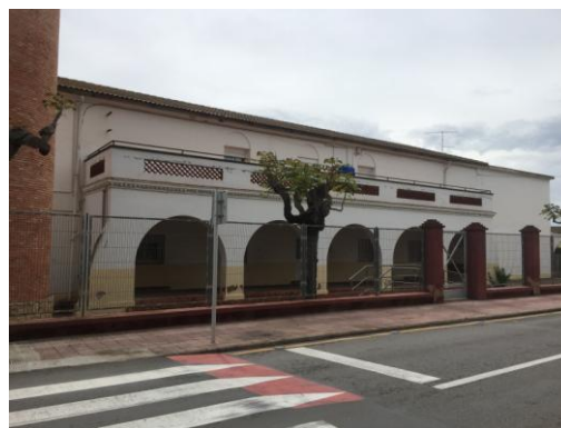
Figura 2. Façana principal de l'edifici
