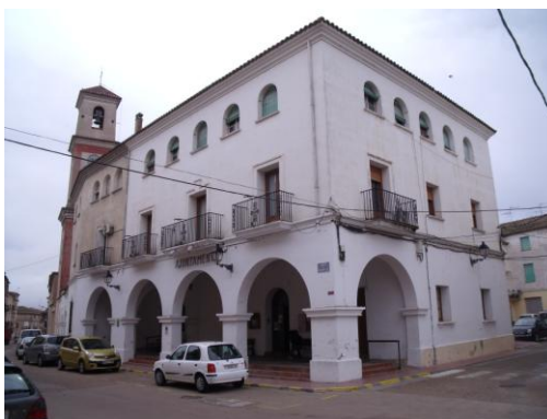
Figura 9. Façana exterior edifici
