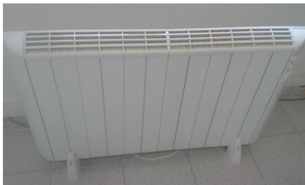
Figura 3. Unitats terminals radiadors elèctrics
