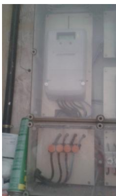
Figura 7. Comptador elèctric
