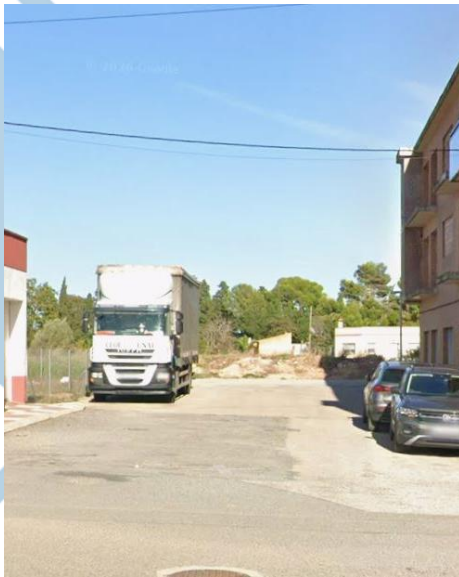
Imatge 14. Estat actual asfalt sector 3. Font: Elaboració pròpia.
