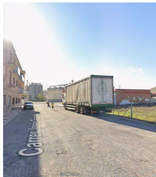
Imatge 15. Estat actual asfalt sector 3. Font: Elaboració pròpia
