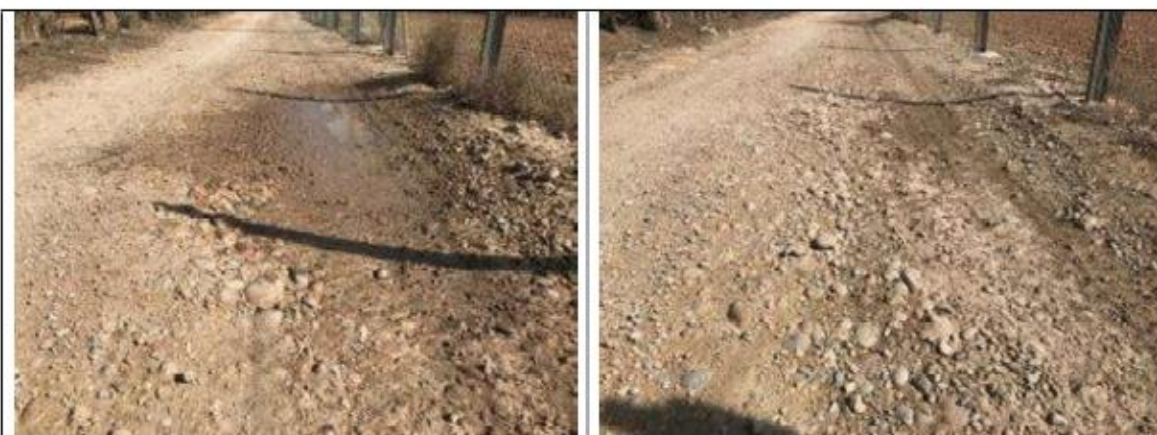
Aspecte camí finca Burjassènia
