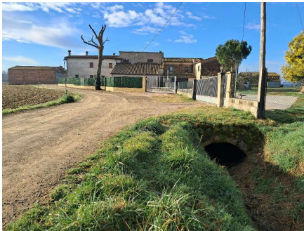
Figura 15. Fotografia 11 estat actual camí de la Granyana
