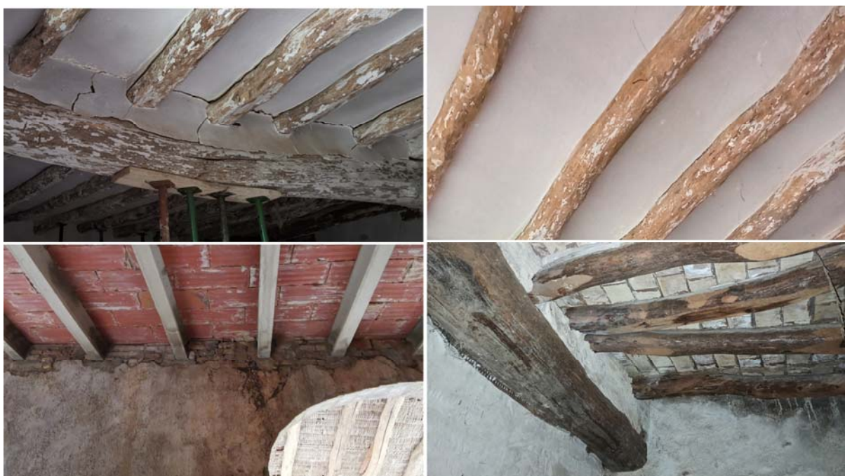
Figura 13. Diferents sistemes estructurals horitzontals de la masia. Elaboració pròpia
