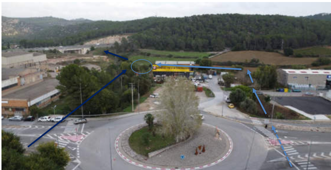
Fotografia xxx. vista en sentit O-E que permet observar la diferència de magnitud entre el torrent del Pla de Bosc (fletxa blau fort) a l'esquerra, que separa el PAU-2 del PAU-1, i el torrent de can Deus (fletxa blava) a la dreta, que delimita el PAU-2 pel sud, després de travessar ambdós en un túnel l'Avinguda de Vilafranca (ratlla intermitent). El cercle indica el punt aproximat on el torrent de can Deus tributa al torrent del Pla de Bosc.
