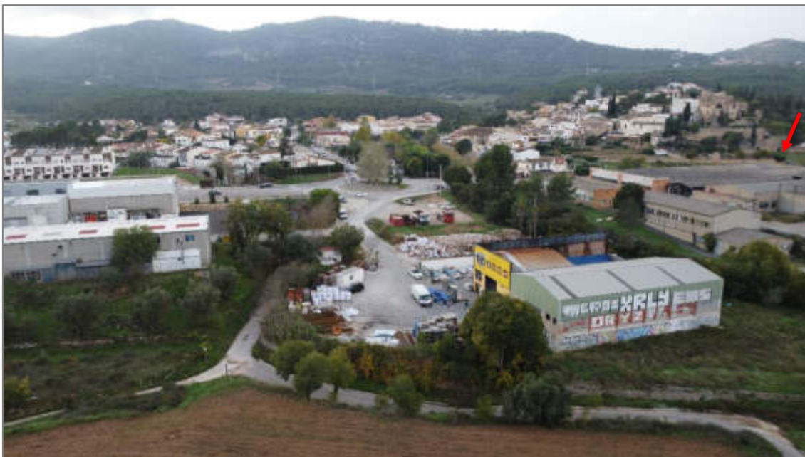
Fotografia 7. Vista SE-NO de l'àmbit PAU-2 amb l'activitat de materials de construcció (Excavacions Álvaro) i el camí de Canyelles a primer pla, i al fons, l'avinguda de Vilafranca. Al fons, el nucli de Canyelles i el castell. Al costat dret de la imatge (assenyalat amb una fletxa), el PAU-1.
