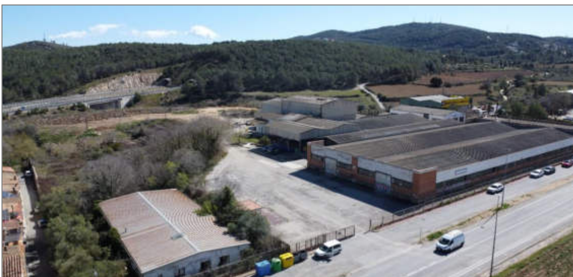
Fotografia 30. Vista NO-SE de l'àmbit PAU-1 Av. Vilafranca 2, amb la carretera C-15z (o avinguda de Vilafranca) a primer terme, i les instal·lacions obsoletes ocupant gran part del sector.
