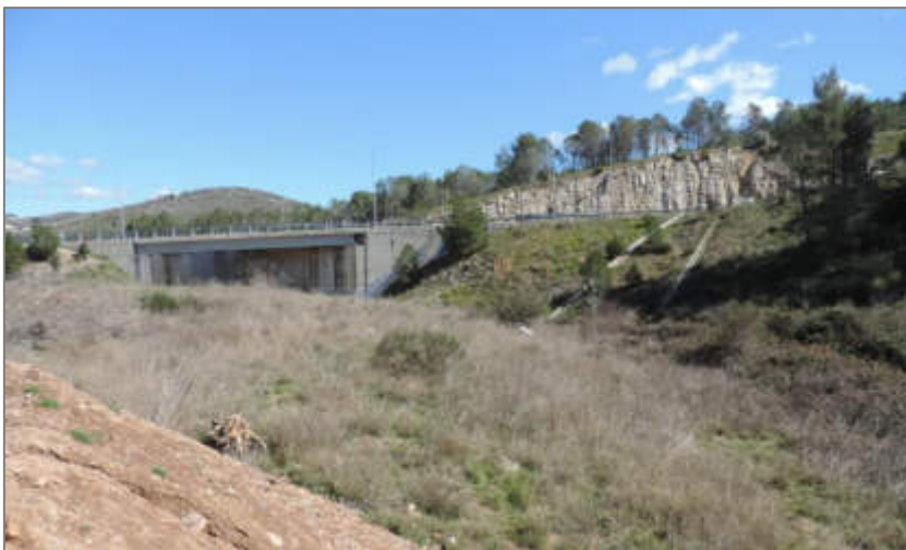
Fotografia 20. Vista E-O amb els talussos que separen l'àmbit PAU-1 del pas del torrent del Pla de Bosc, que transcorre a la dreta. Al fons, el viaducte de la carretera C-15 sobre la riera de Canyelles, just abans d'endinsar-se al túnel de Costa Bernada.
