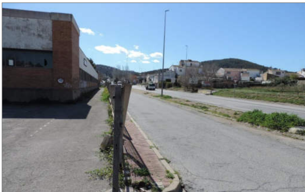
Fotografia 25. Vista de la carretera C-15z, just a l'accés a l'àmbit del PAU-1, a l'esquerra.
