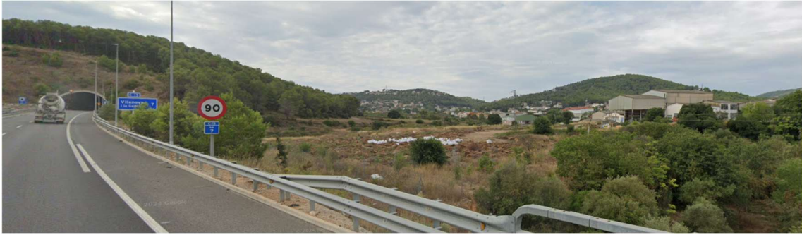
Fotografia 3. Carretera c-15 amb el límit del PAU-1 (Límit nord-est)
