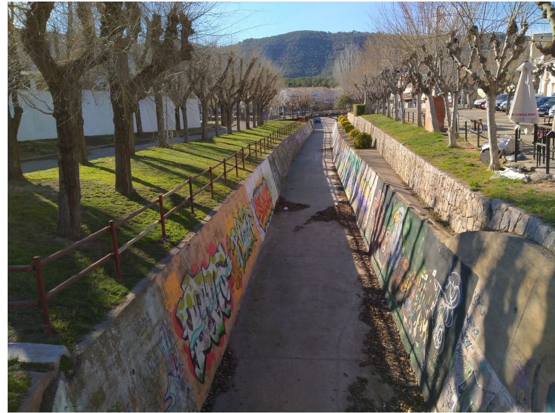
Figura 7: Endegament amb formigó al Torrent del Pla del Bosc, vista cap a aigües amunt
