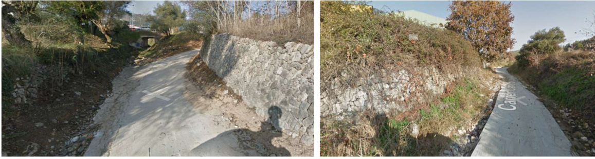
Fotografia 6. Enclavament del torrent de Cal Deus i camí de Canyelles (Límit sud)
