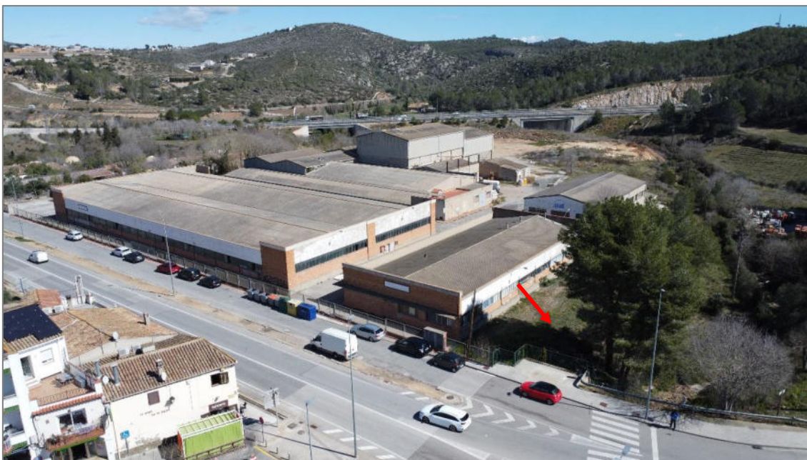
Fotografia 2. Vista SO-NE de l'àmbit del PAU-1 amb l'avinguda de Vilafranca a primer pla, i al darrere, la carretera C-15 abans d'endins-se al túnel de Costa Bernada. Al fons, el Turó del Veguer (261 m). Al costat dret de la imatge (assenyalat amb una fletxa), el PAU-2.
