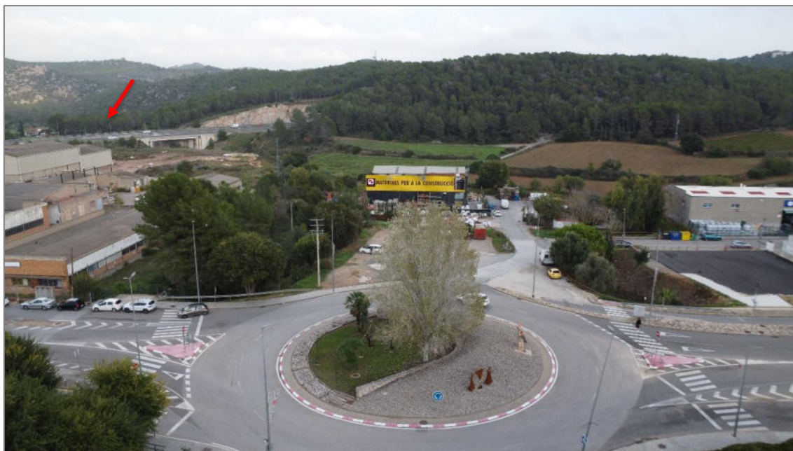
Fotografia 4. Vista O-E del PAU-2 amb l'avgda. de Vilafranca i rotonda de la C-15 a primer pla, i al darrere, l'activitat de materials de construcció (Excavacions Álvaro). Al fons, els vessants nord del Puig del Moro i Puig dels Sumidors. Al costat esquerre de la imatge (assenyalat amb una fletxa), el PAU-1.
