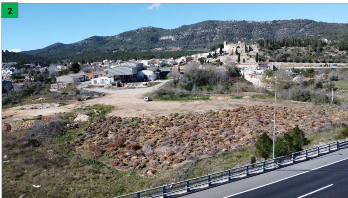
Fotografia 6. Vista E-O de l'àmbit del PAU-1, amb la carretera C-15 i els abassegaments de restes de poda a primer pla.
