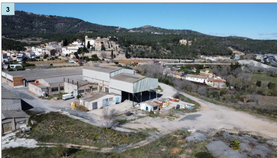
Fotografia 7. Vista SE-NO de l'àmbit del PAU-1 des del sòl nu de l'àmbit, i les instal·lacions obsoletes de l'antiga fàbrica.
