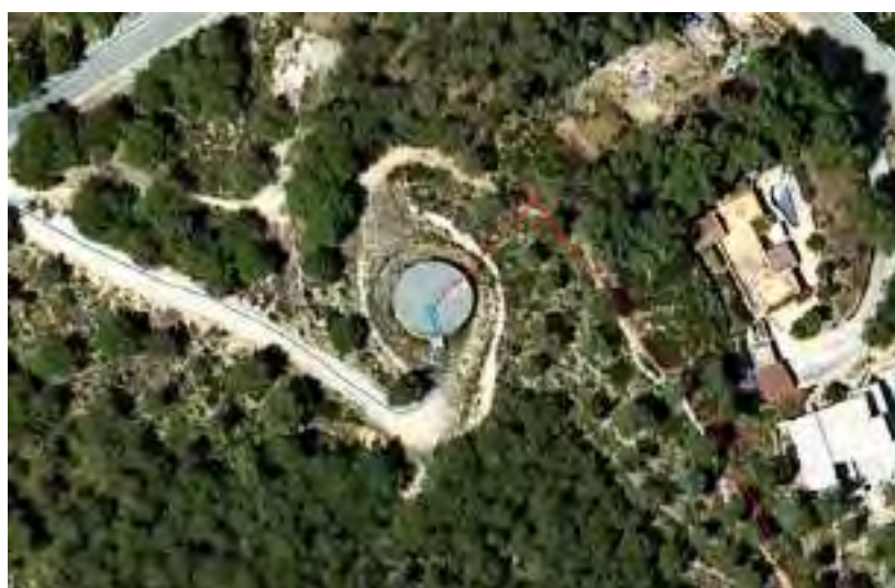
Imatge 24: Ubicació del dipòsit Alt Vora Sitges
