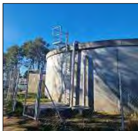
Imatge 15. Dipòsit Palmeres i Muntanya de Mar
