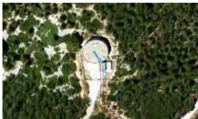
Imatge 29: Ubicació del dipòsit Daltmar
