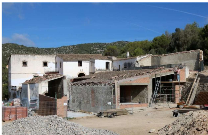
Masia de Cal Ferrer de Llacunalba. Primers treballs de restauració
